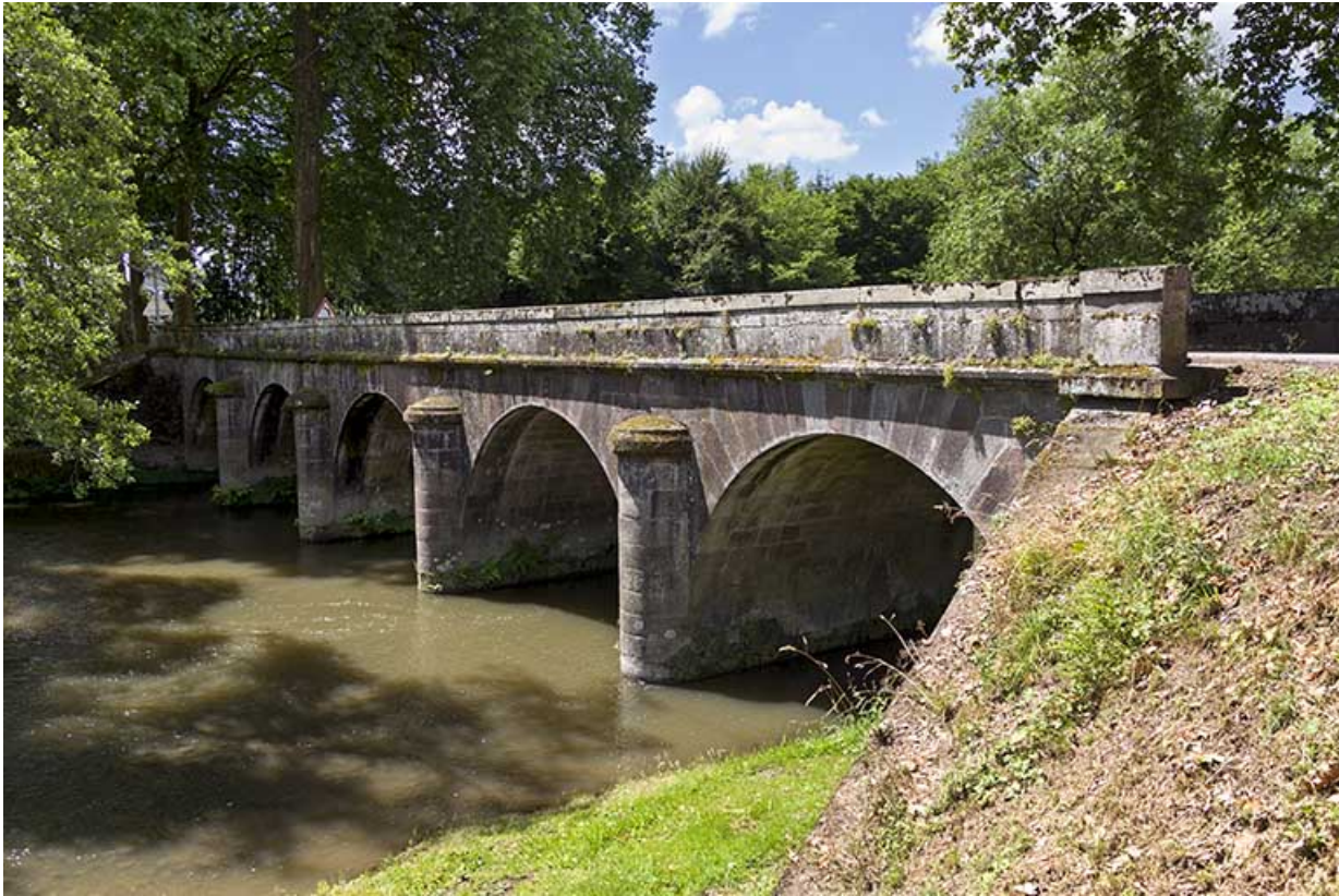
Vue du pont en amont.
