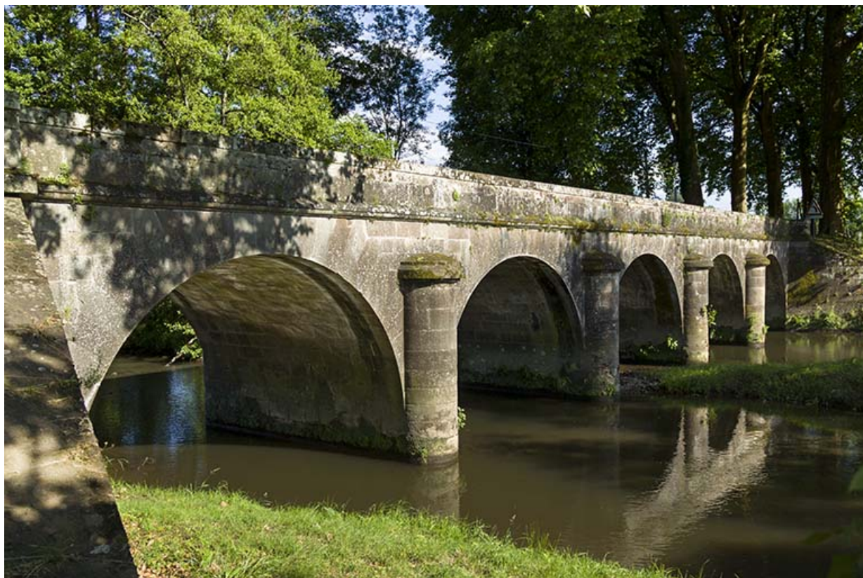
Vue du pont en aval.
