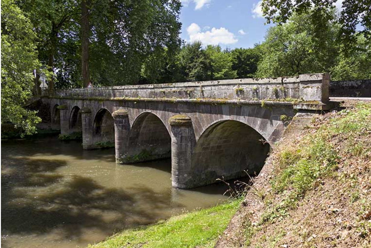
Vue du pont en amont.
