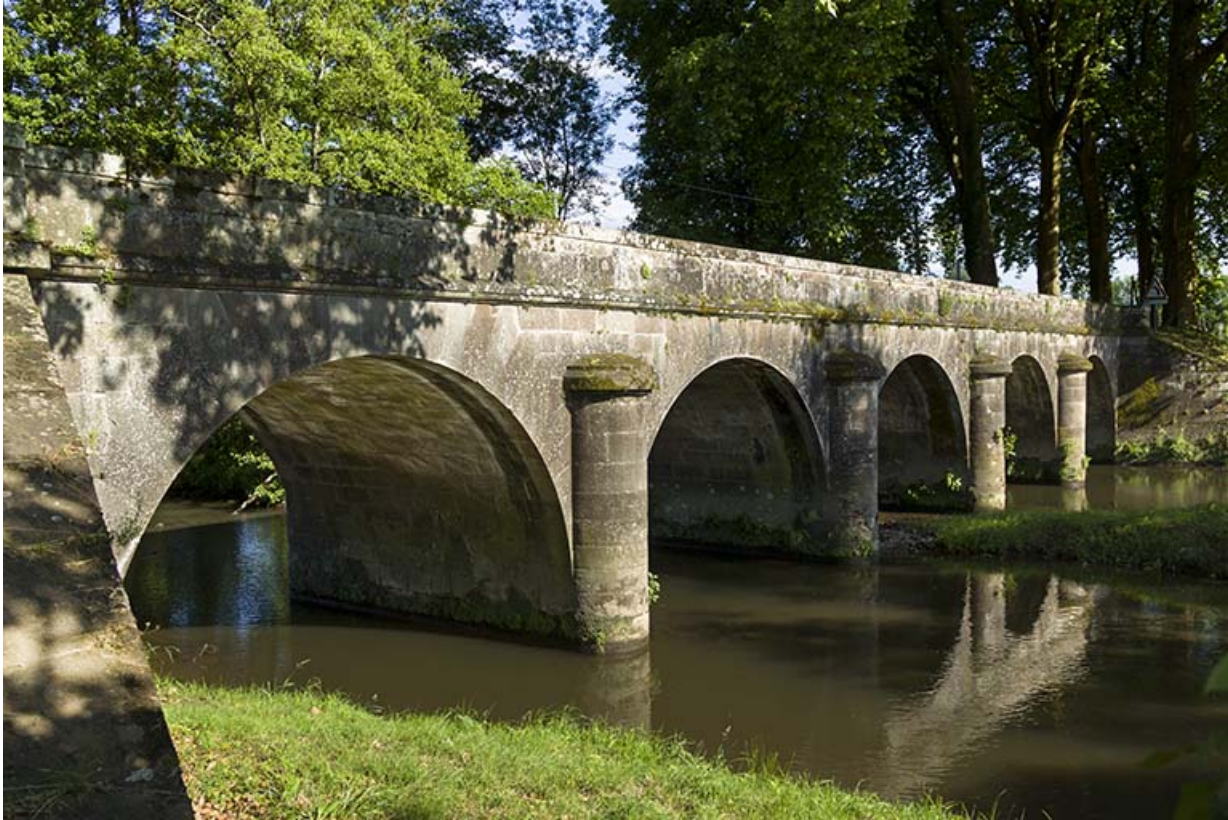
Vue du pont en aval.
