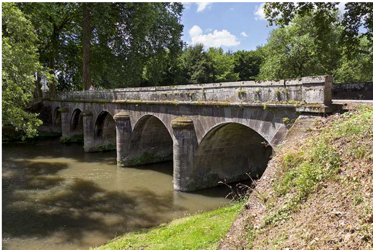
Vue du pont en amont.
