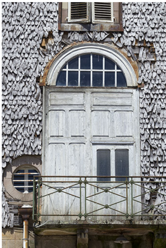
Détail de la porte sur la façade sud.
