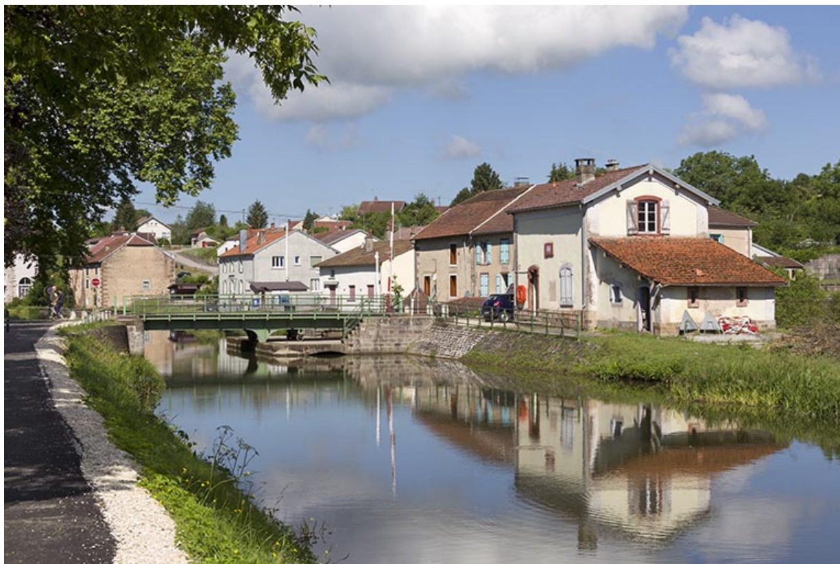
Vue d'ensemble depuis l'amont.
