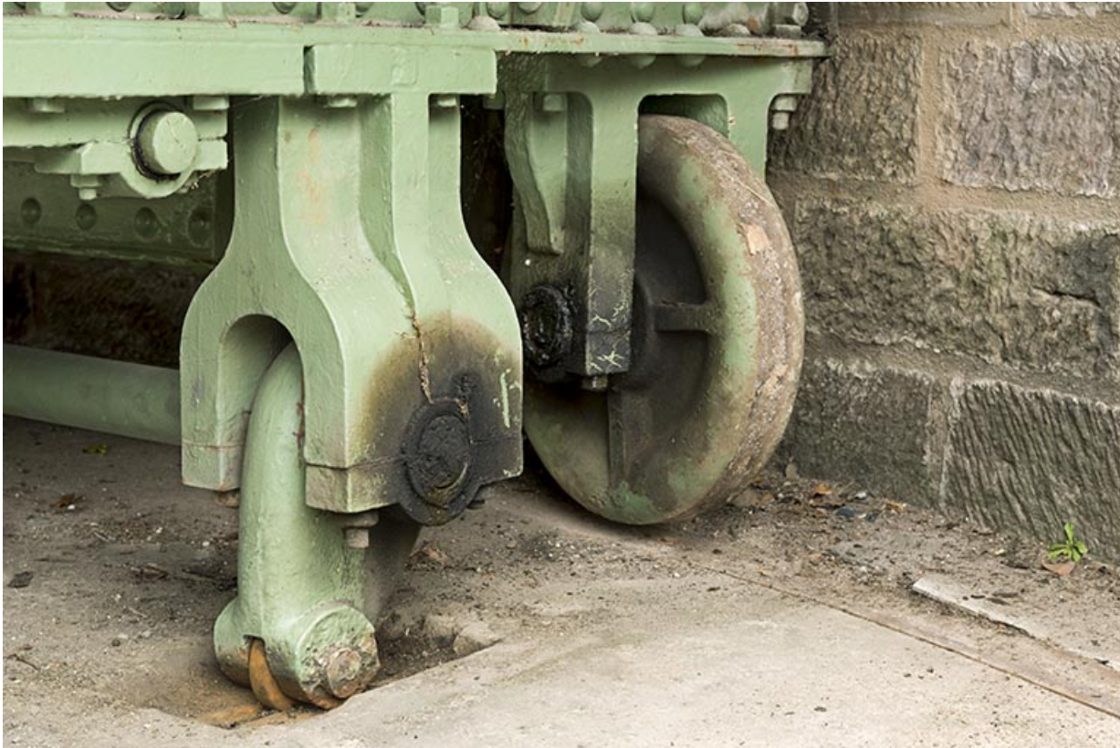
Système de calage baissé (côté amont).
