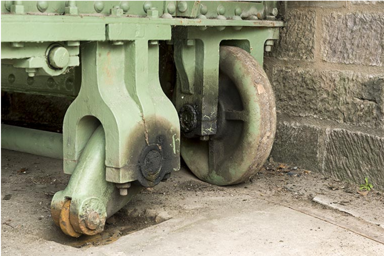
Système de calage levé (côté amont).
