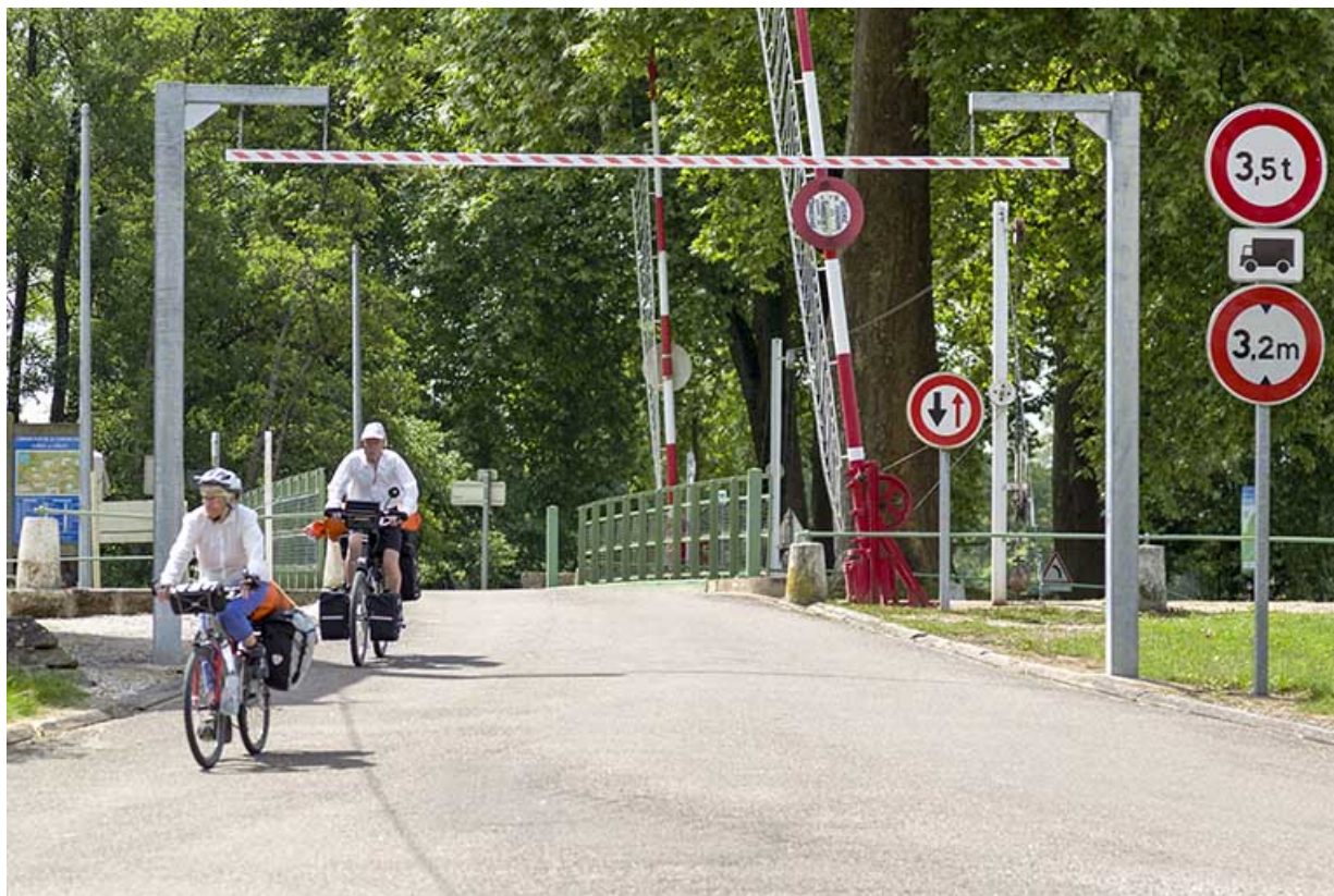
Cyclistes franchissant le pont.
