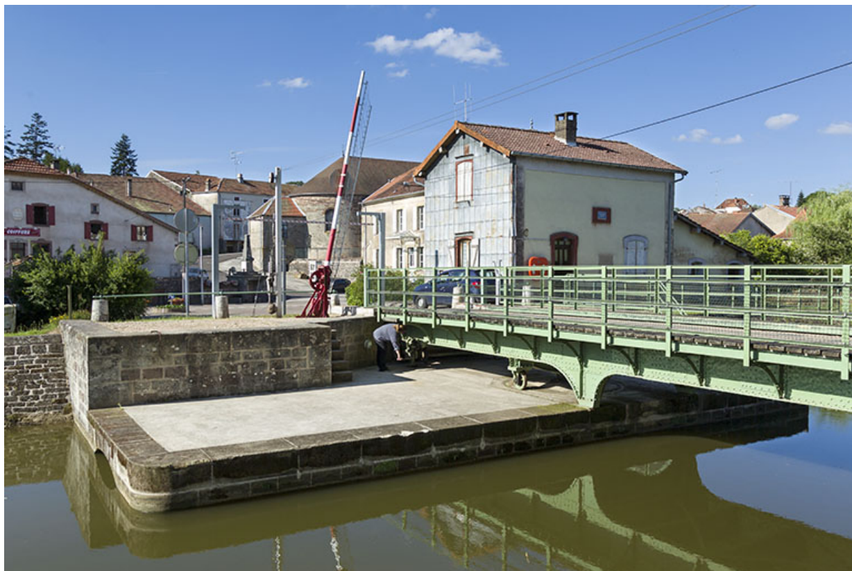
Le tablier métallique et sa plateforme depuis l'aval.
