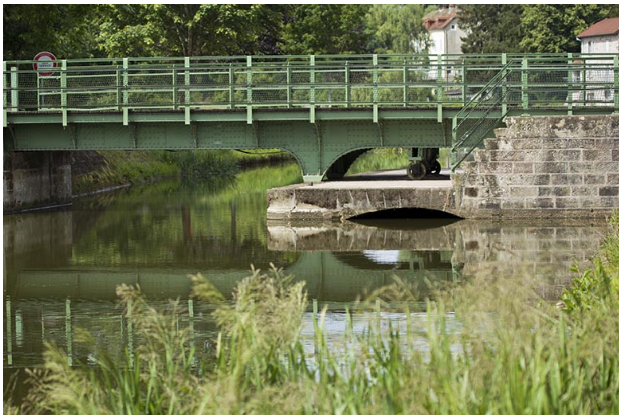
Vue sur la plateforme maçonnée (côté date portée).
