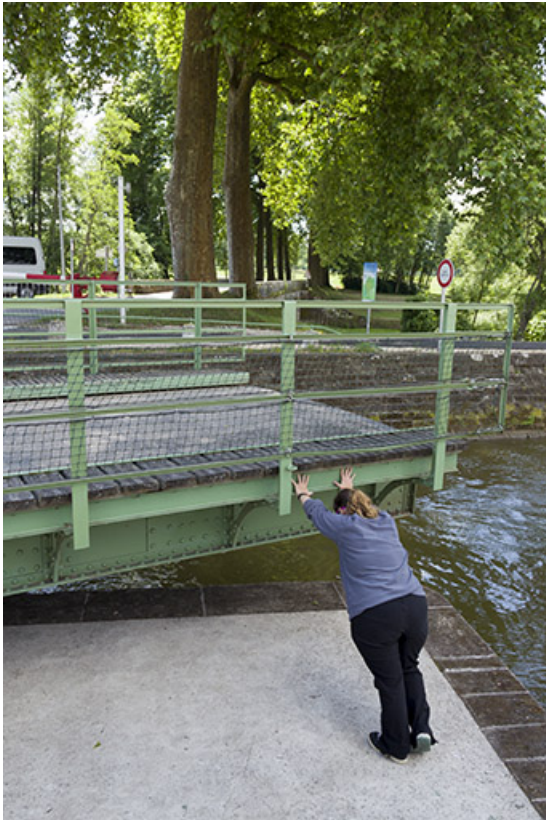
Rotation du pont par poussée manuelle.
