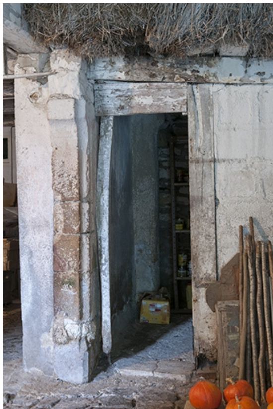
Porte de l'ancienne cuisine ouvrant sur la cour.
