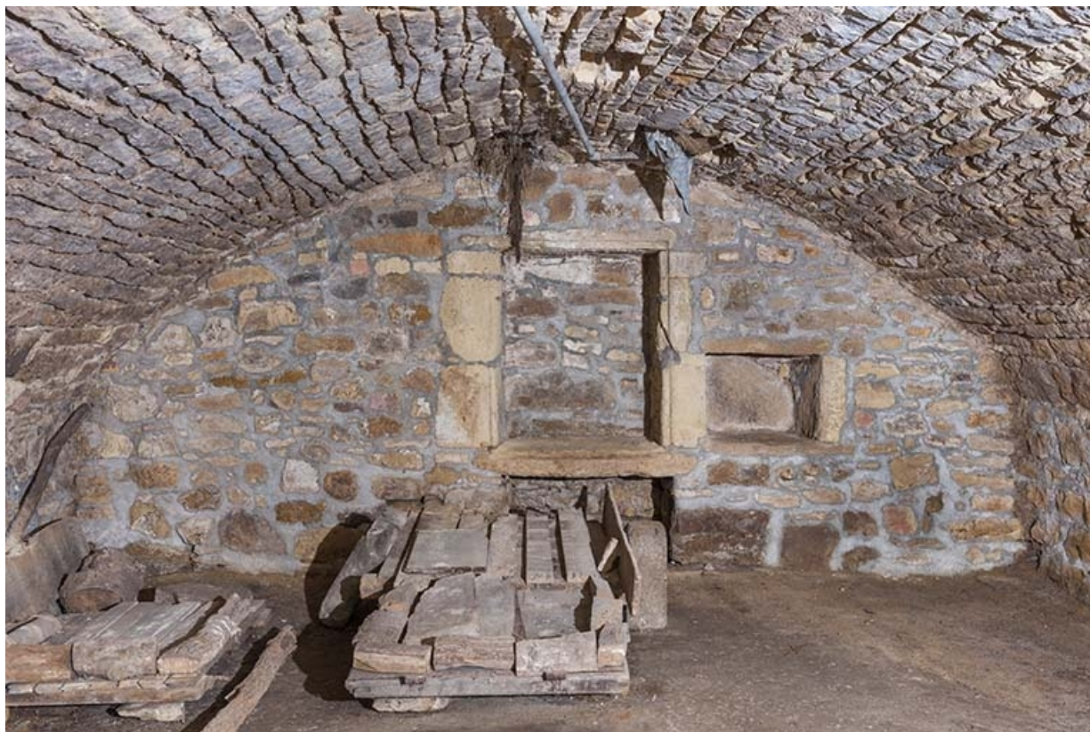
Ferme, 23 Grande Rue : cave voûtée et placards aménagés dans le mur du fond, face à l'entrée. 70, Faverney, 23 Grande Rue
