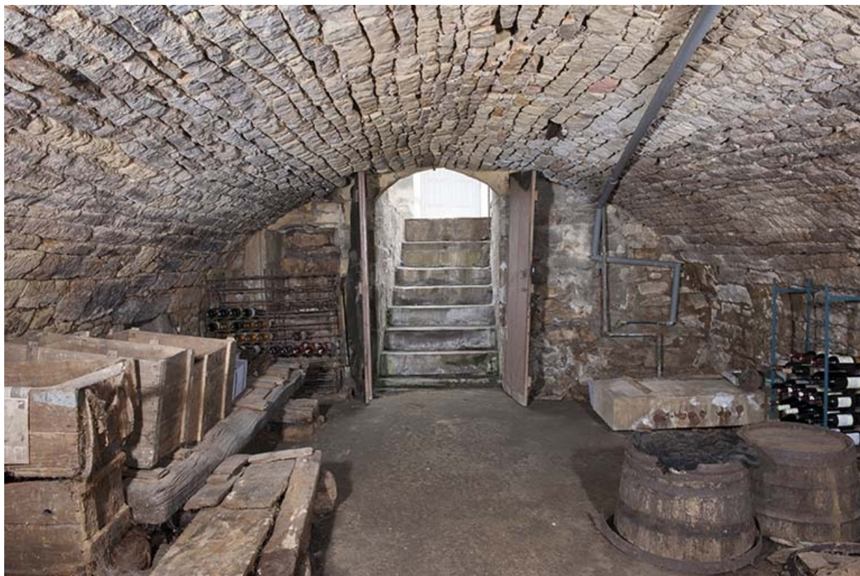
Sous-sol, en direction de l'entrée.
