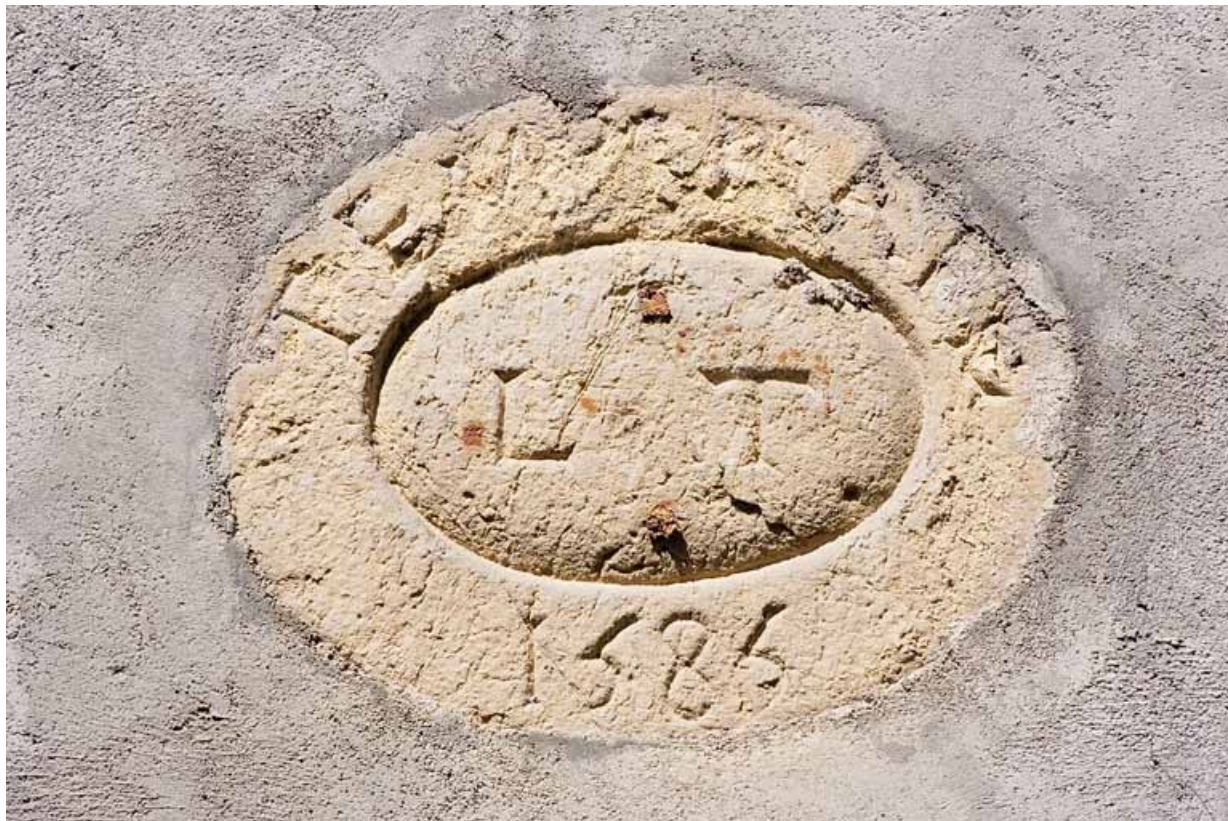
Détail de la façade latérale droite : le médaillon au-dessus de la porte.
