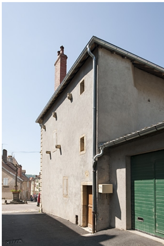
Vue générale de la façade latérale droite.
