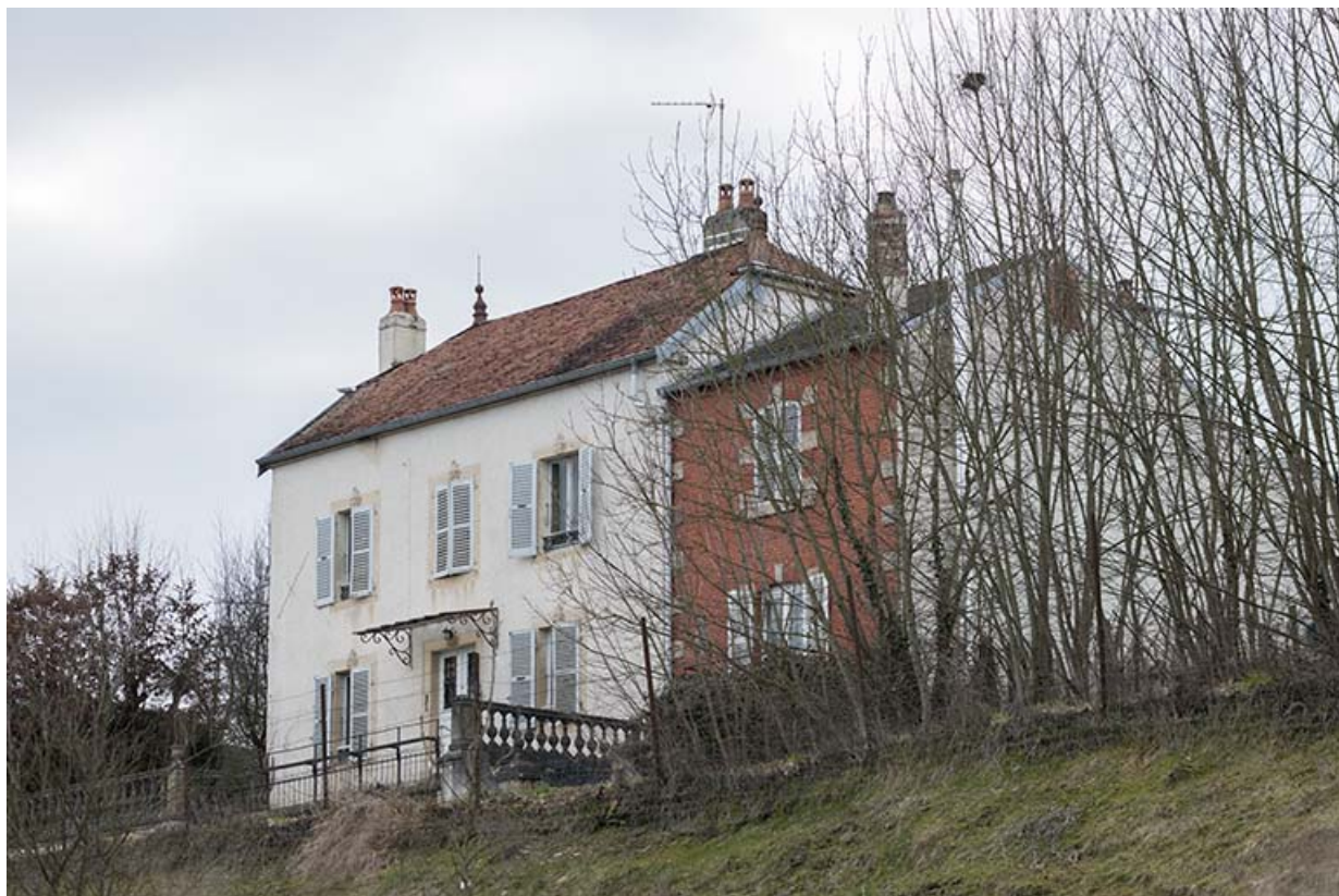
Vue générale de trois quart droite depuis la rue Molière.
