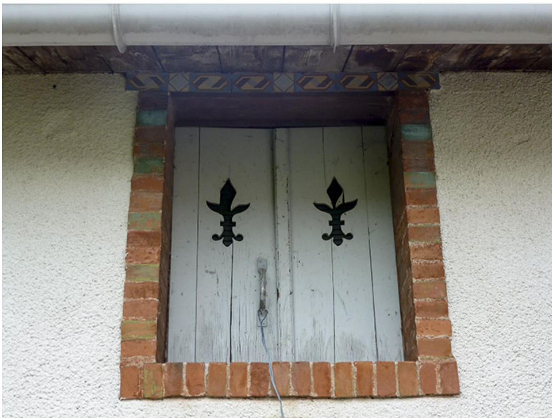
Remise : baie de l'étage de comble.
