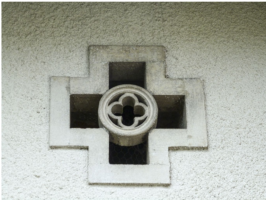
Remise : baie cruciforme de l'étage de comble.
