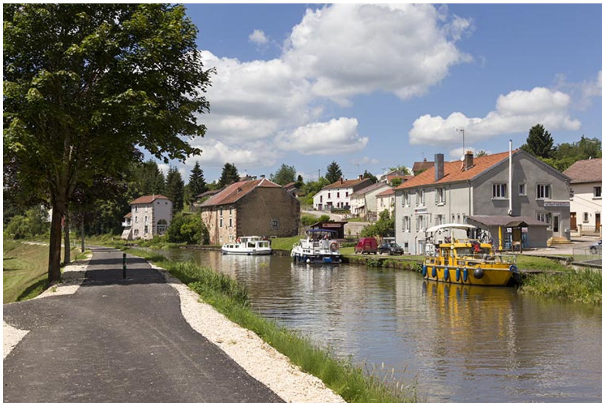
Le village de Selles depuis l'ancien chemin de halage. 70, Selles
