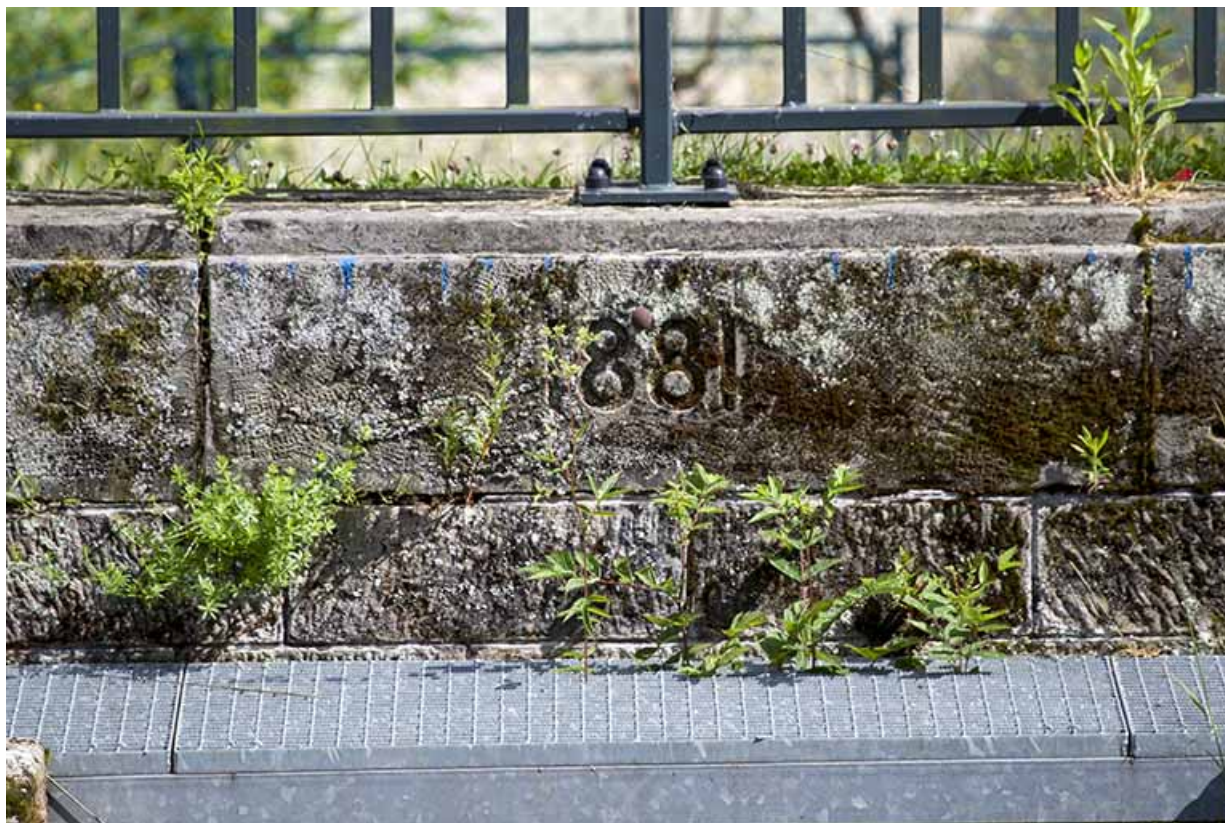
Détail sur la date de construction.
