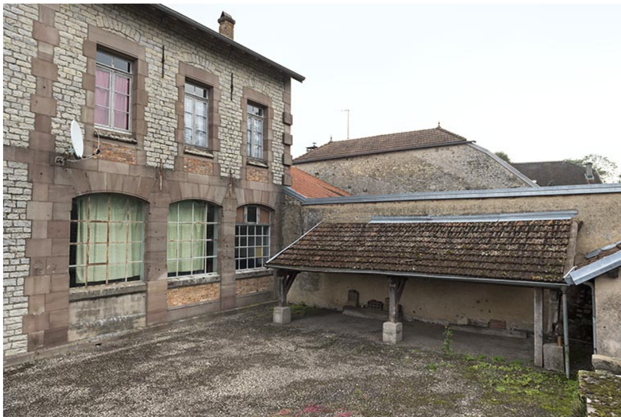
Cour, préau, détail de la façade postérieure.
