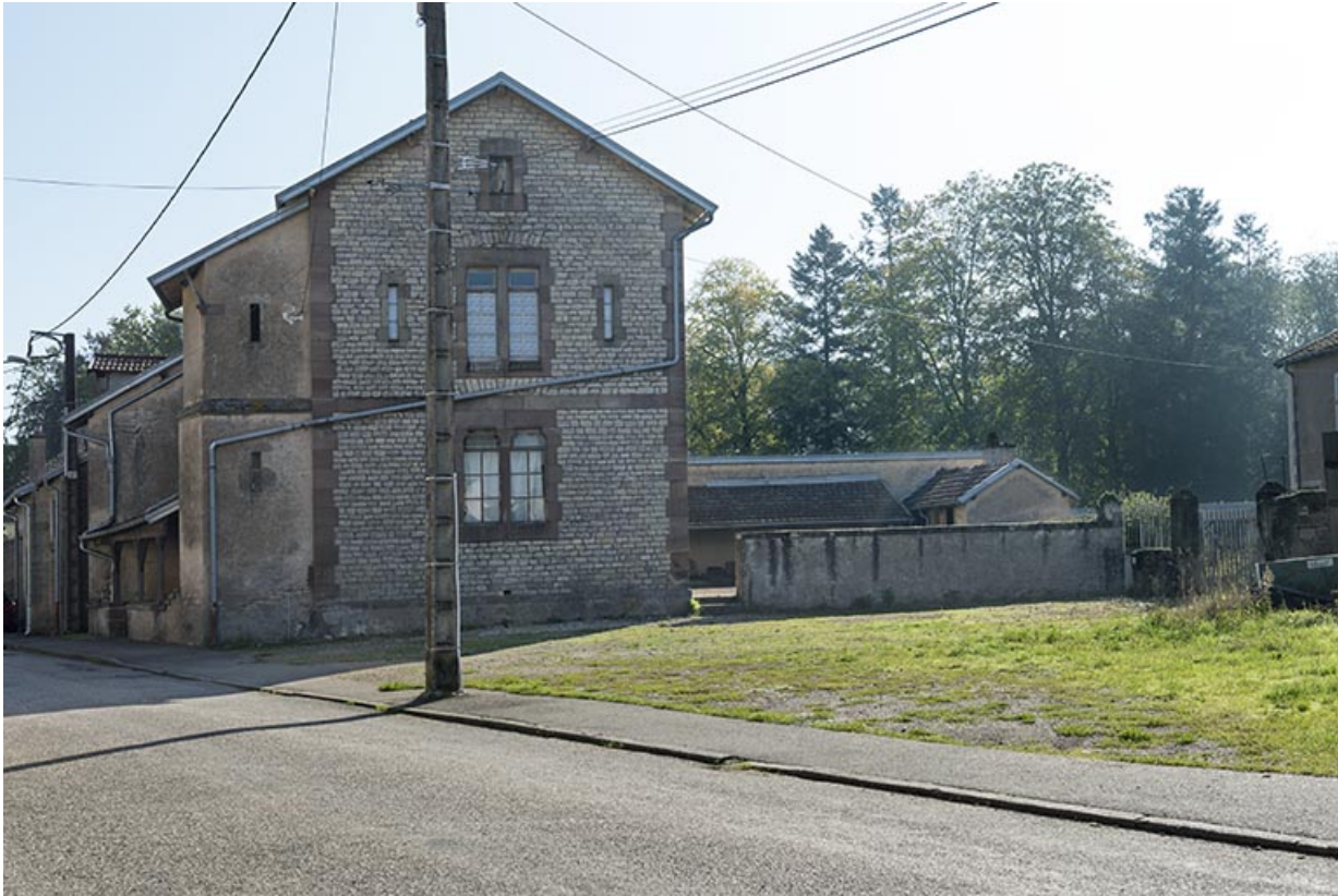
Vue d'ensemble depuis le nord-ouest : pignon et cour.
