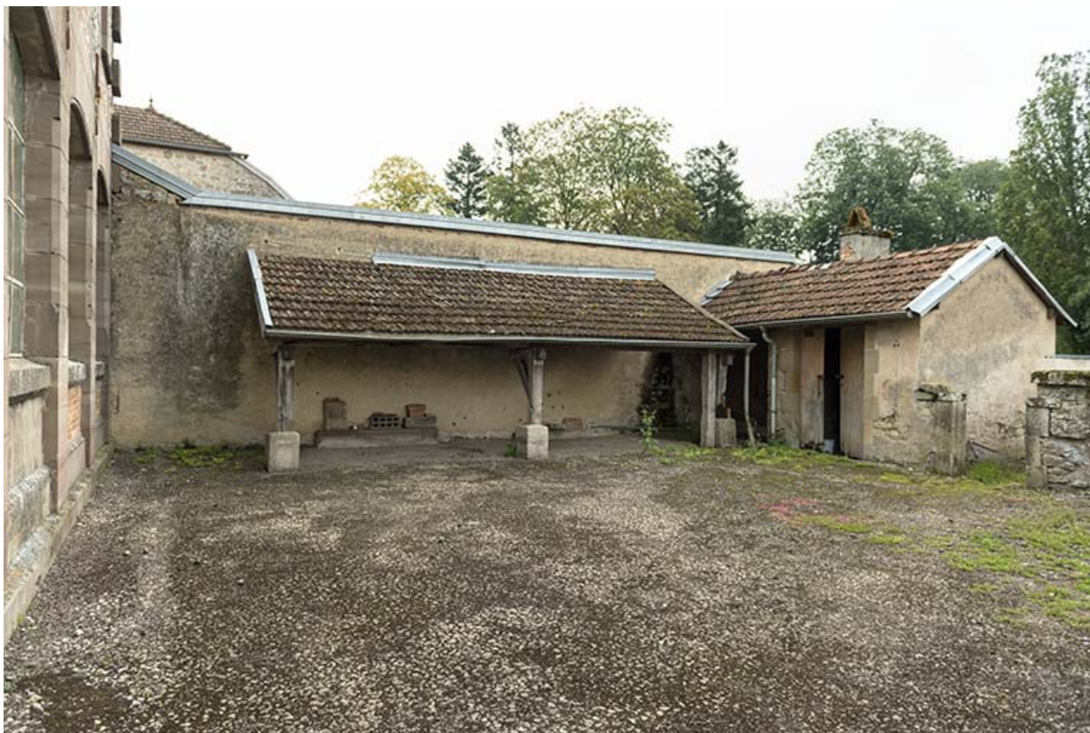
Cour, préau, toilettes, à l'arrière du bâtiment.
