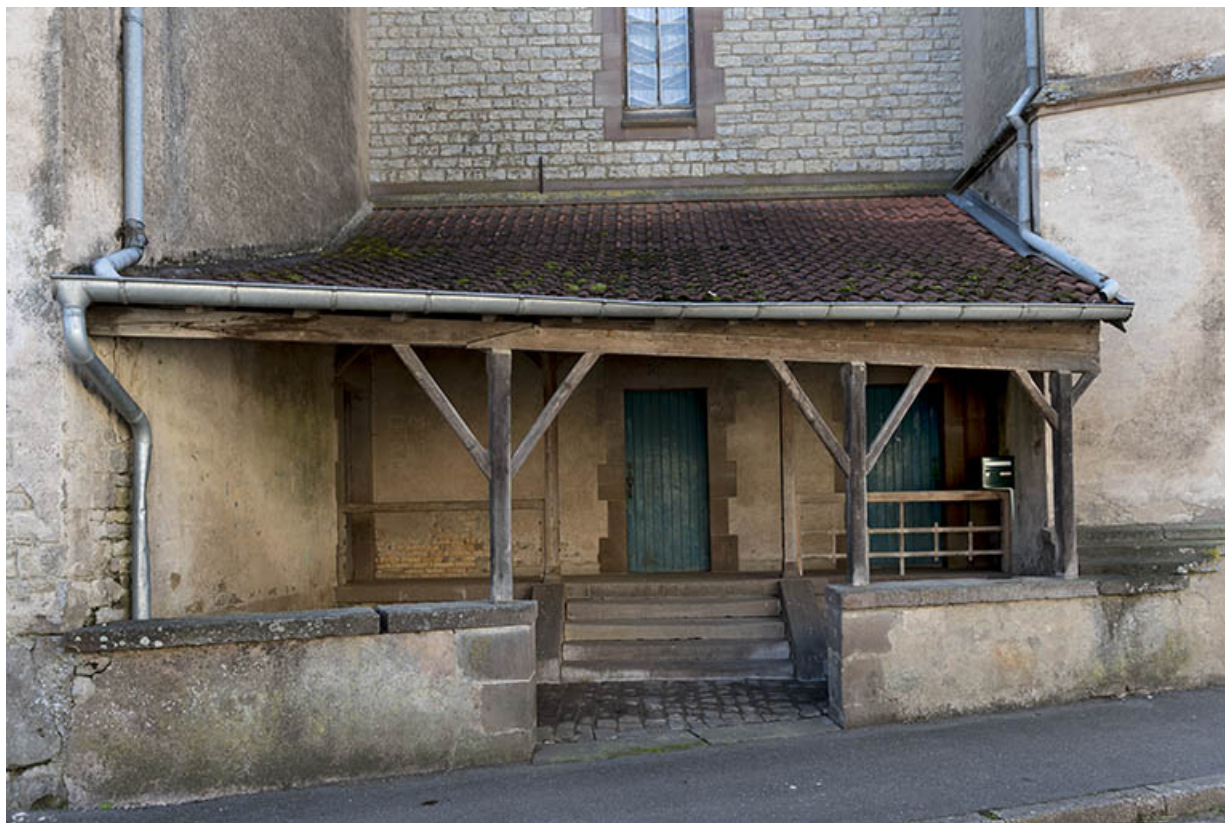
Détail de l'entrée rue Billecard.
