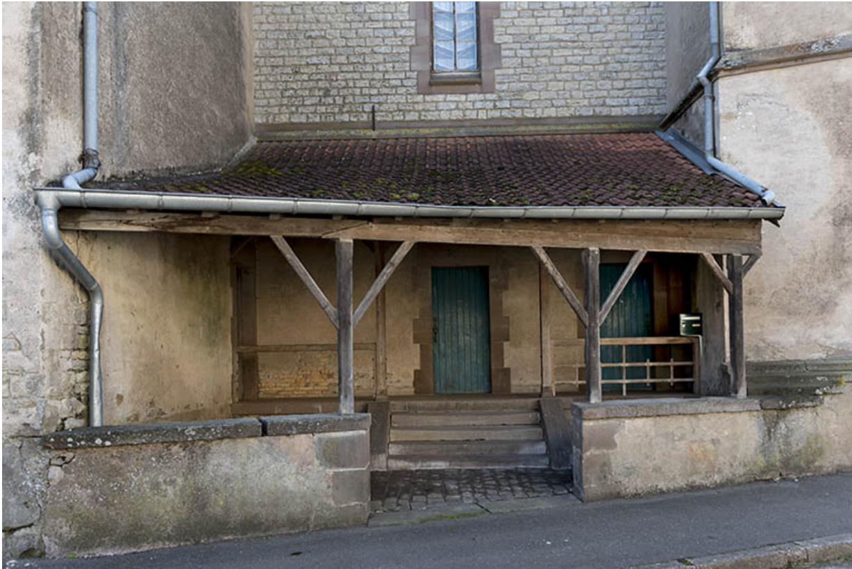
Détail de l'entrée rue Billecard.
