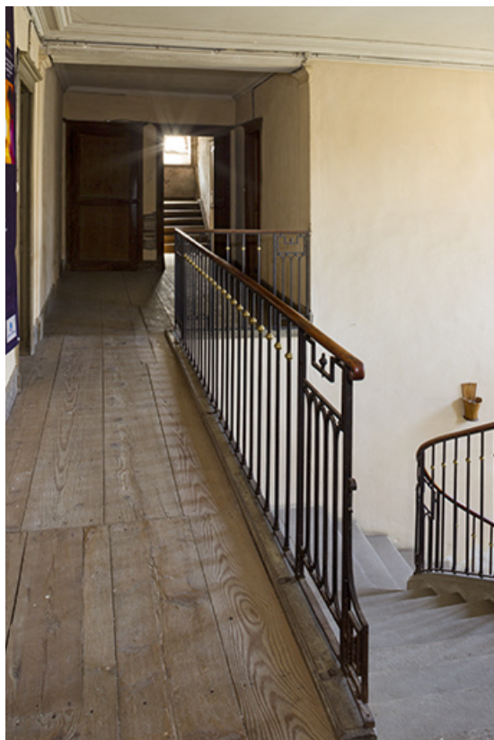
Vue d'ensemble de la distribution de l'aile sud à l'étage et escalier du comble prenant la lumière par son oculus sur le pignon sud. 70, Corre, 2 rue Emile Hauviller
