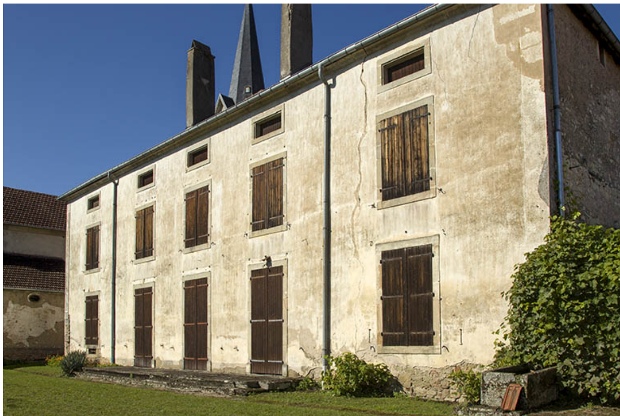
Vue de trois-quart nord-est de la façade postérieure.
