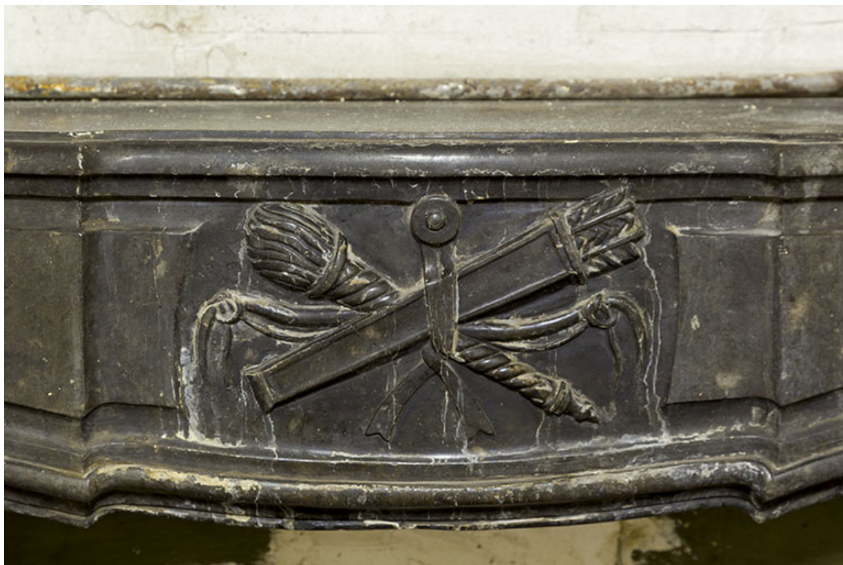
Linteau de cheminée : détail de motif sculpté.
