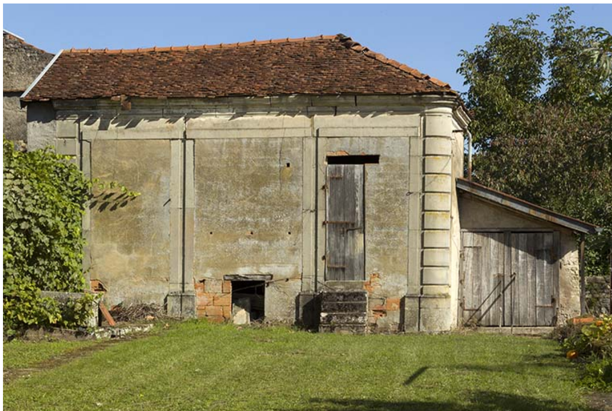
Façade sud de l'édicule du jardin.
