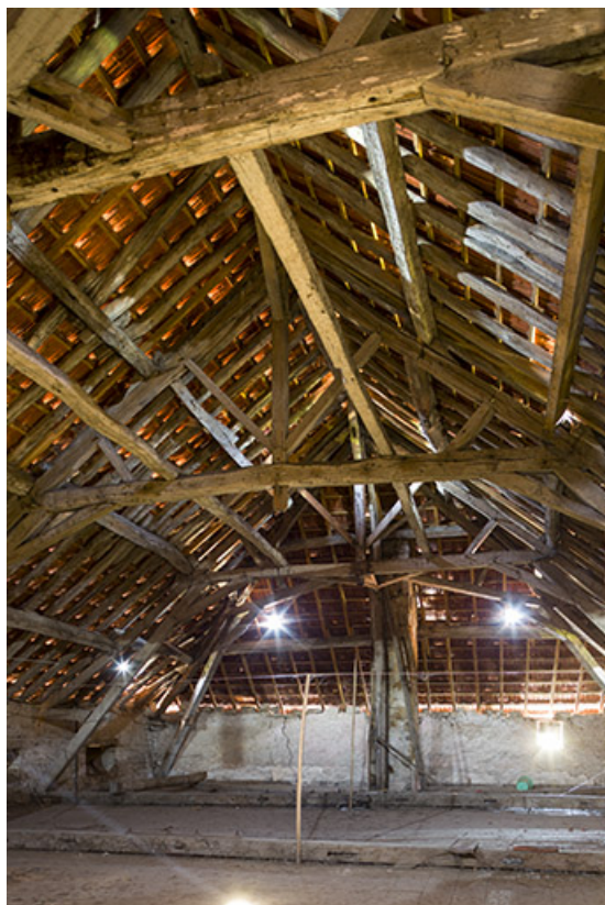
Vue intérieure de la charpente de toit.
