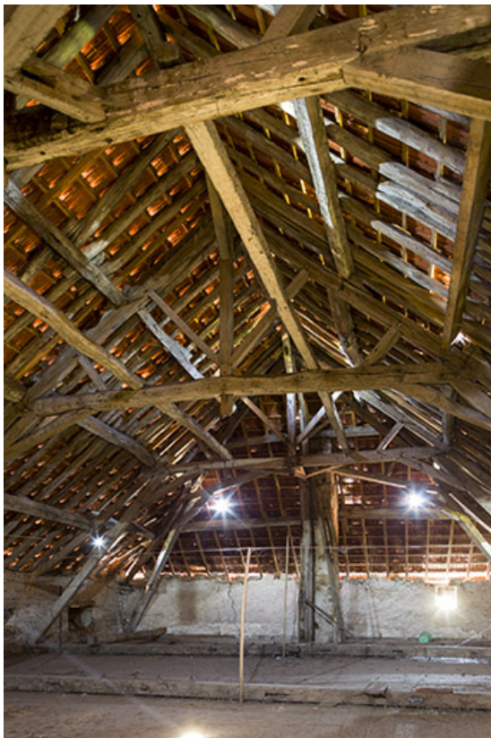
Vue intérieure de la charpente de toit.
