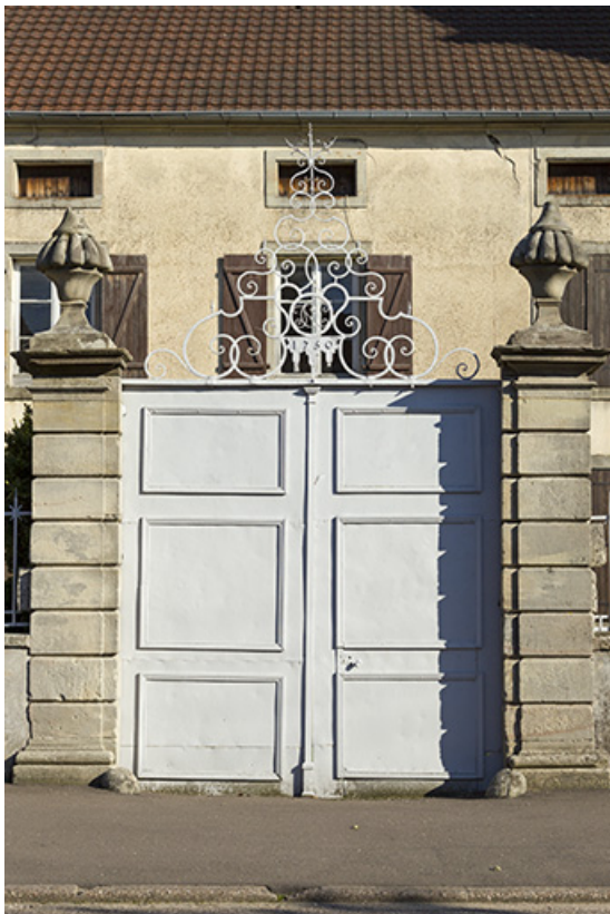
Porte flamande à couronnement de fer forgé, et deux vases d'amortissement sommant ses deux piliers. 70, Corre, 2 rue Emile Hauviller
