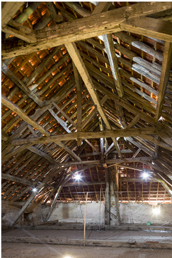
Vue intérieure de la charpente de toit.
