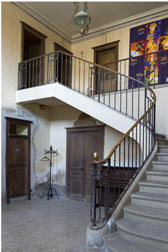
Vue d'ensemble de l'escalier de distribution intérieur.
