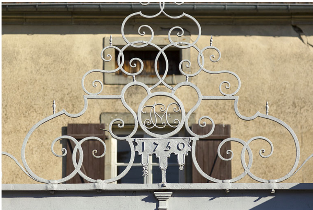
Détail du couronnement de fer forgé de la porte flamande portant la date de 1750 ainsi qu'un monogramme. 70, Corre, 2 rue Emile Hauviller
