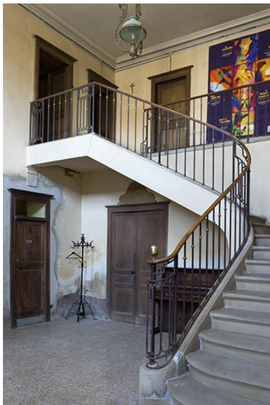
Vue d'ensemble de l'escalier de distribution intérieur.
