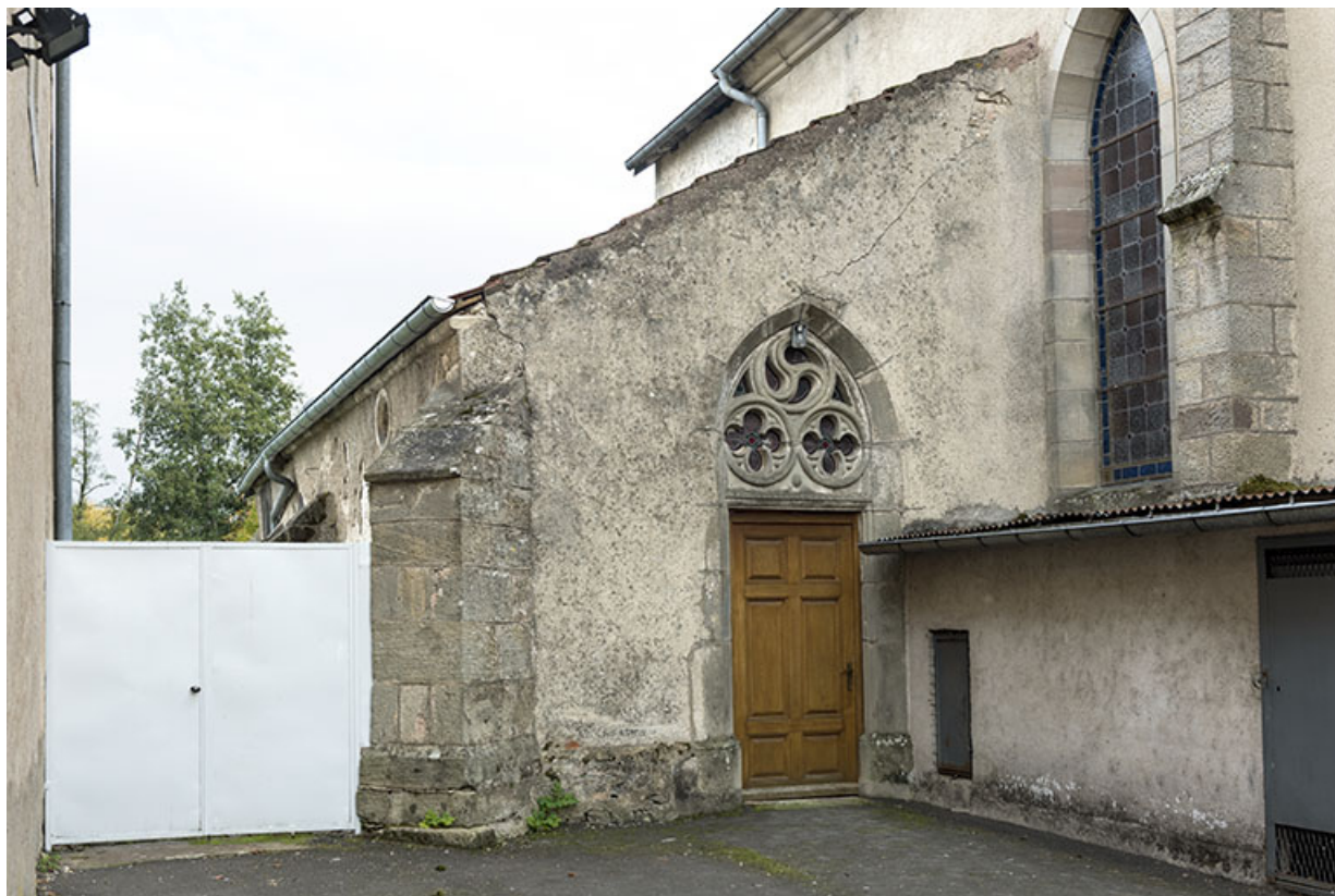
Détail de l'entrée de la chapelle nord.
