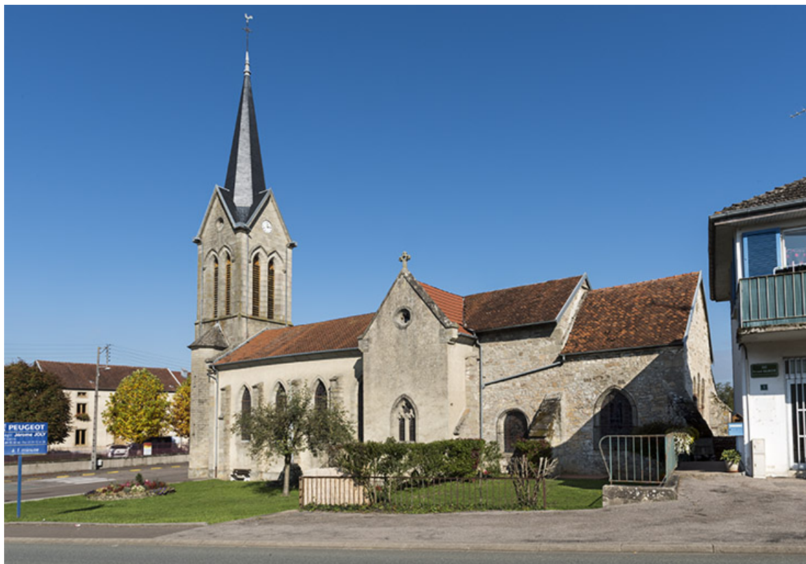
Vue d'ensemble sud-est.
