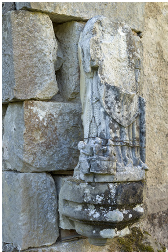
Fragment de sculpture le long du mur extérieur nord. 70, Corre, 2 rue Émile Hauviller
