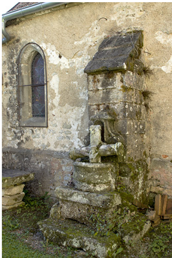
Fragments de sculpture et de crucifix le long du mur extérieur nord. 70, Corre, 2 rue Émile Hauviller
