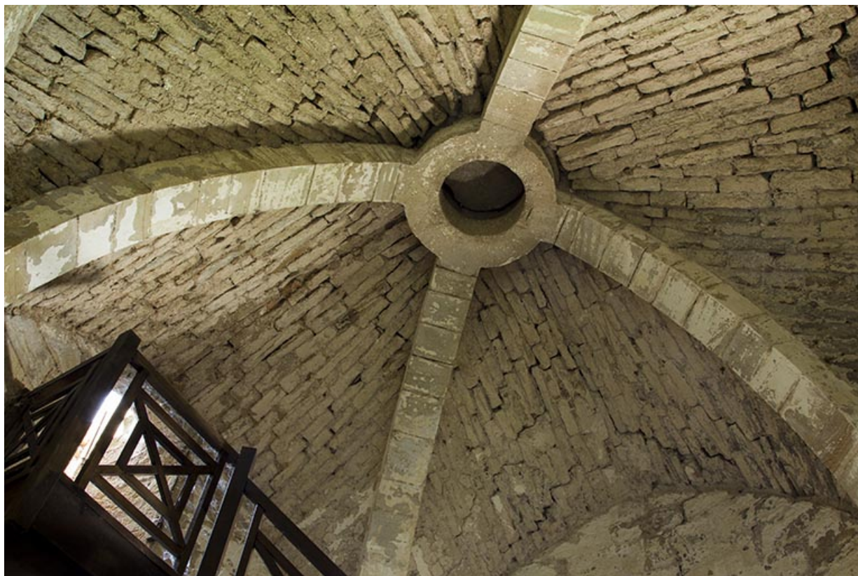
Le plafond voûté du rez-de-chaussée du donjon.
