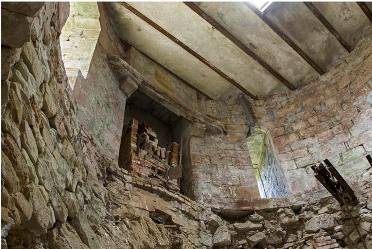
Vue sur la cheminée encore en place au second étage.
