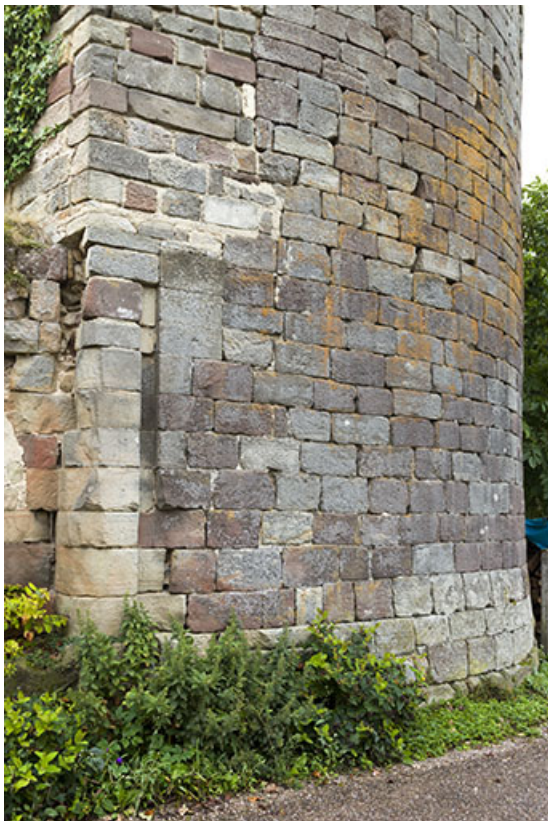
Détail d'une rainure verticale qui accueillait la herse permettant de fermer la porte. 70, Passavant-la-Rochère
