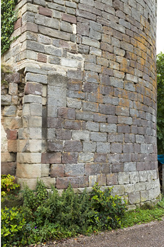
Détail d'une rainure verticale qui accueillait la herse permettant de fermer la porte.
