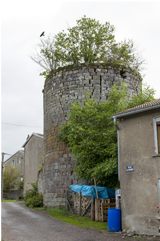
L'ancienne tour d'entrée de ville.
