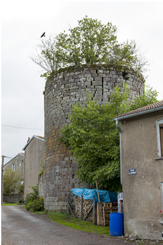
L'ancienne tour d'entrée de ville.
