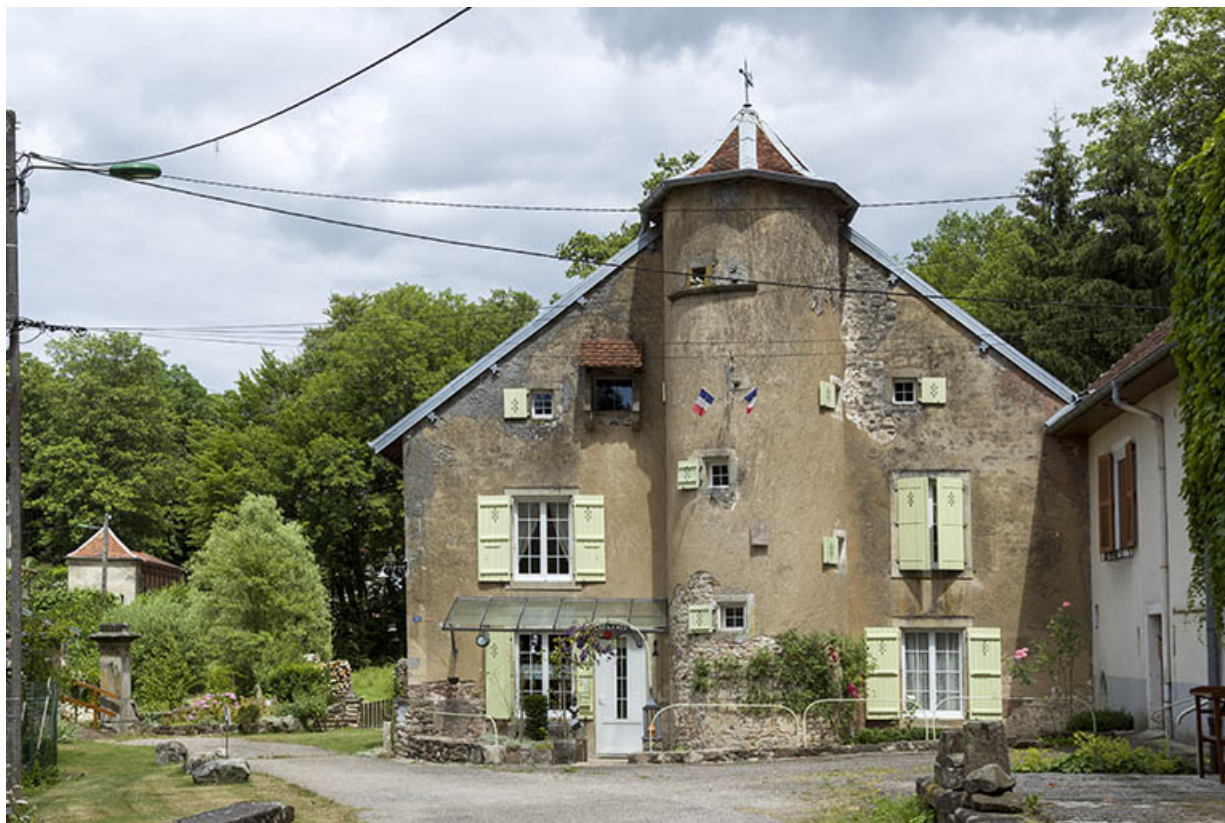
Façade avec la tourelle d'escalier de la maison des Hennezel. 70, Passavant-la-Rochère chemin Saint-Valbert, lieudit : la Rochère
