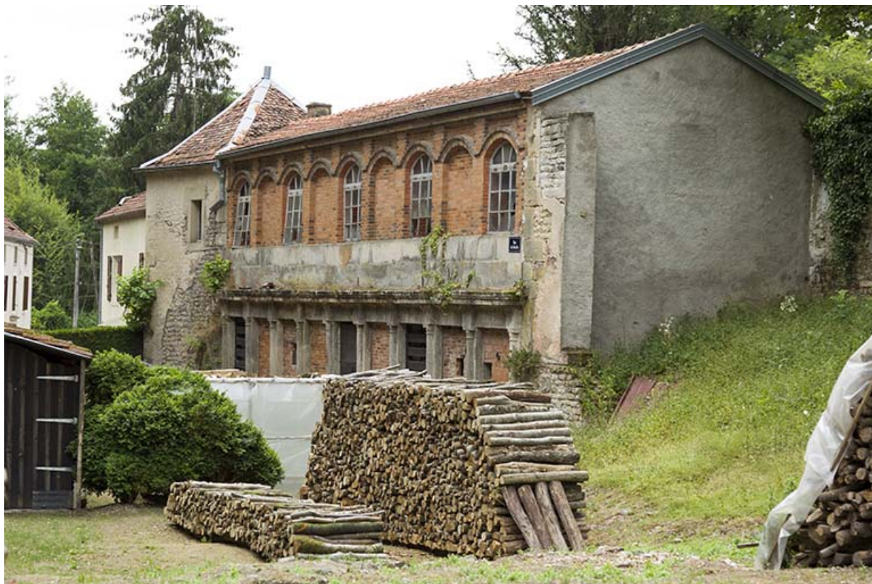
Bâtiment dépendant du moulin détruit au cours du 19e siècle.
