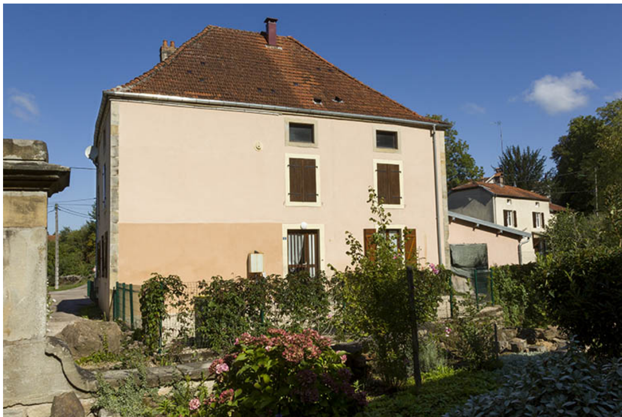
Maison, façade postérieure, rue du Moulin. 70, Passavant-la-Rochère, lieudit : la Rochère
