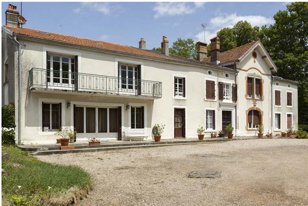
Maison "Boileau", ancien directeur de la verrerie.
