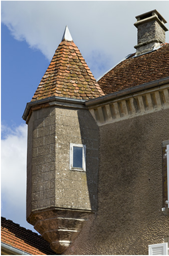
Détail d'une des échauguettes de la façade postérieure.
