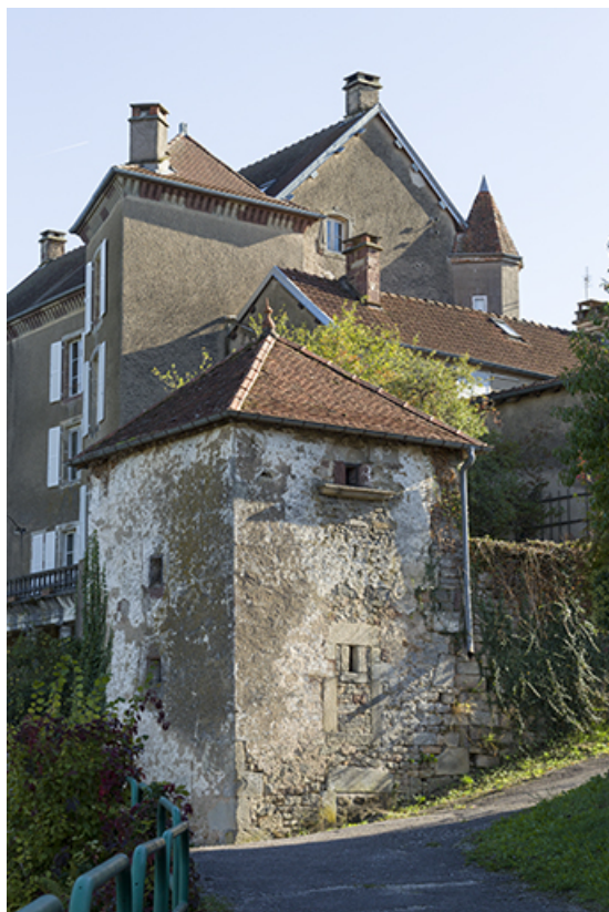
Vue sur la propriété depuis la rue du Pâteux.
