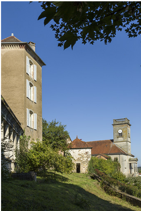
Vue sur la tour nord de la demeure avec l'église paroissiale en arrière plan.
