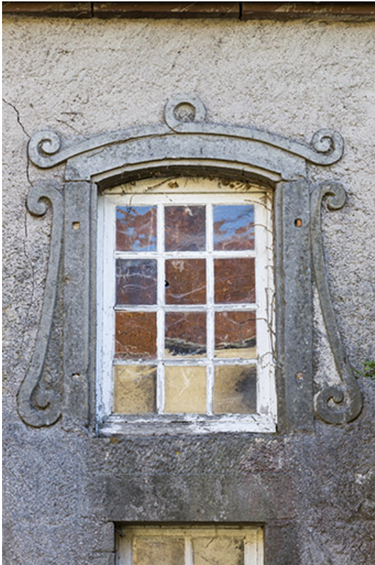
Détail d'une baie, façade ouest.
