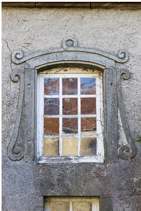
Détail d'une baie, façade ouest.
