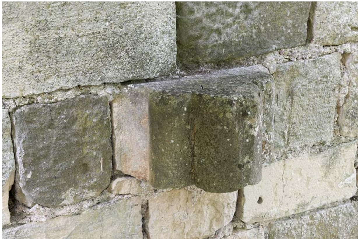
Autre exemple d'élément architectural inséré dans le mur d'enclos.
