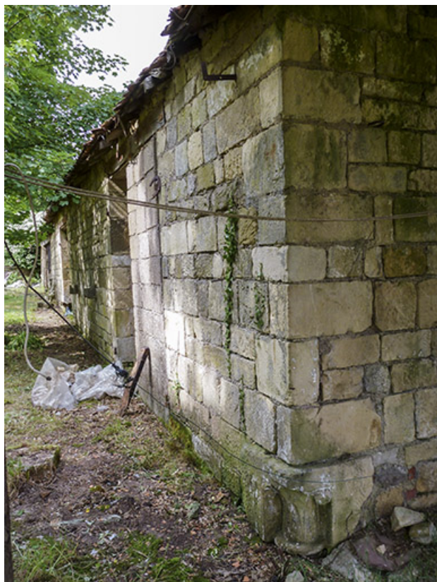
Ensemble de dépendances à droite de la maison.
