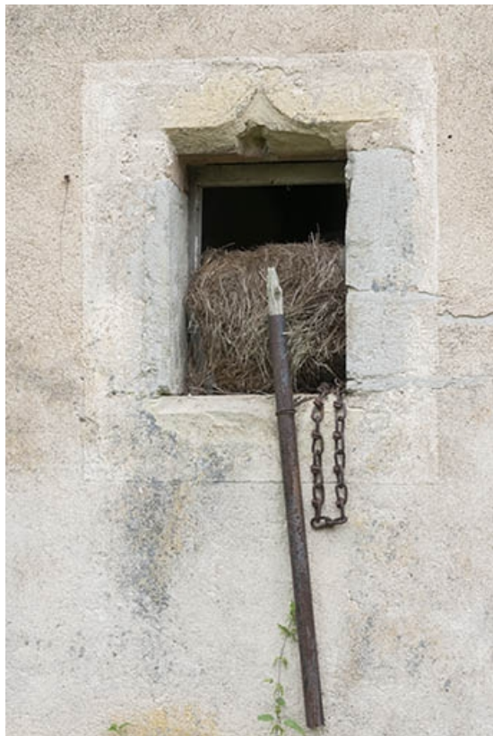
Façade postérieure des parties agricoles, détail d'une baie en accolade. 70, Faverney, 2 rue Sadi Carnot
