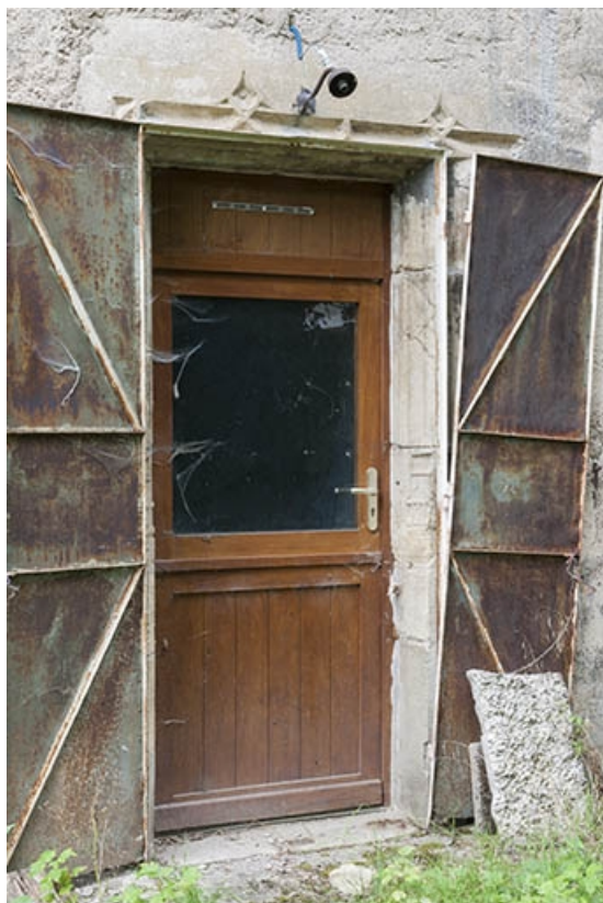
Façade latérale droite de la maison, détail de la baie en accolade modifiée. 70, Faverney, 2 rue Sadi Carnot
