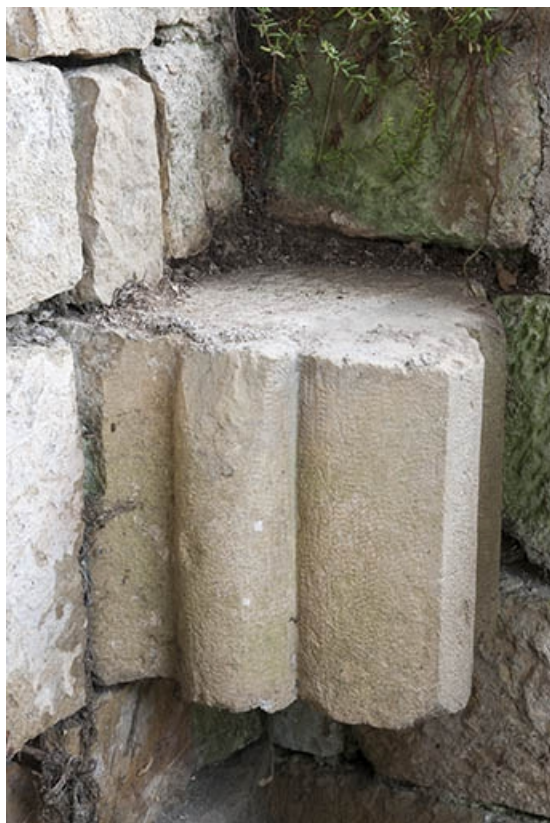
Élément architectural inséré dans le mur d'enclos.
