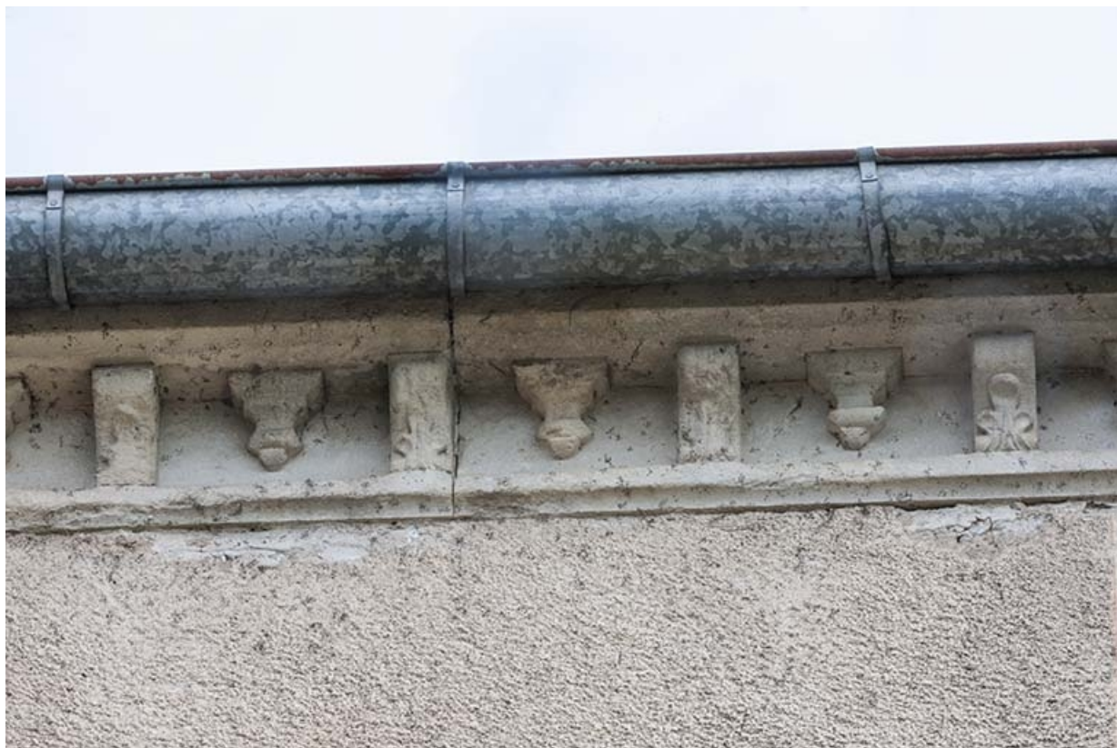
Détail de la corniche de la maison.
