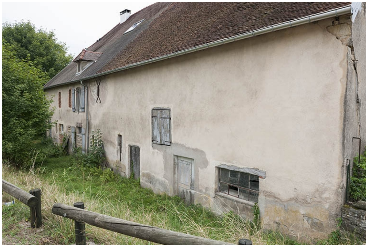
Façade postérieure des parties agricoles et de la maison.
