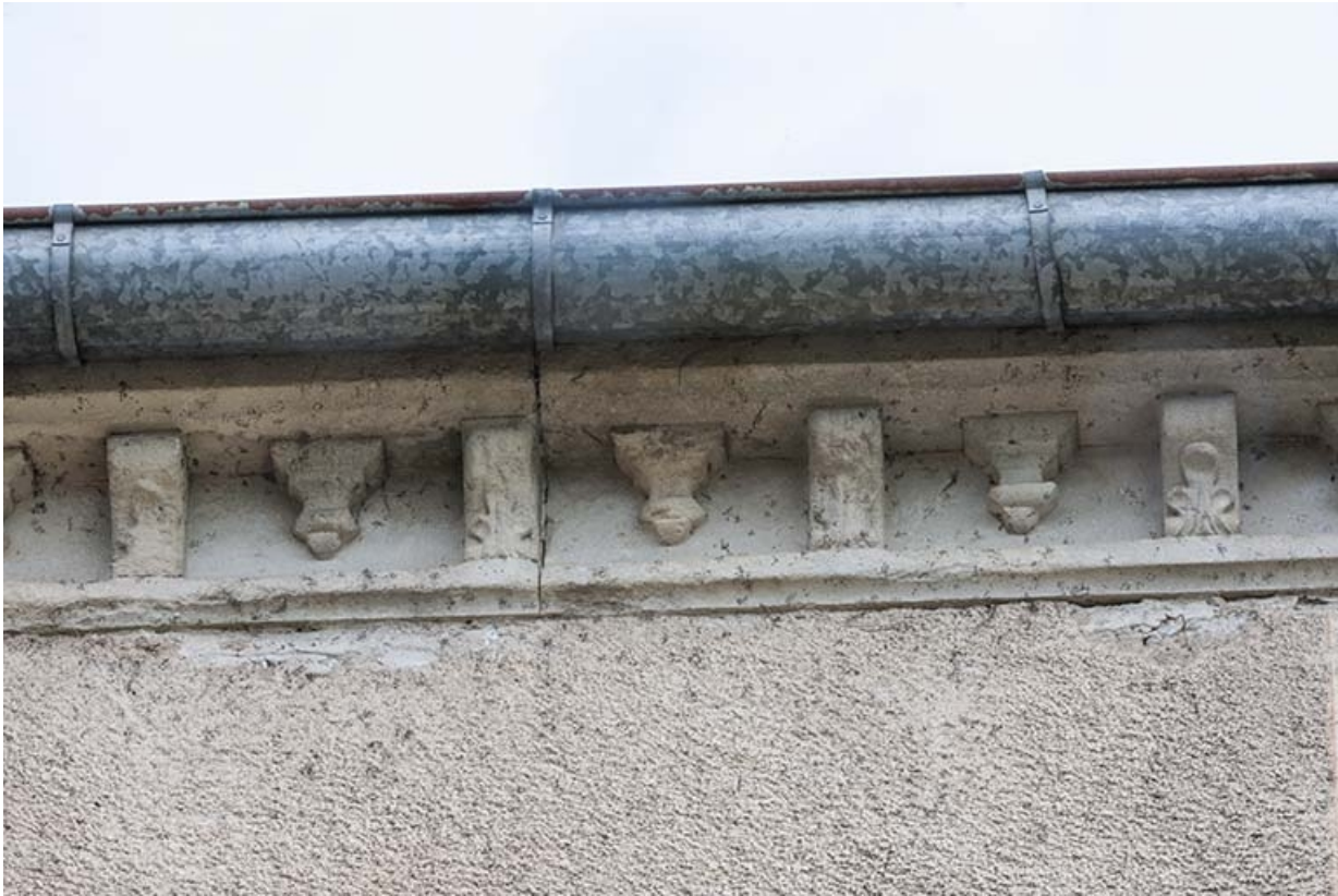
Détail de la corniche de la maison.
