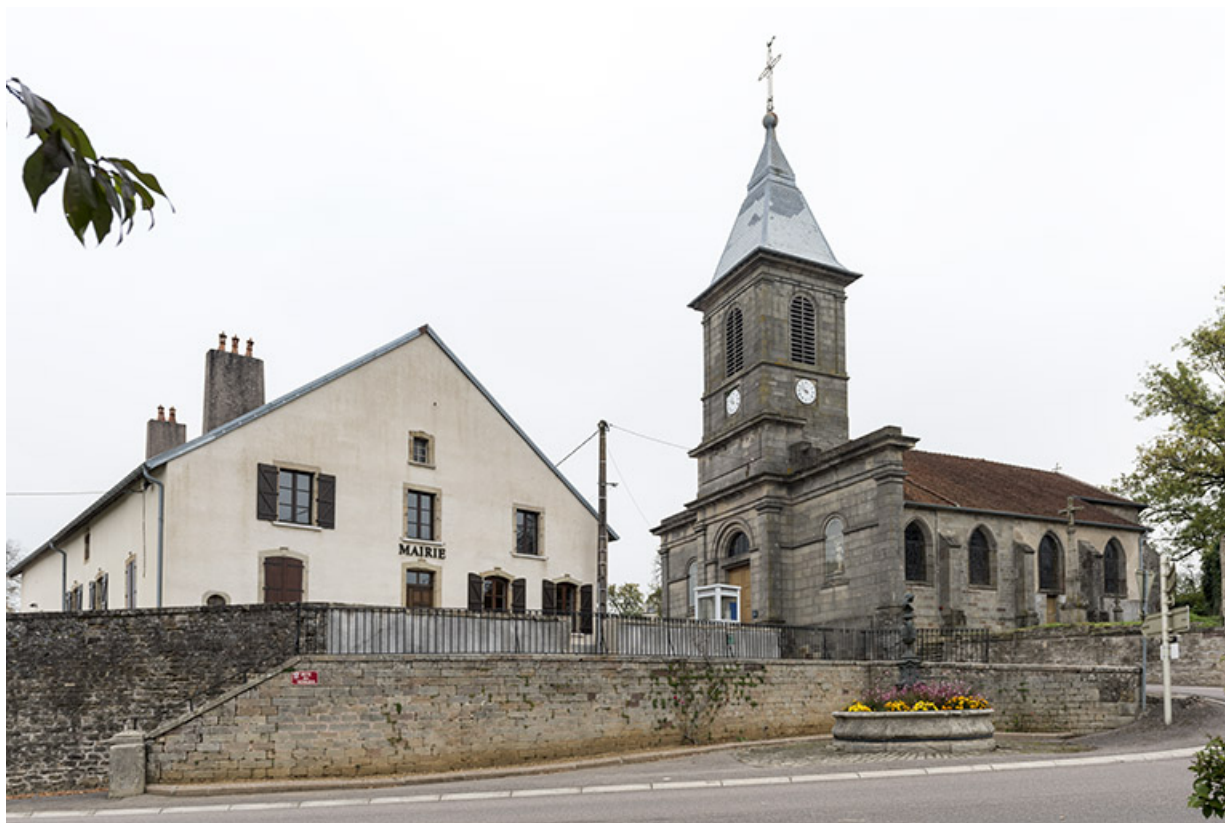
Mairie, fontaine, Marianne et église paroissiale. 70, Vouécourt
