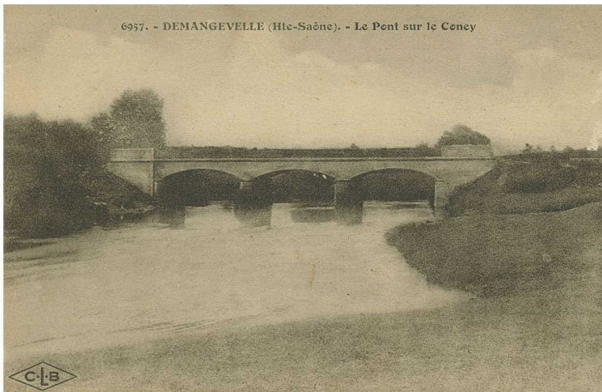
Demangevelle. Le pont sur le Coney. Carte postale. 70, Demangevelle
