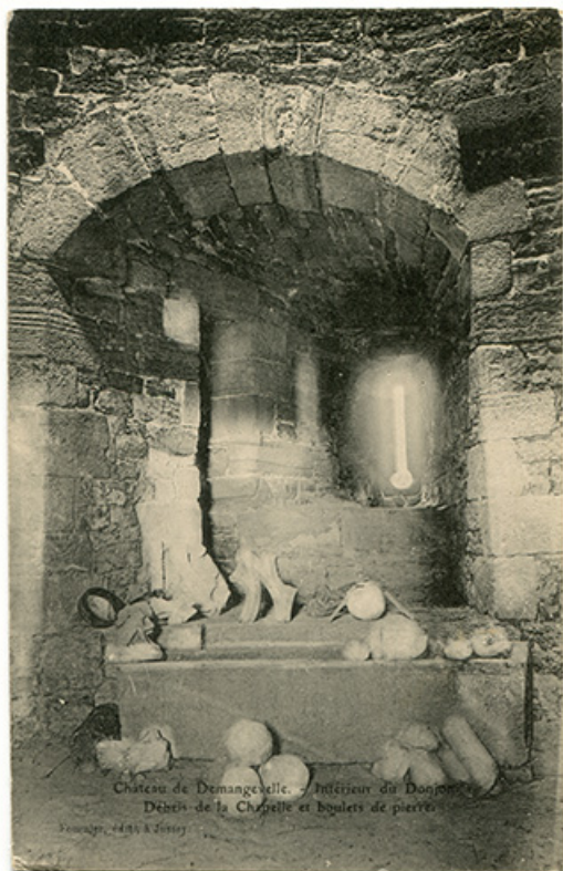
Château de Demangevelle. Intérieur du donjon. Débris de la chapelle et boulets de pierre. Carte postale. 70, Demangevelle
