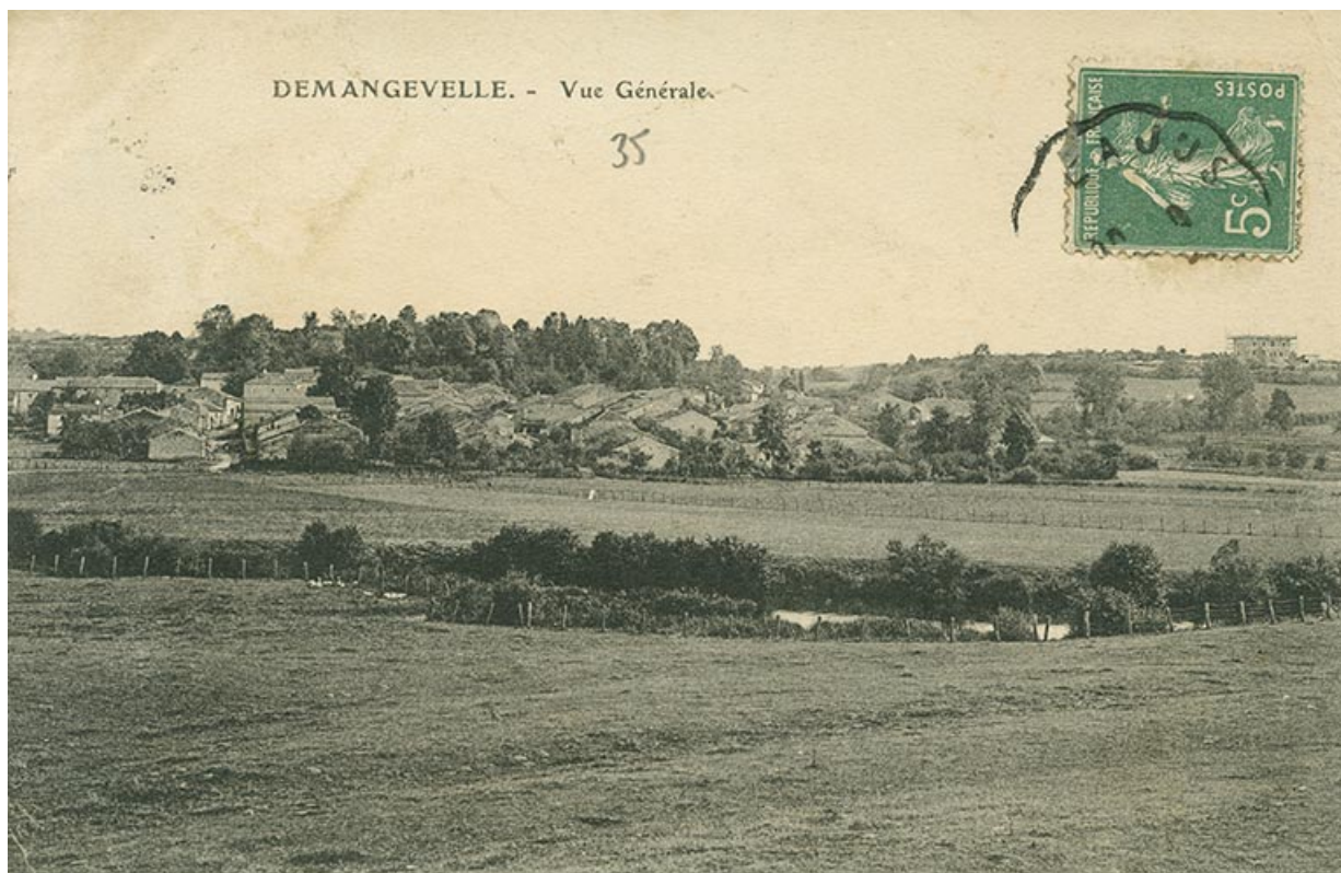
Demangevelle. Vue générale. Carte postale. 70, Demangevelle
