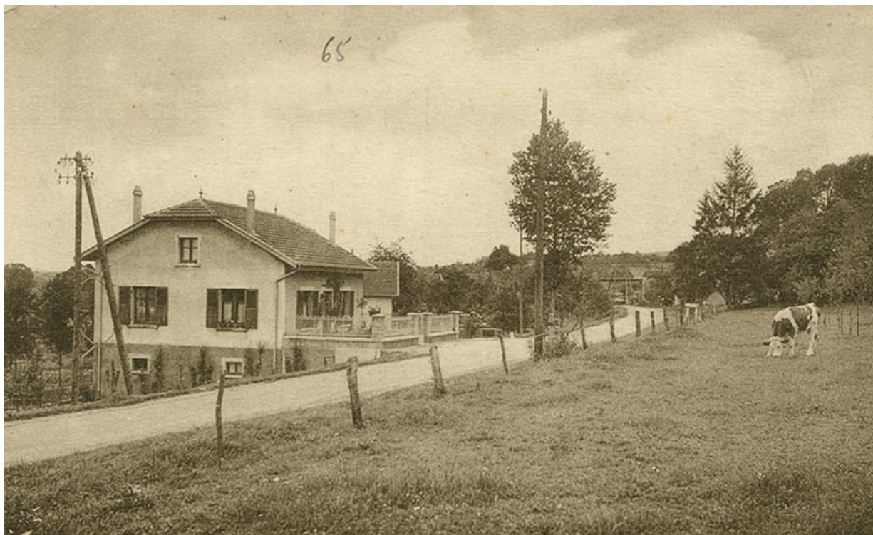
Demangevelle. Entrée du pays route de Corre. Carte postale.
