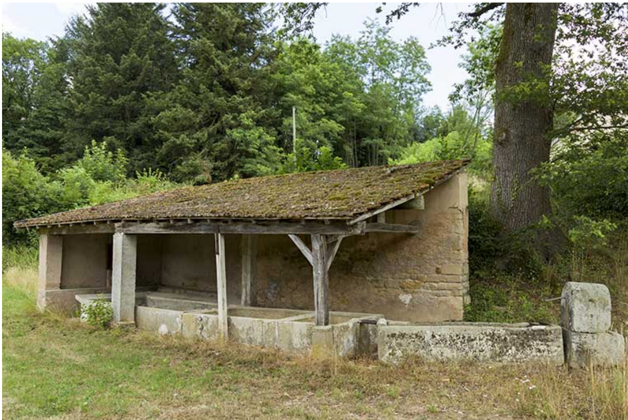
Lavoir, rue des Forges.
