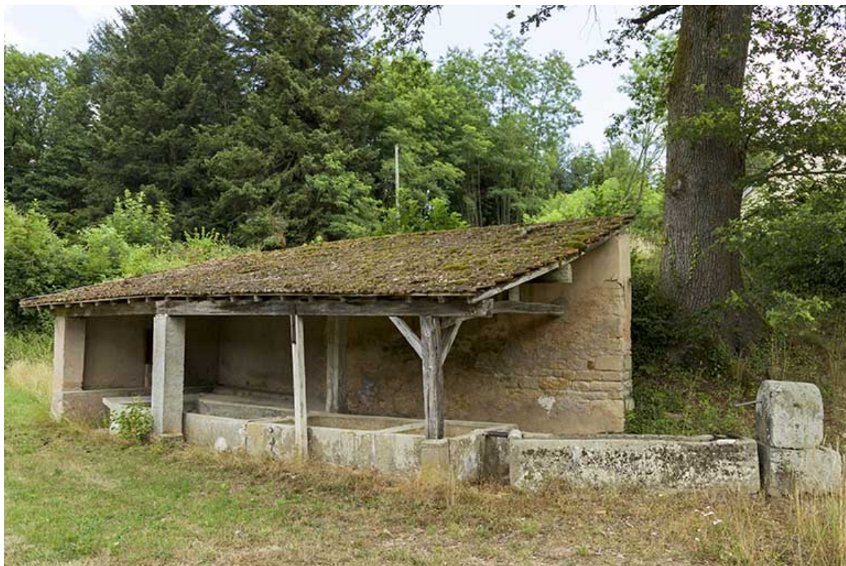
Lavoir, rue des Forges.
