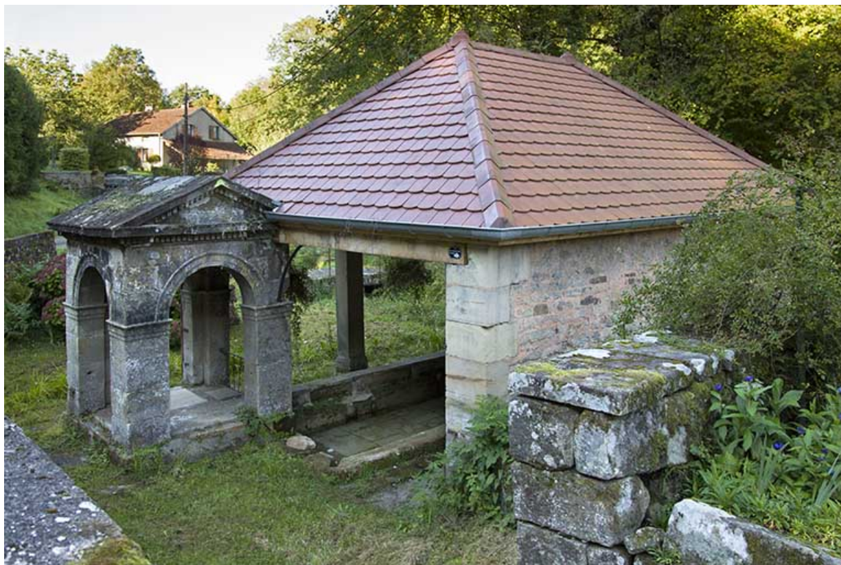
Détail sur le monument abritant le puisard, fontaine la Violette, la Rochère. 70, Passavant-la-Rochère
