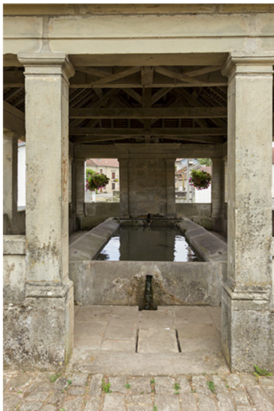
Vue sur le bassin intérieur.
