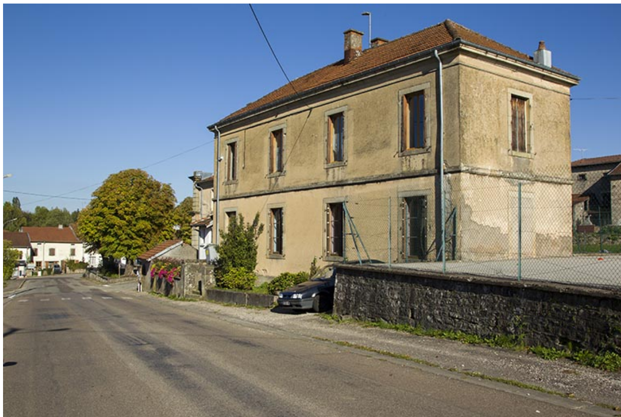
L'école, vue depuis la rue de Vouécourt. 70, Passavant-la-Rochère rue de Vouécourt
