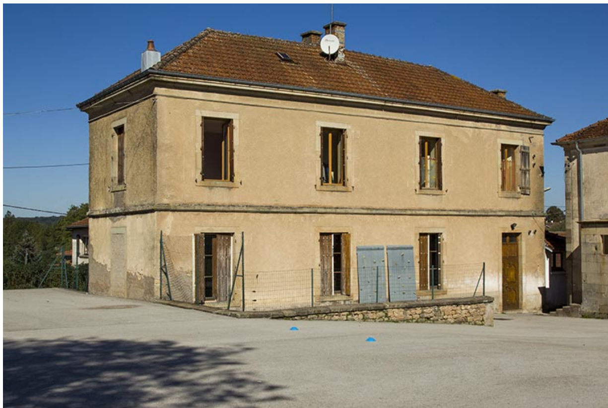
Façade postérieure de l'ancienne école enfantine.
