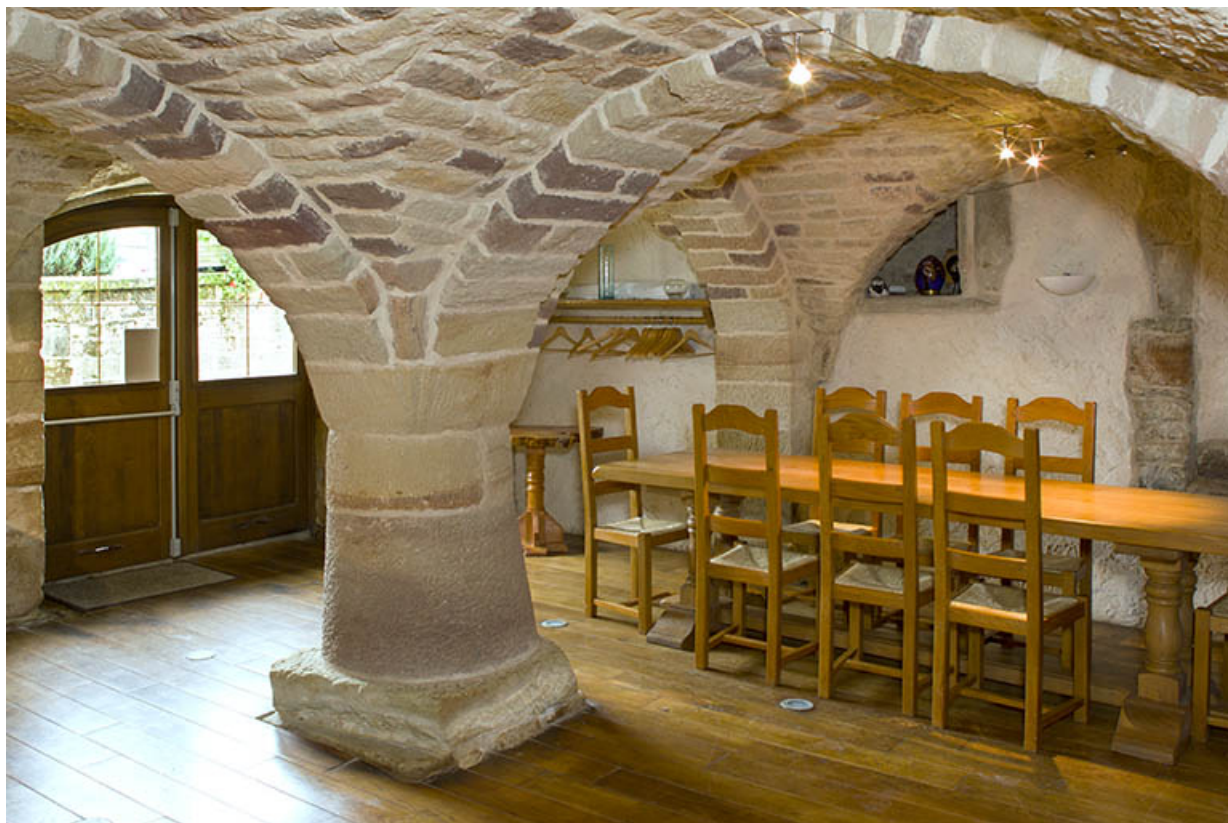
Vue sur le pilier central de la cave.
