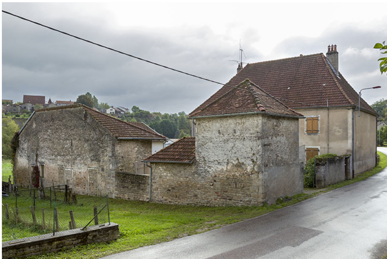
Vue d'ensemble depuis la rue du Presbytère. 70, Passavant-la-Rochère
