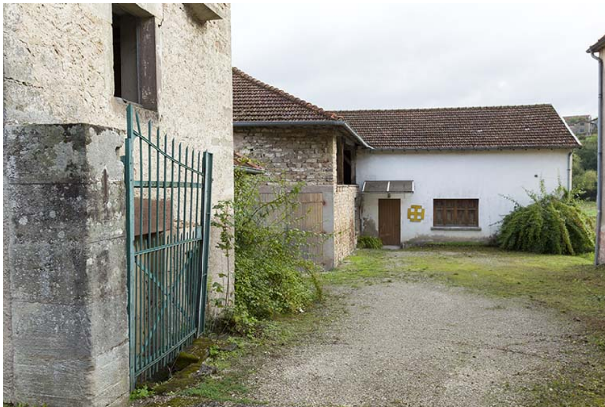
Vue sur la cour intérieure depuis la voie publique.
