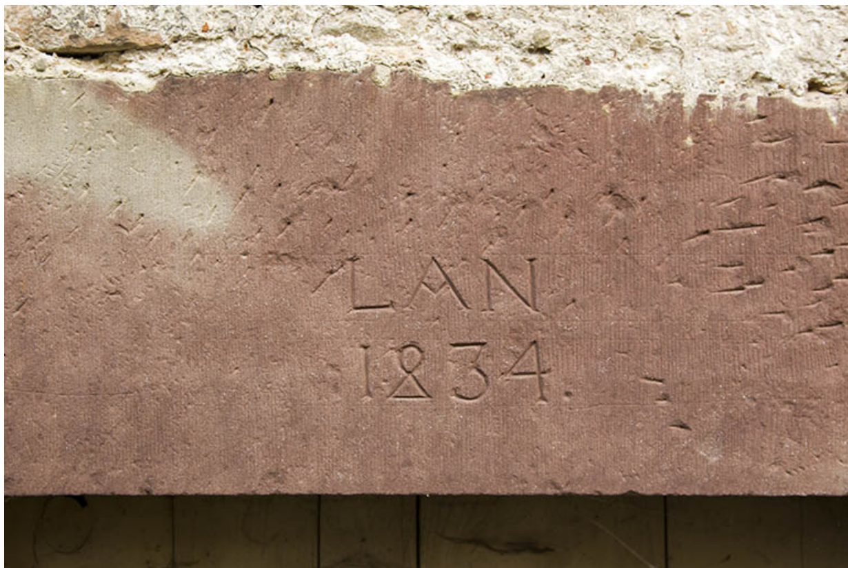
Détail d'une date portée. 70, Passavant-la-Rochère
