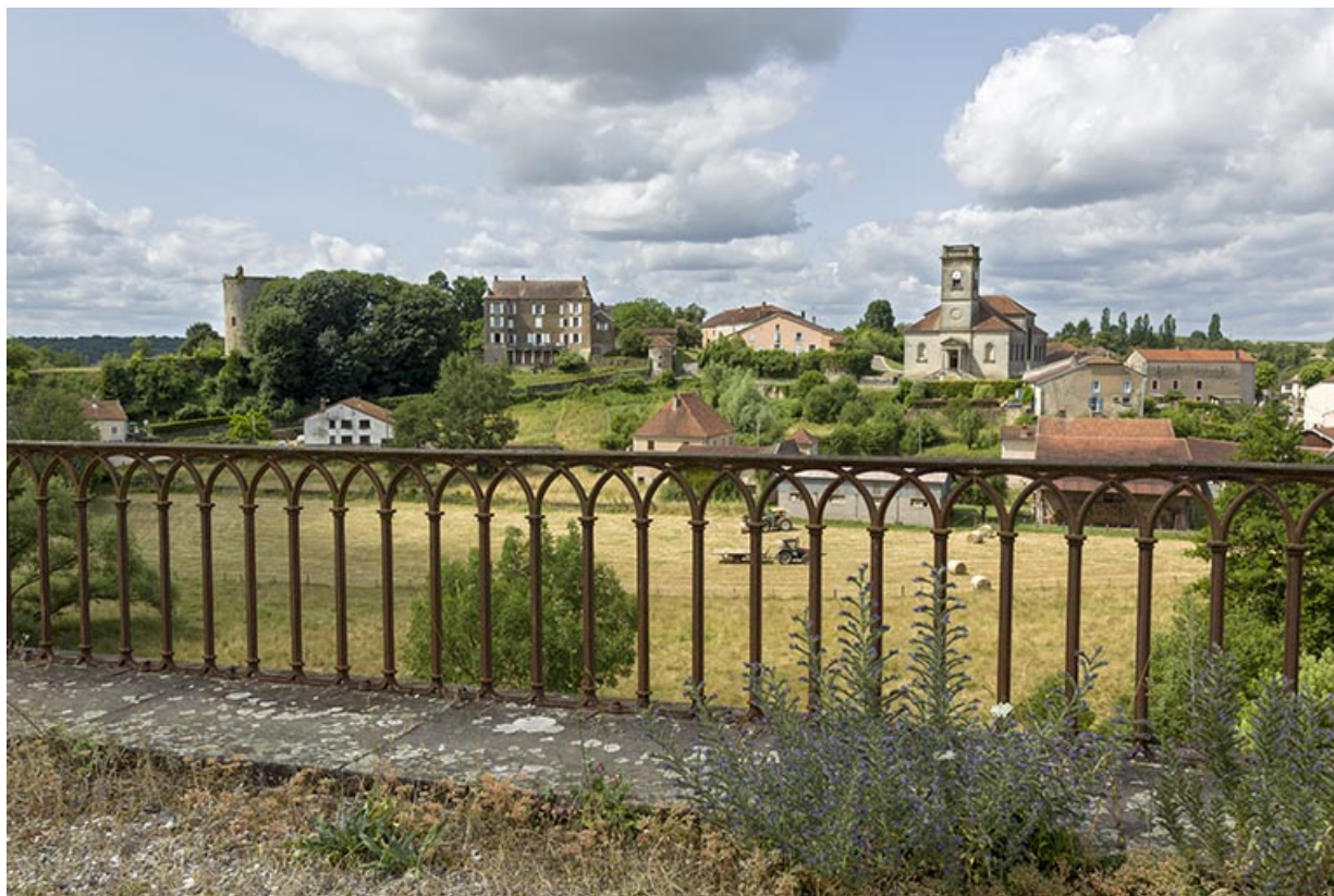
Vue sur le village de Passavant depuis le viaduc.
