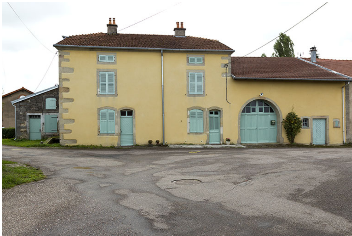
Ferme, rue de la Pompe. 70, Passavant-la-Rochère
