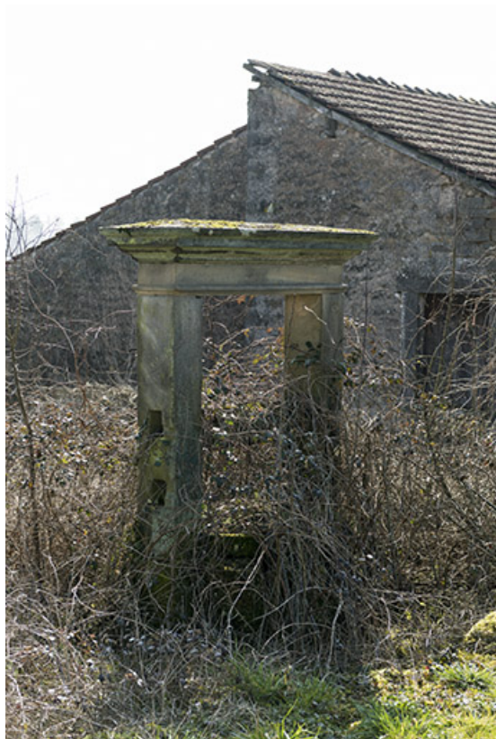
Ancien puits du bourg fortifié.
