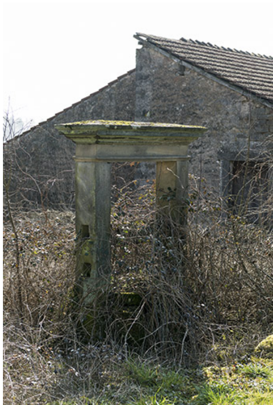
Ancien puits du bourg fortifié.
