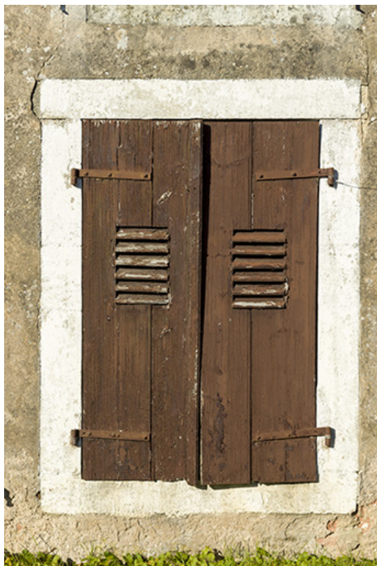
Détail d'une baie avec ses volets.
