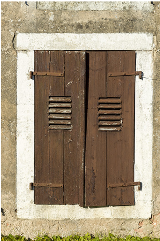
Détail d'une baie avec ses volets.
