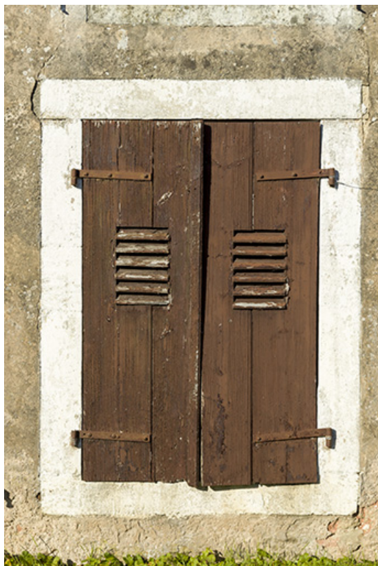
Détail d'une baie avec ses volets.
