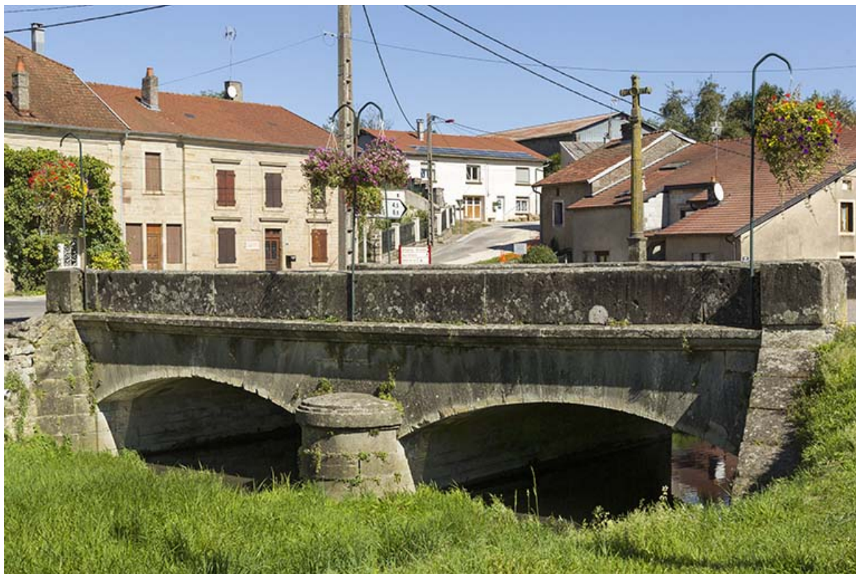
Pont avec une croix enjambant le ruisseau de la Noué. 70, Passavant-la-Rochère
