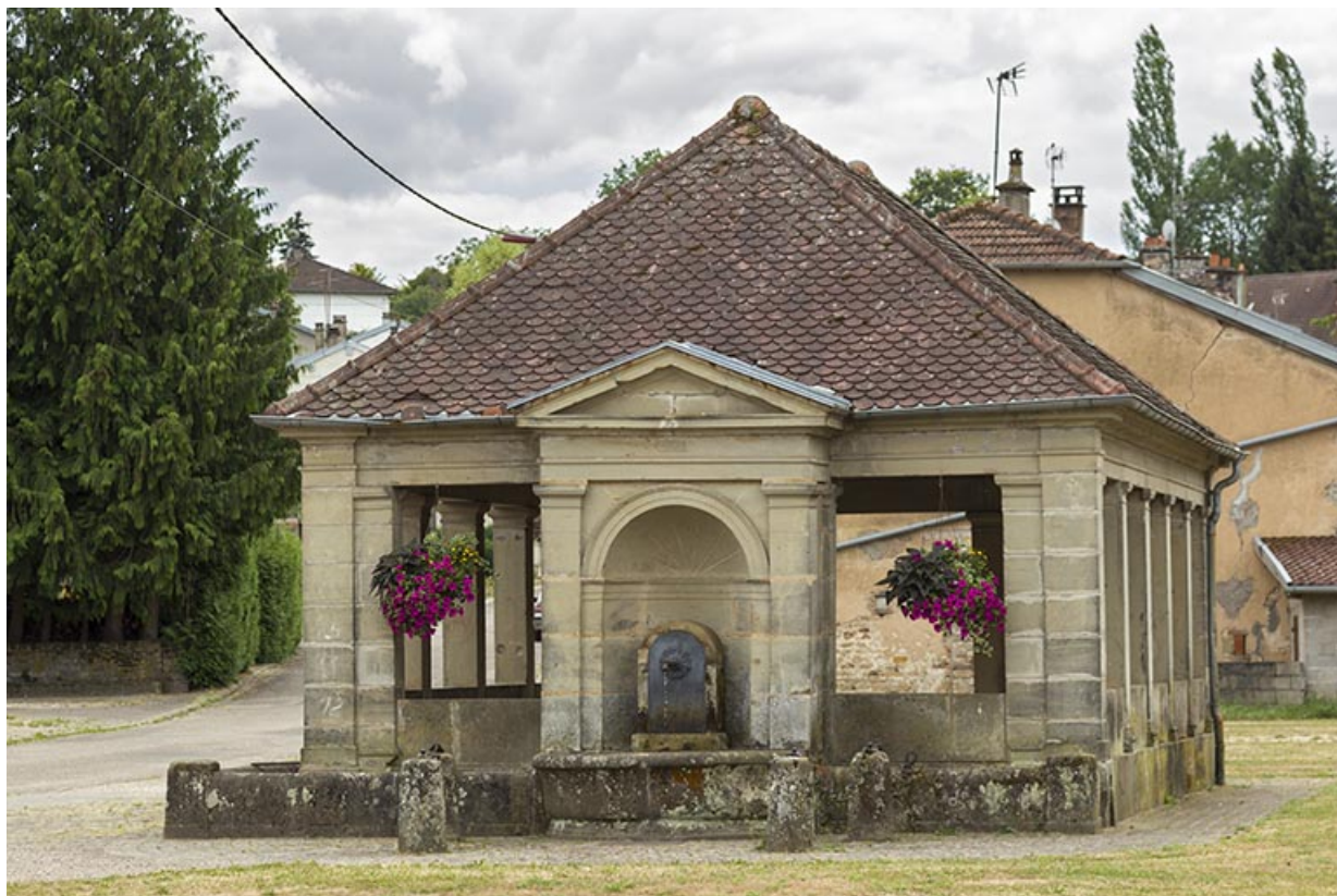
Fontaine-lavoir de la rue Charrière de Vouécourt.
