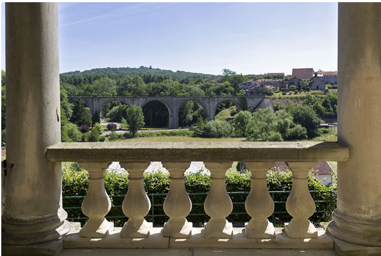
Vue sur la côte et le viaduc depuis la demeure Dutailly.
