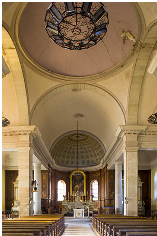
Vue générale de l'intérieur de l'édifice.
