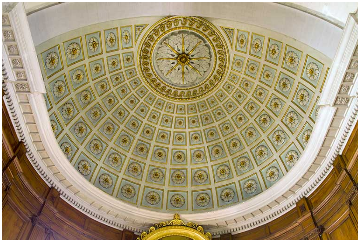
Voûte à caissons, chœur de l'église.
