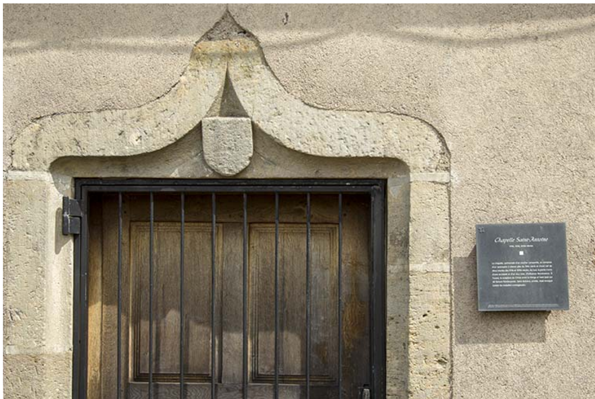
Détail sur la porte ornée d'une accolade, façade sud.
