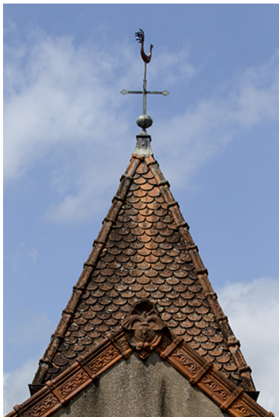
Campanile avec son toit en pavillon.
