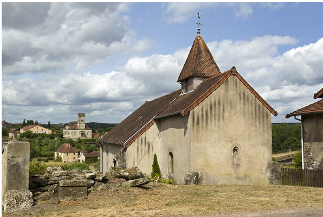
Vue depuis la rue Saint-Antoine.
