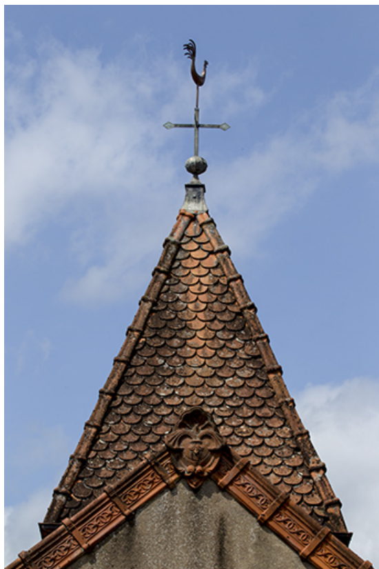
Campanile avec son toit en pavillon.
