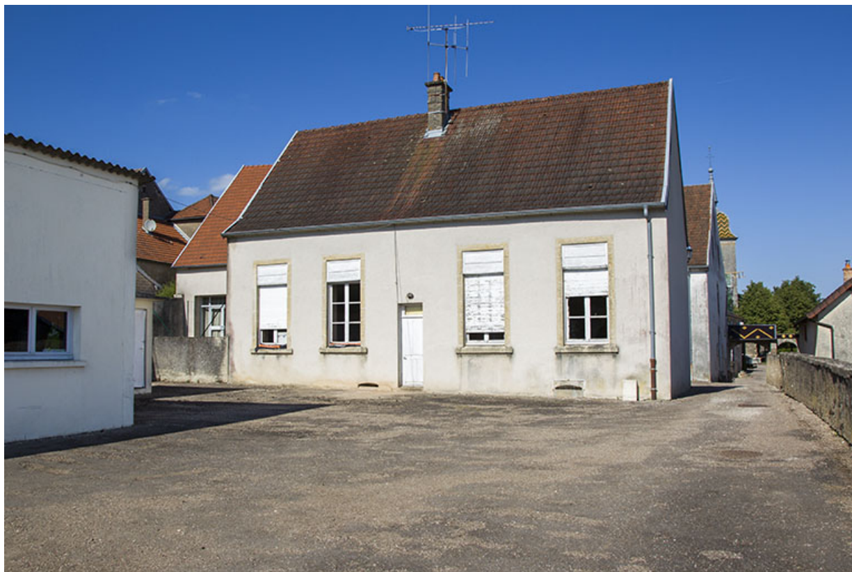
Ancienne école de garçons : façade postérieure, de trois quarts droite.
