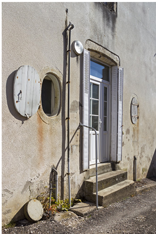
Façade latérale gauche : porte encadrée par deux oculi.
