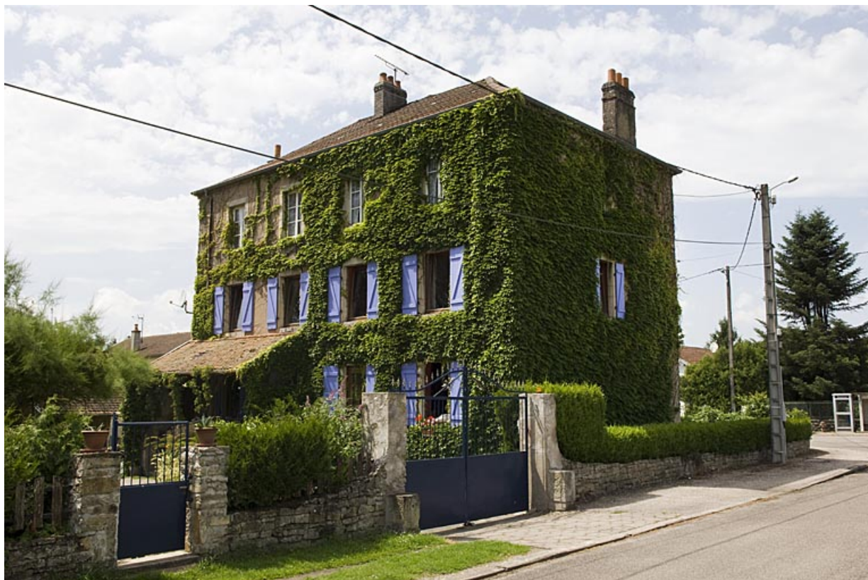
Façade postérieure, vue de trois quarts droit.
