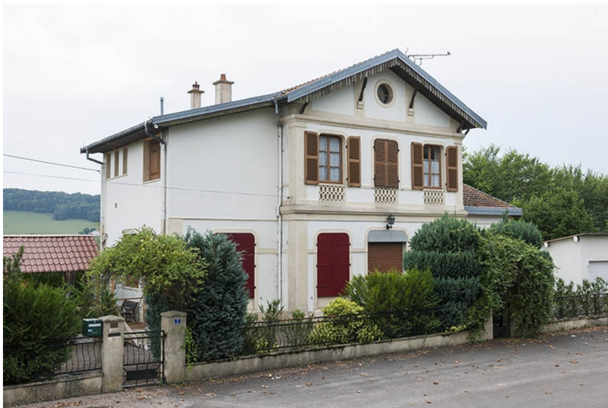
Vue générale de trois quart gauche depuis l'avenue de la Gare.
