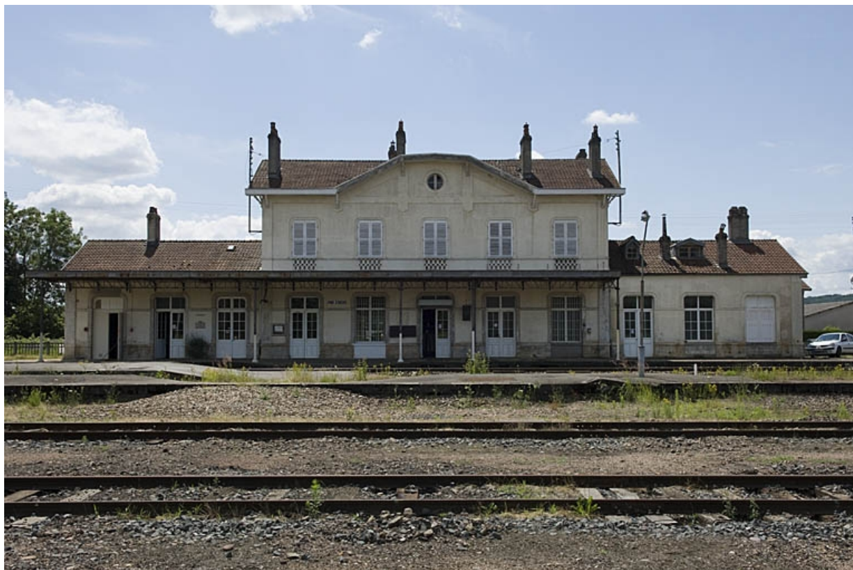
Bâtiment des voyageurs : vue générale depuis les voies.
