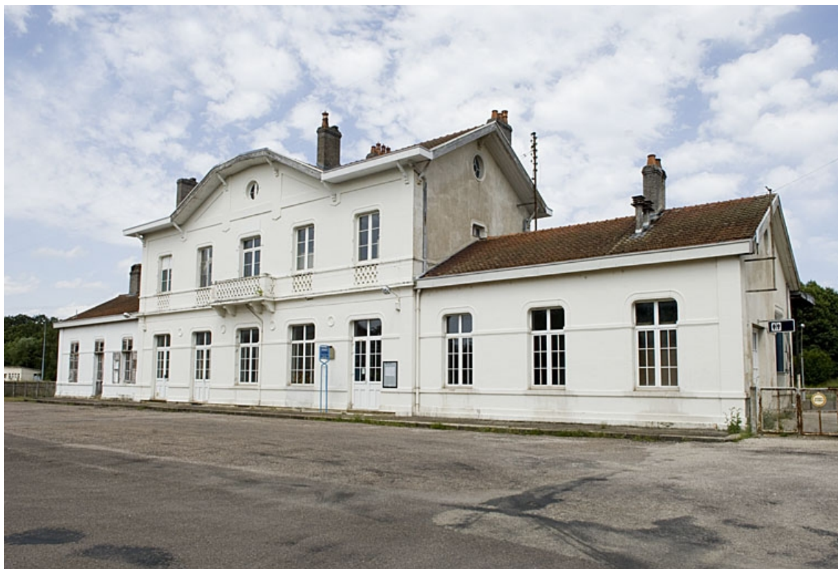
Bâtiment des voyageurs : vue générale depuis l'esplanade.
