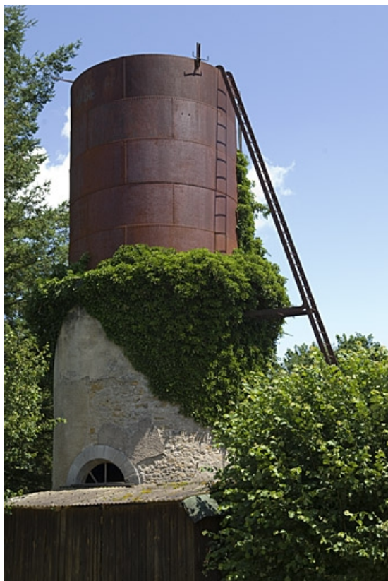
Maison de garde-barrière sud, route d'Amoncourt : vue générale du château d'eau. 70, Favorney
