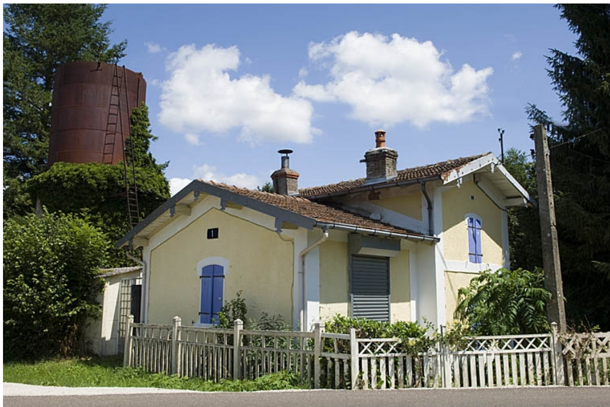
Maison de garde-barrière sud (cadastrée 1996 F 868), route d'Amoncourt, et son château d'eau. 70, Favorney
