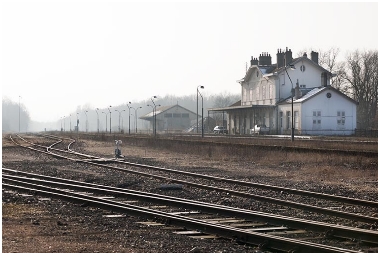
Vue d'ensemble de la gare des voyageurs et de celle des marchandises. 70, Favorney
