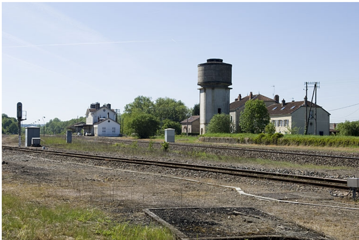
Vue générale du site depuis le nord. 70, Favorney
