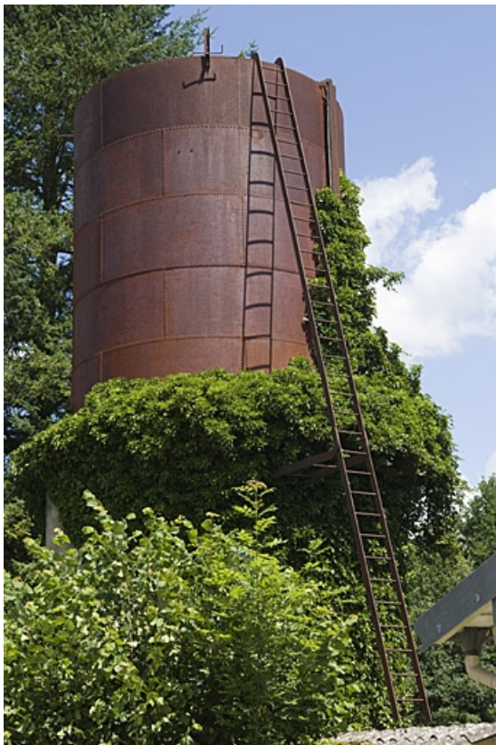
Maison de garde-barrière sud, route d'Amoncourt : le château d'eau. 70, Faverney
