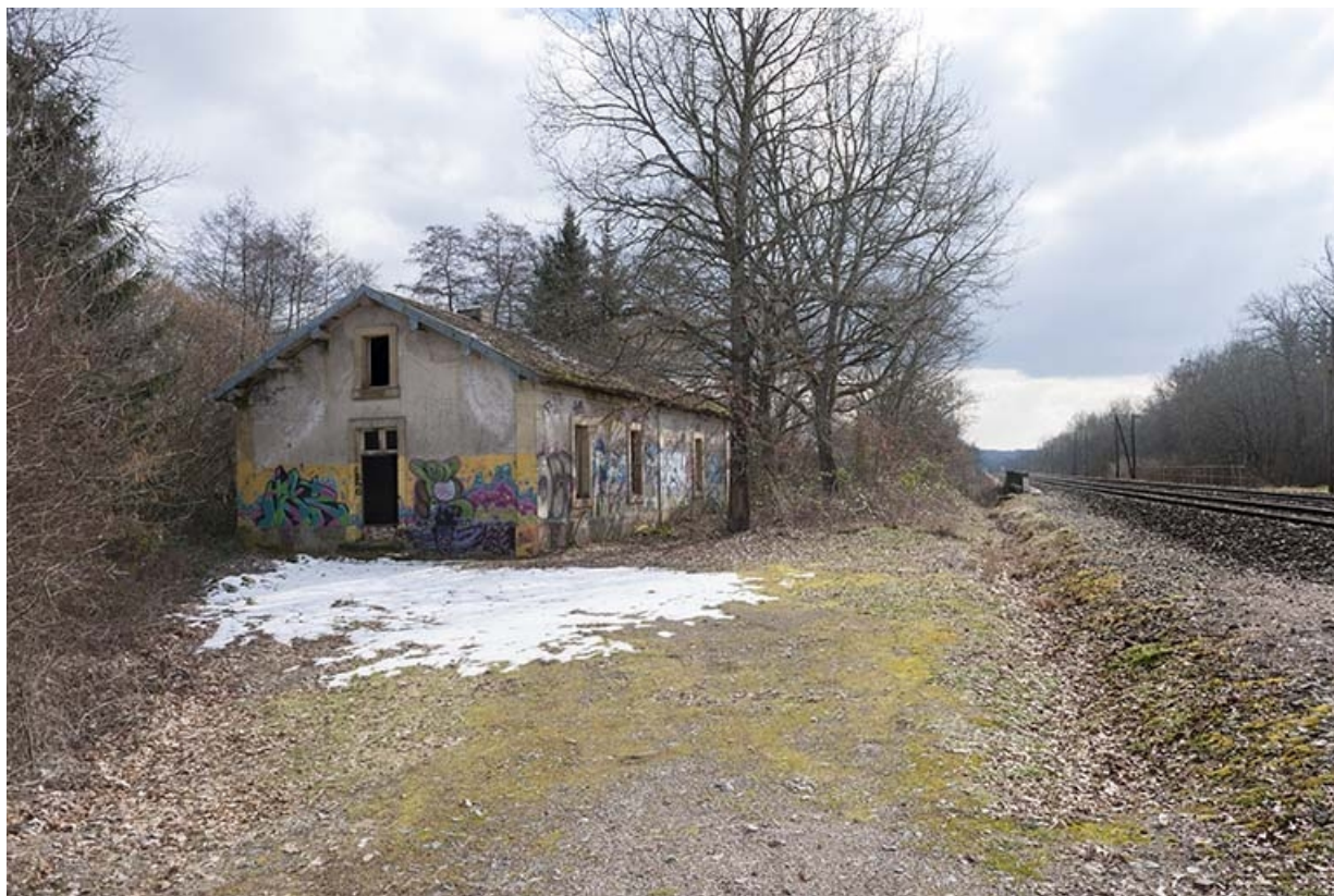
Station de pompage ayant abrité la machine à vapeur : vue générale. 70, Favorney
