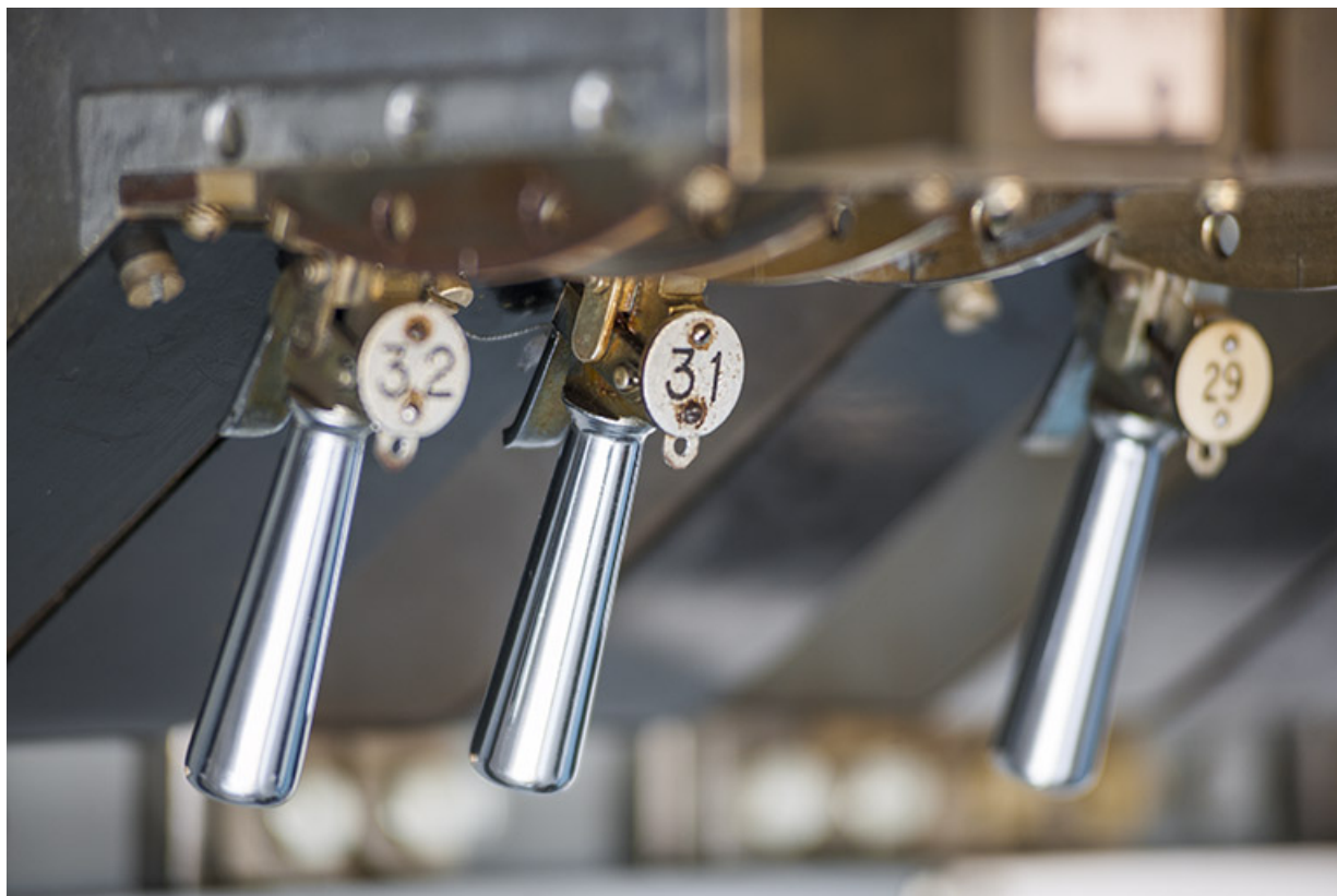
Gare de Port-d'Atelier, poste d'aiguillage : détail des manettes de commande de la signalisation. 70, Faverney
