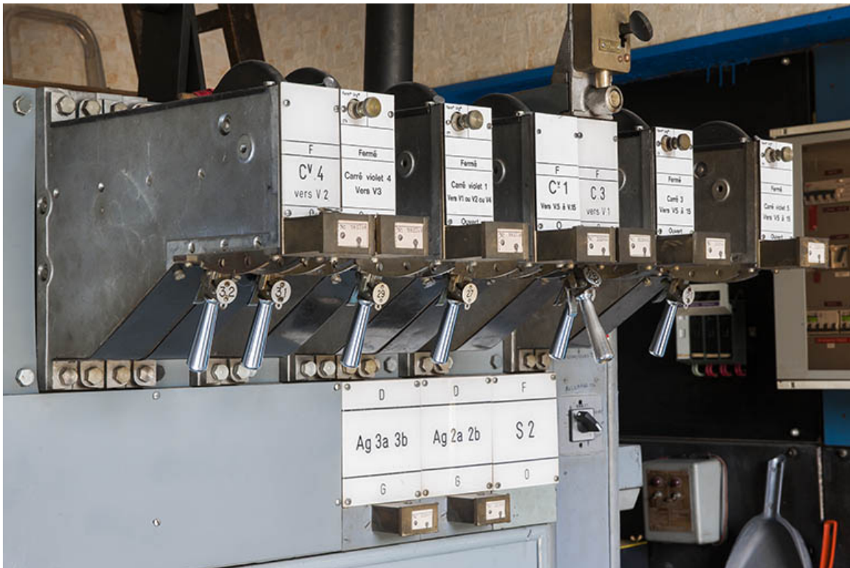
Gare de Port-d'Atelier, poste d'aiguillage : manettes de commande de la signalisation. 70, Favorney
