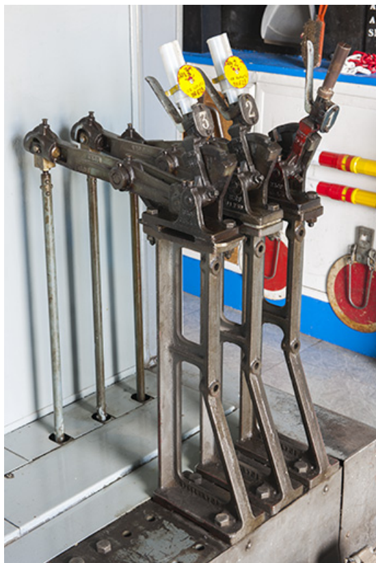
Gare de Port-d'Atelier, poste d'aiguillage : manettes de commande. 70, Favorney
