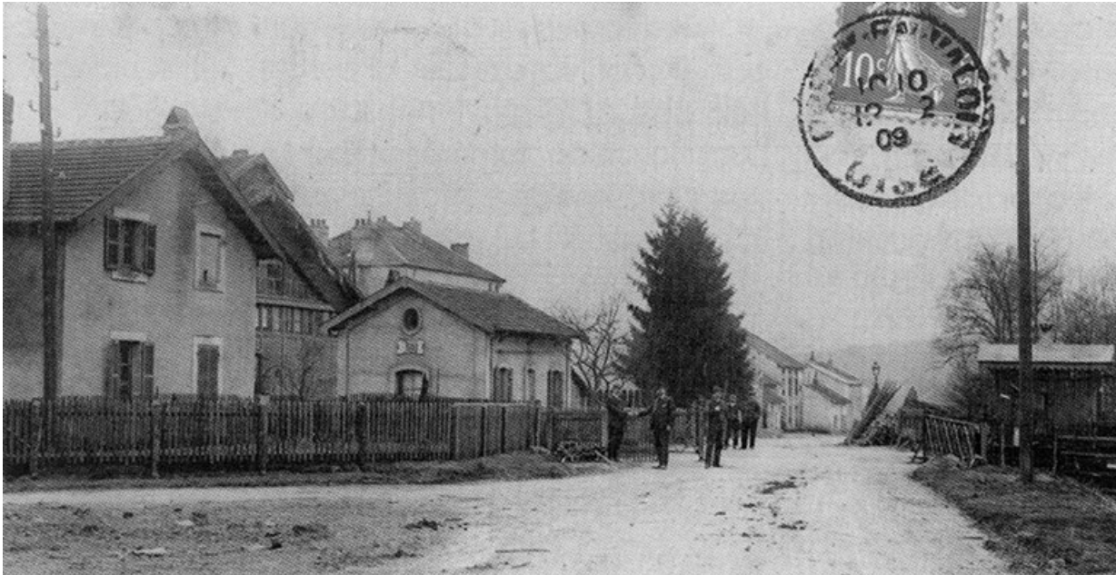
Maison de garde-barrière en gare de Port-d'Atelier-Amance, 1er quart 20e siècle. 70, Faverney
