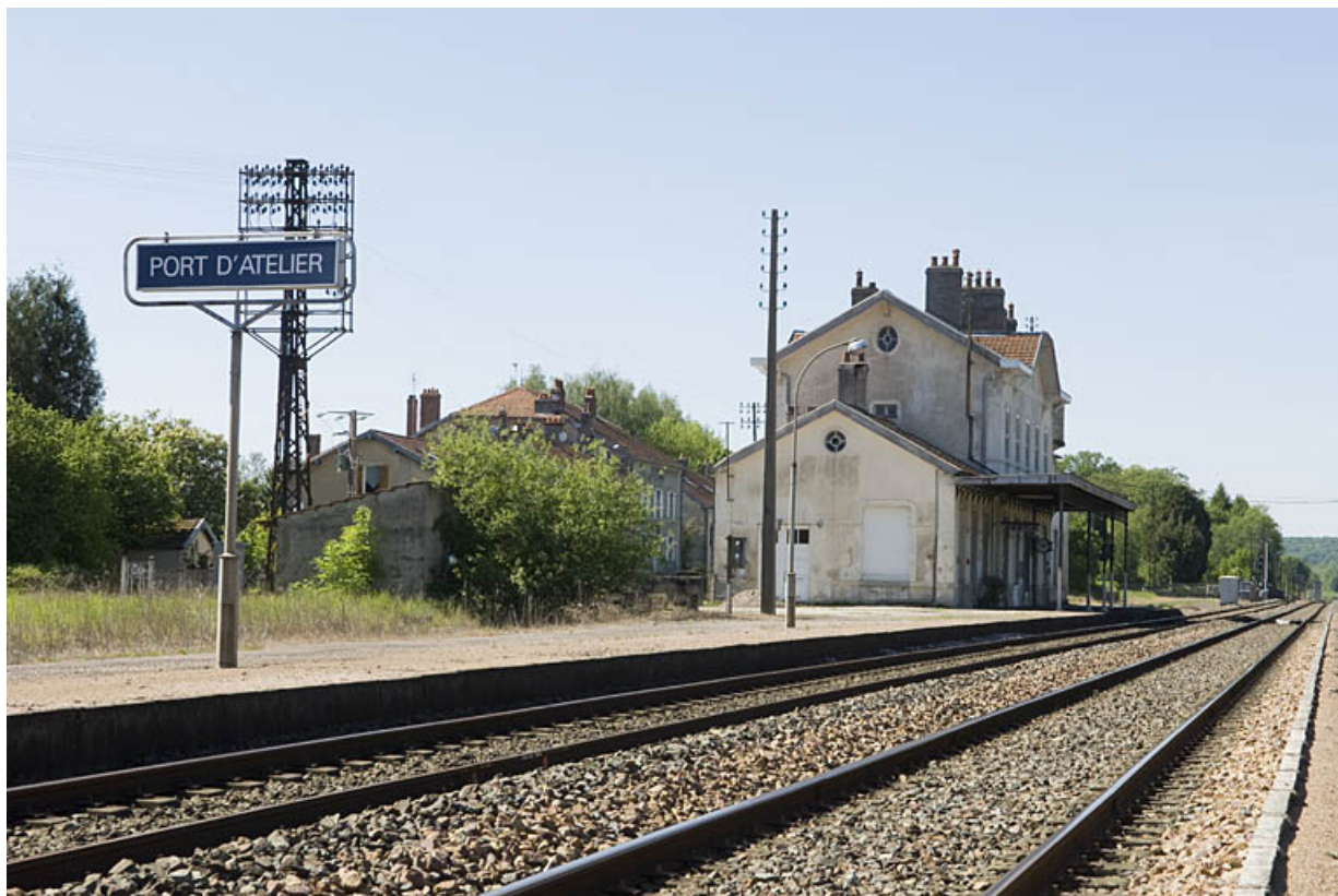
Gare de Port-d'Atelier : vue générale de la gare des voyageurs depuis le sud-est. 70, Faverney
