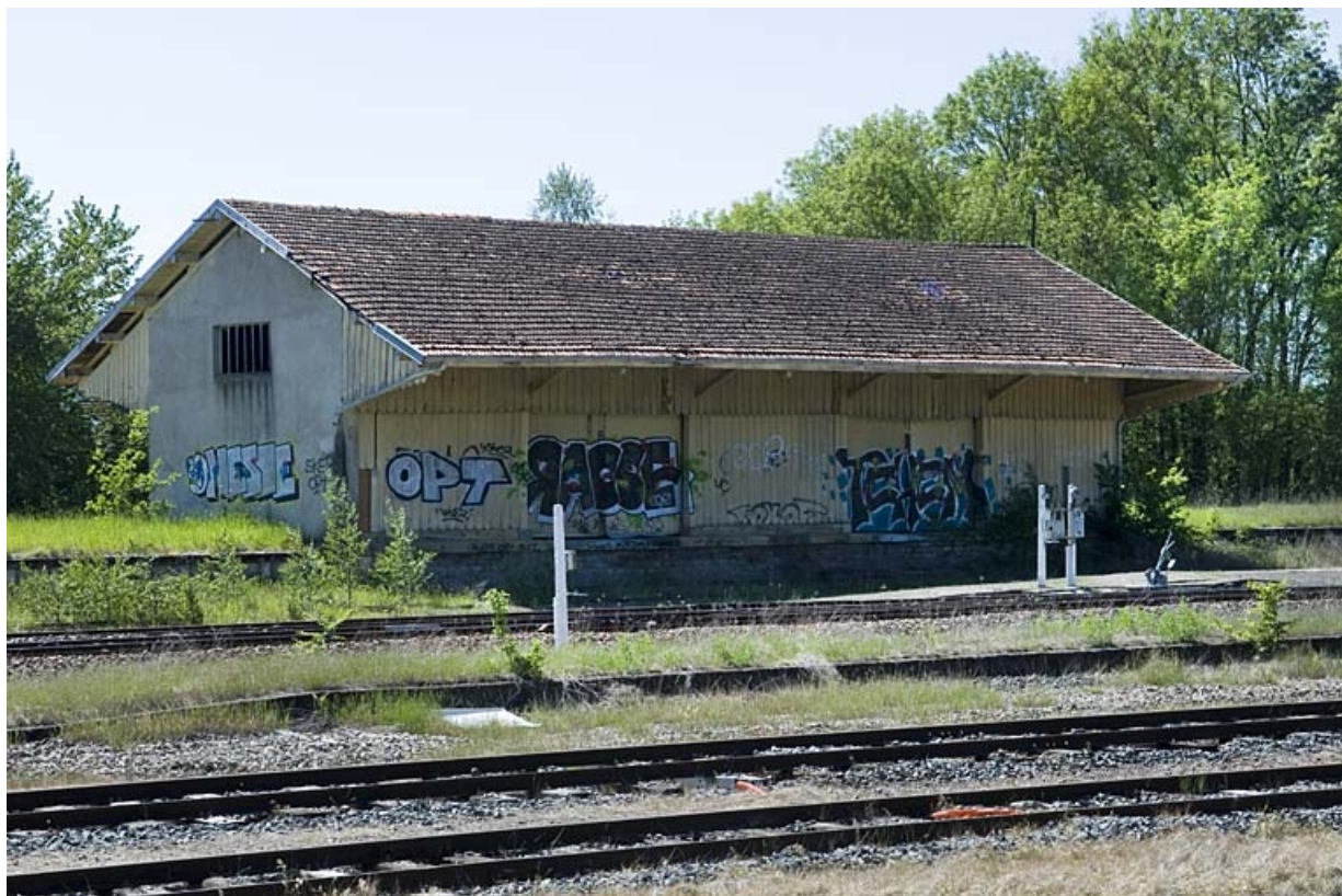
Gare de Port-d'Atelier : halle dans l'emprise de la gare. 70, Faverney
