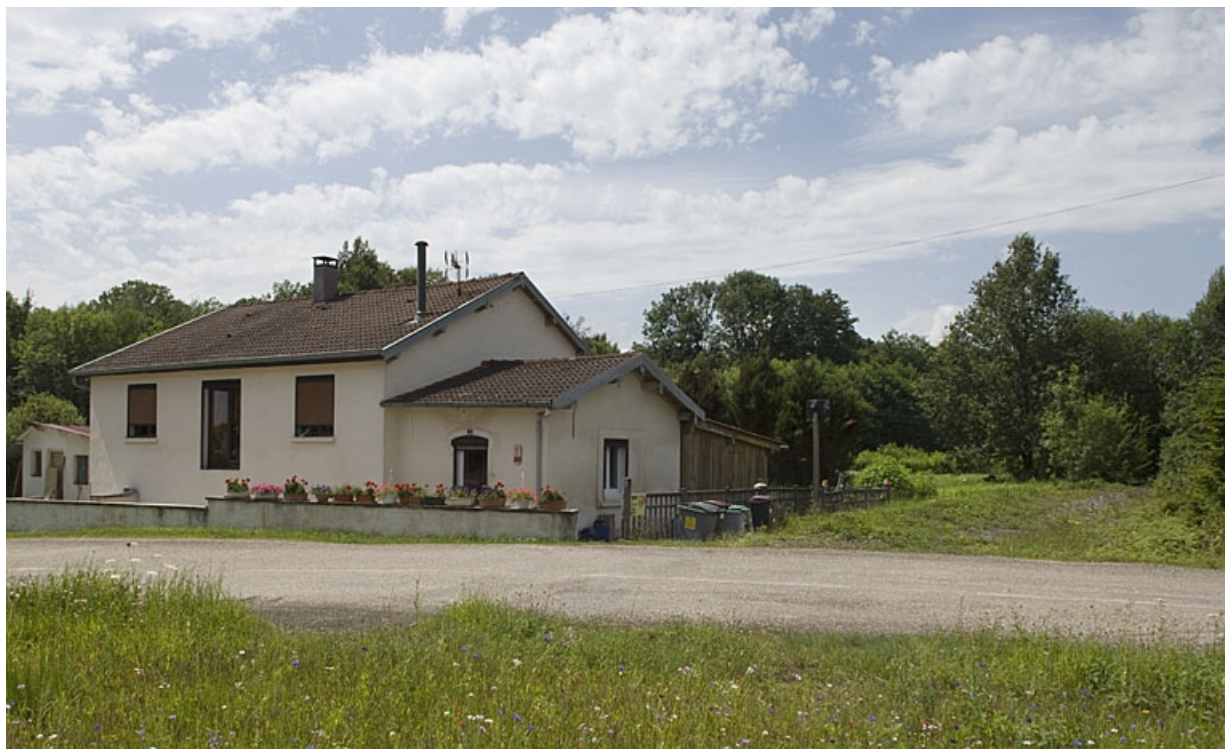
Maison de garde-barrière nord (cadastrée 1996 F 431-432), route d'Amoncourt. 70, Faverney
