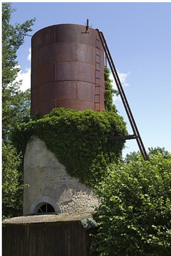
Maison de garde-barrière sud, route d'Amoncourt : vue générale du château d'eau. 70, Faverney
