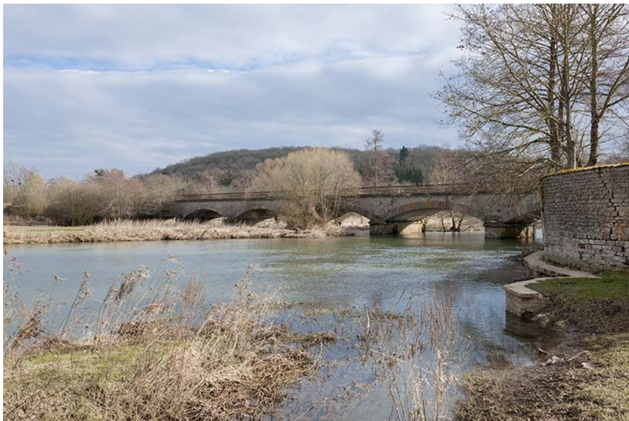
Pont ferroviaire sur la Lanterne (ligne Nancy-Gray). 70, Favorney
