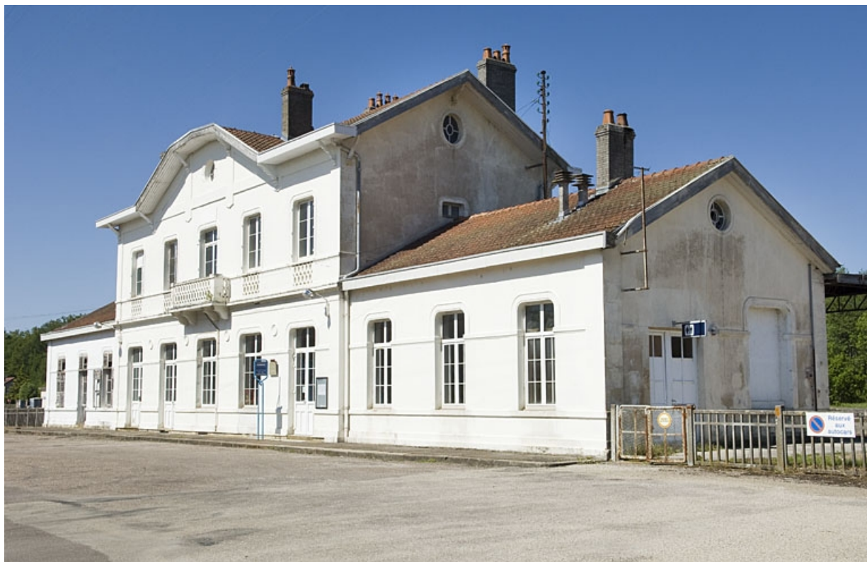
Gare de Port-d'Atelier : vue générale de la gare de voyageurs depuis l'esplanade. 70, Favorney
