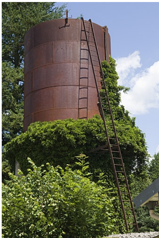
Maison de garde-barrière sud, route d'Amoncourt : le château d'eau. 70, Favorney
