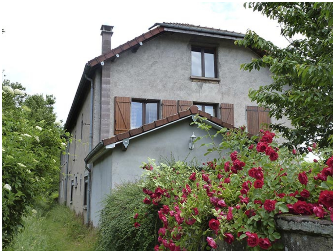
Bâtiment au long du canal : façade sud.
