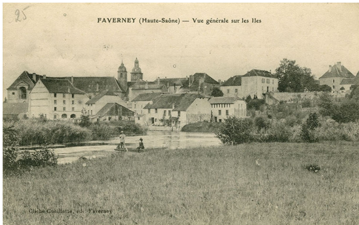
Favorney (haute-Saône) - Vue générale sur les Iles [vue d'ensemble des bâtiments sur la rive droite du canal du Moulin], limite 19e siècle 20e siècle.
