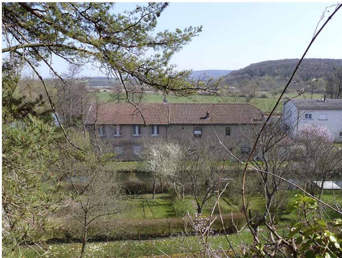
Vue générale des deux bâtiments, depuis l'ouest.
