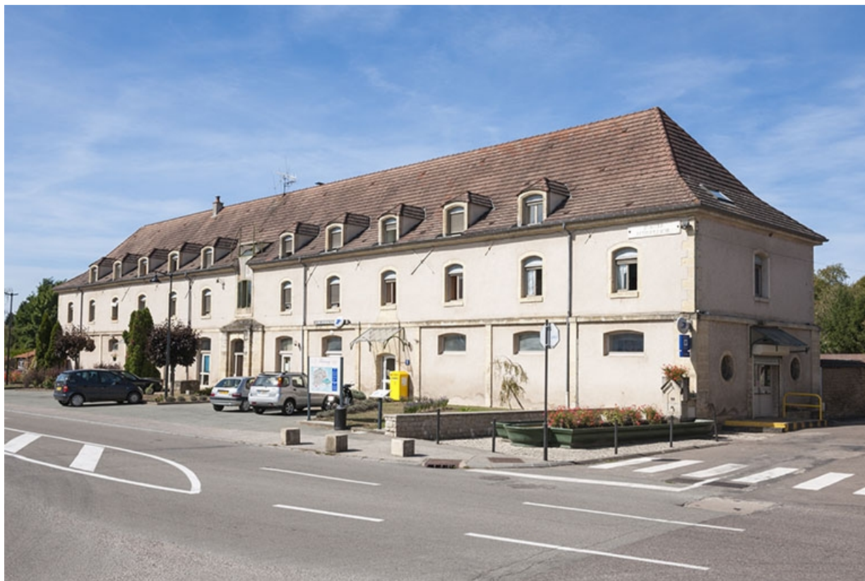
Vue de trois quart à l'angle de la place du Général de Gaulle et de la rue Catinat. 70, Favorney place du Général de Gaulle
