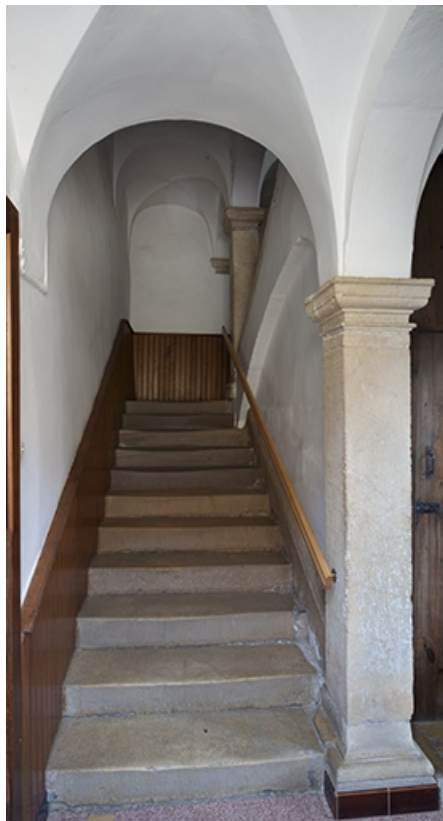
Départ de l'escalier intérieur conduisant à l'étage.
