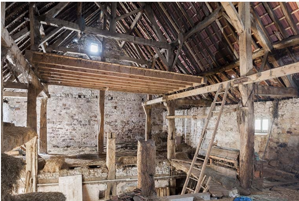
Intérieur de la grange.
