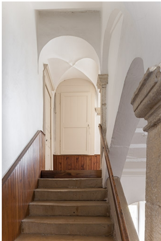
Escalier intérieur conduisant à l'étage.
