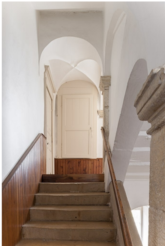
Escalier intérieur conduisant à l'étage.
