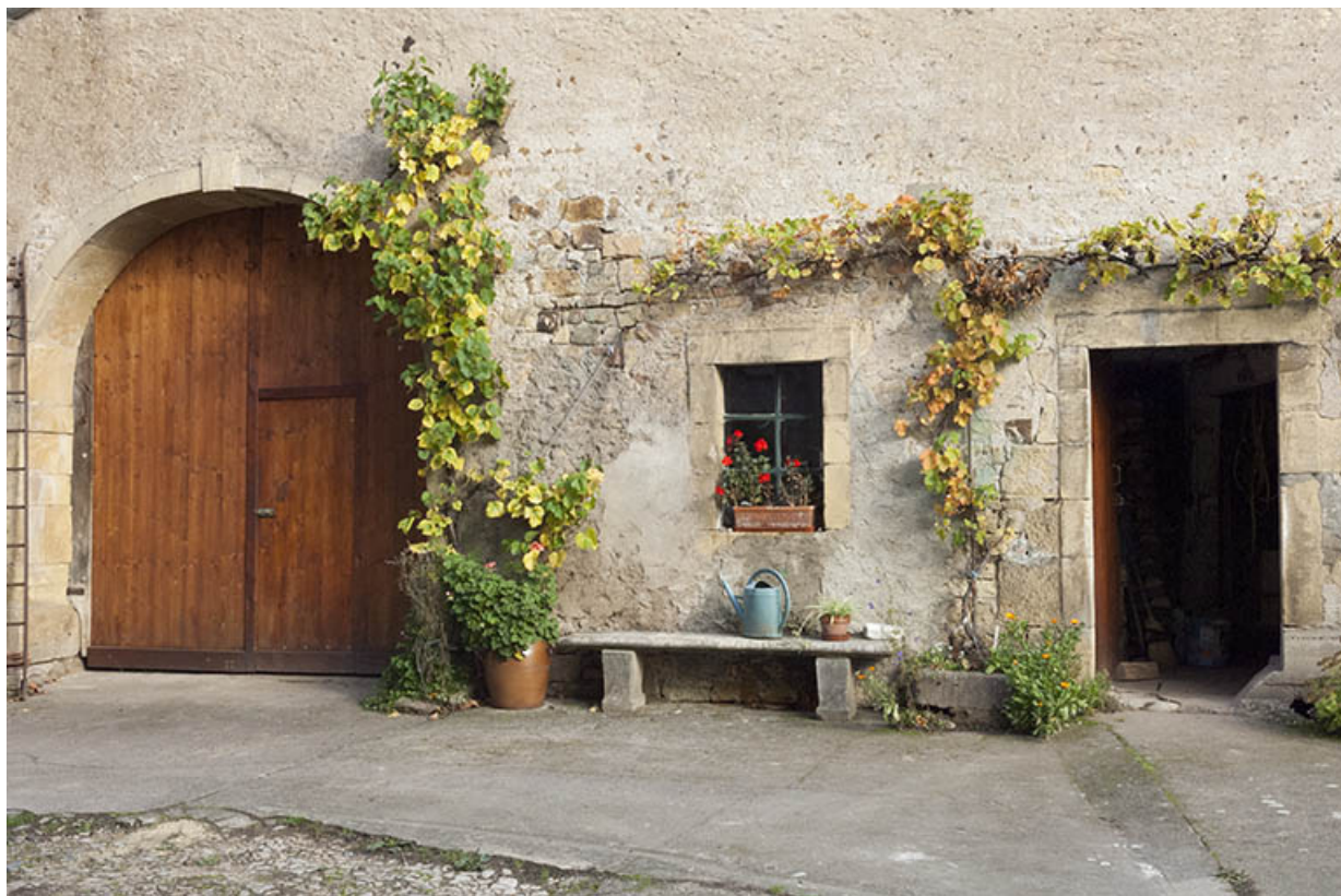
Façade antérieure du bâtiment abritant les parties agricoles.
