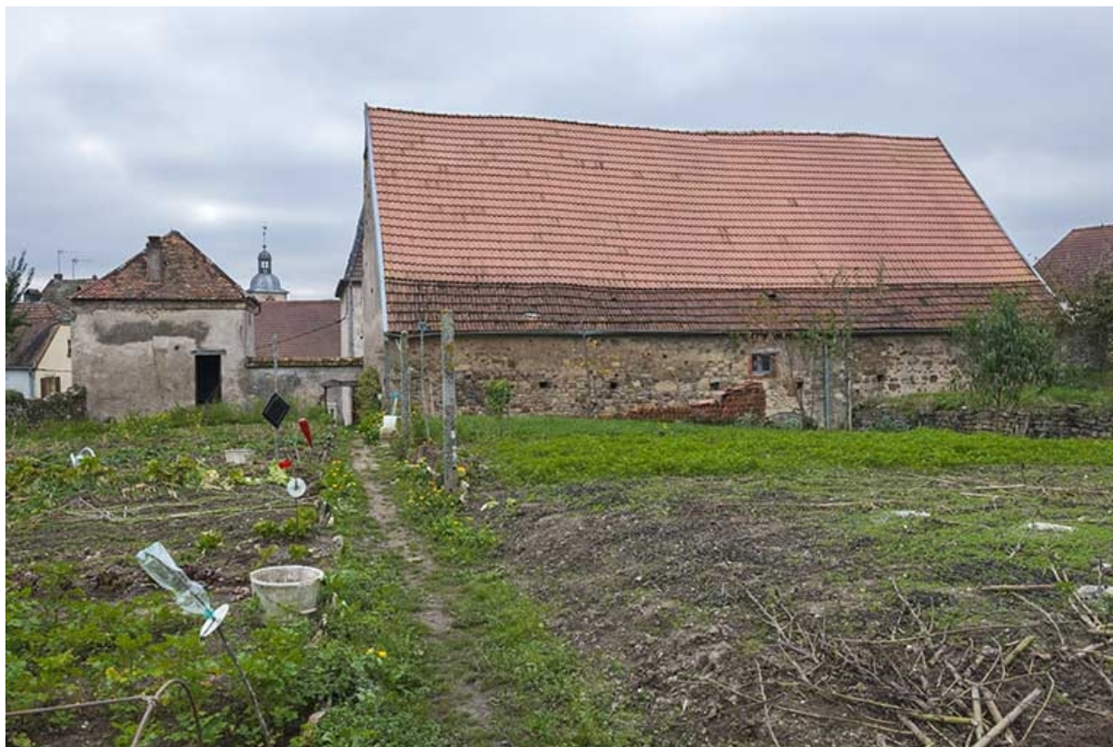
Façades postérieure du bâtiment abritant les parties agricoles.
