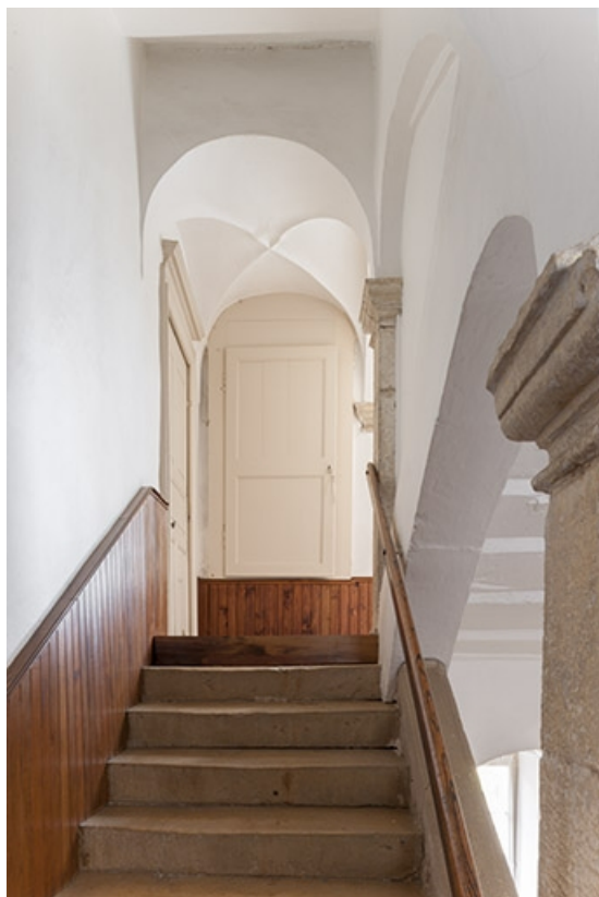
Escalier intérieur conduisant à l'étage.
