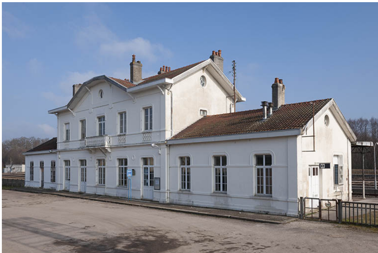
Port-d'Atelier : vue générale de la gare. 70, Faverney
