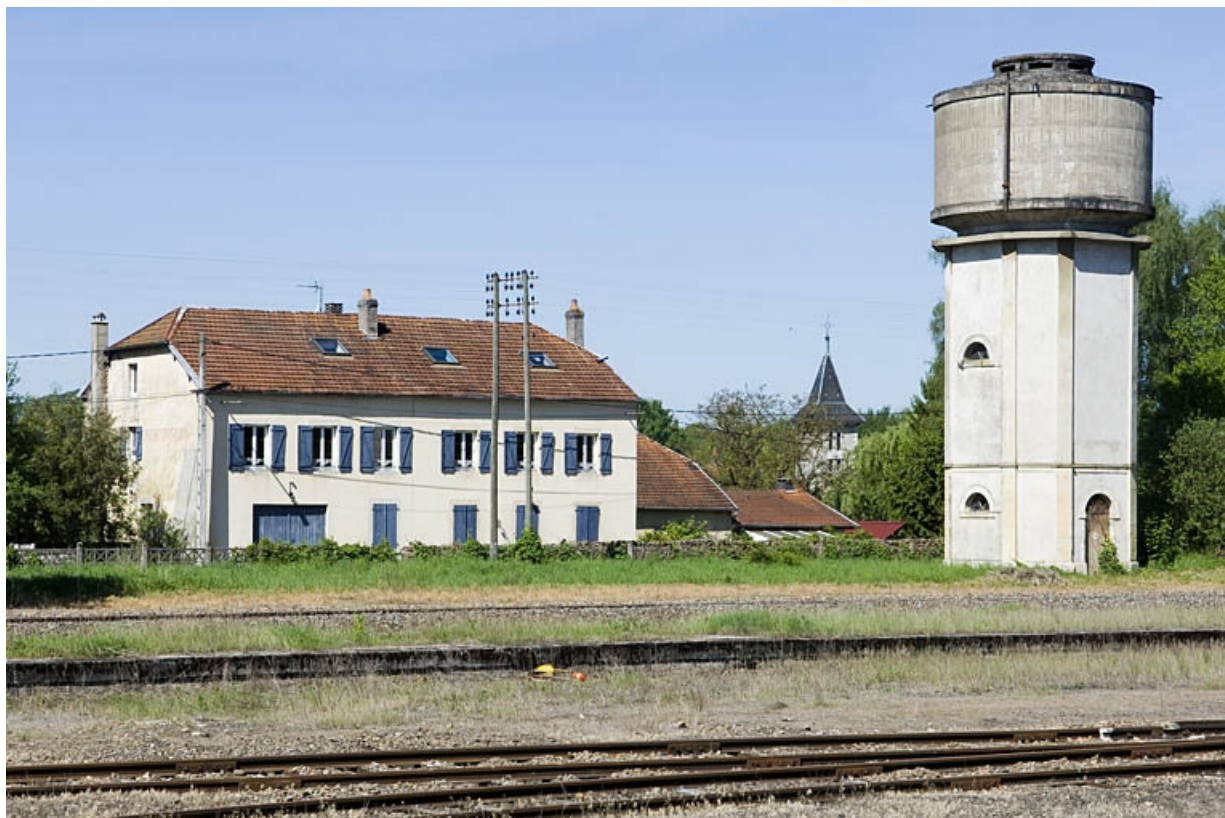
Port-d'Atelier, vu depuis le quai de la gare (ancien hôtel de voyageurs Lavie et château d'eau). 70, Faverney
