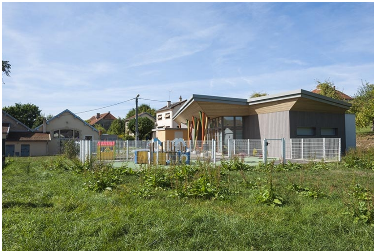
Vue d'ensemble de la crèche.
