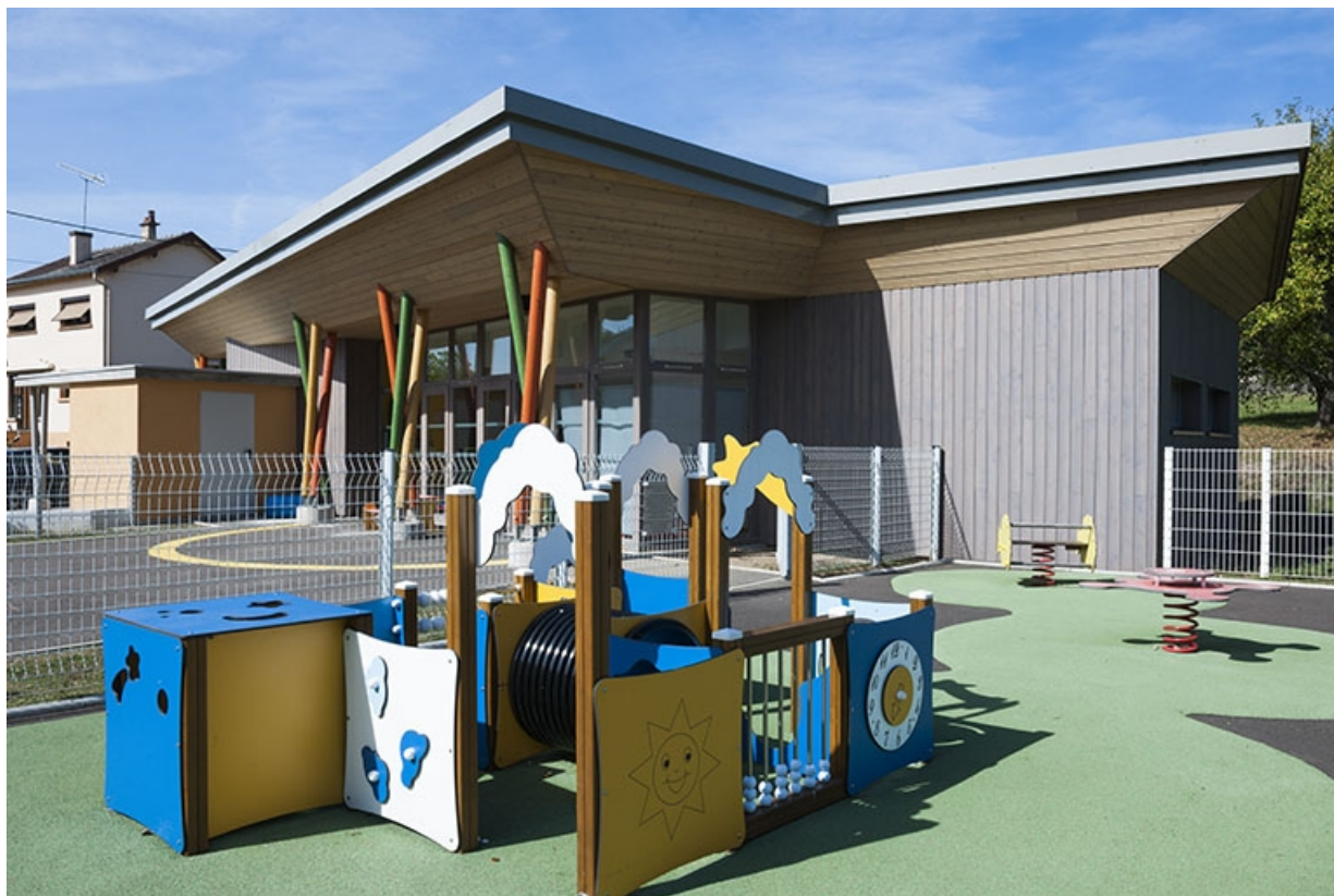
Vue générale de la crèche. 70, Faverney
