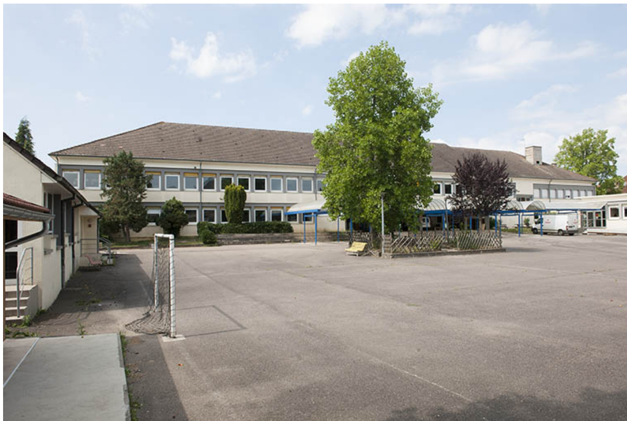
Vue générale sur la cour.
