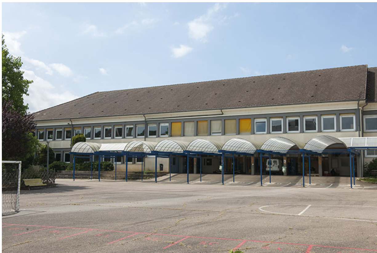
Façade du bâtiment depuis la cour.
