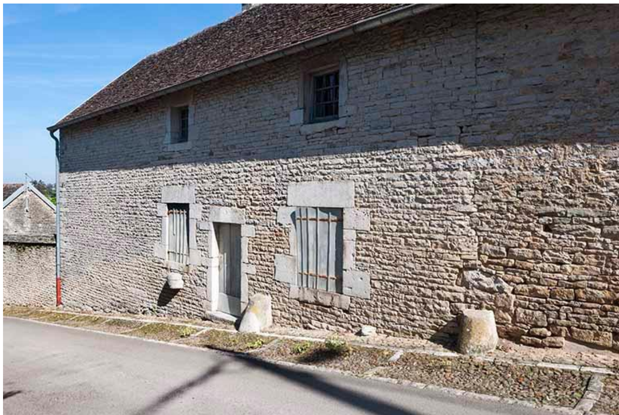
Ferme de la rue du Grand Mont 70, Gy
