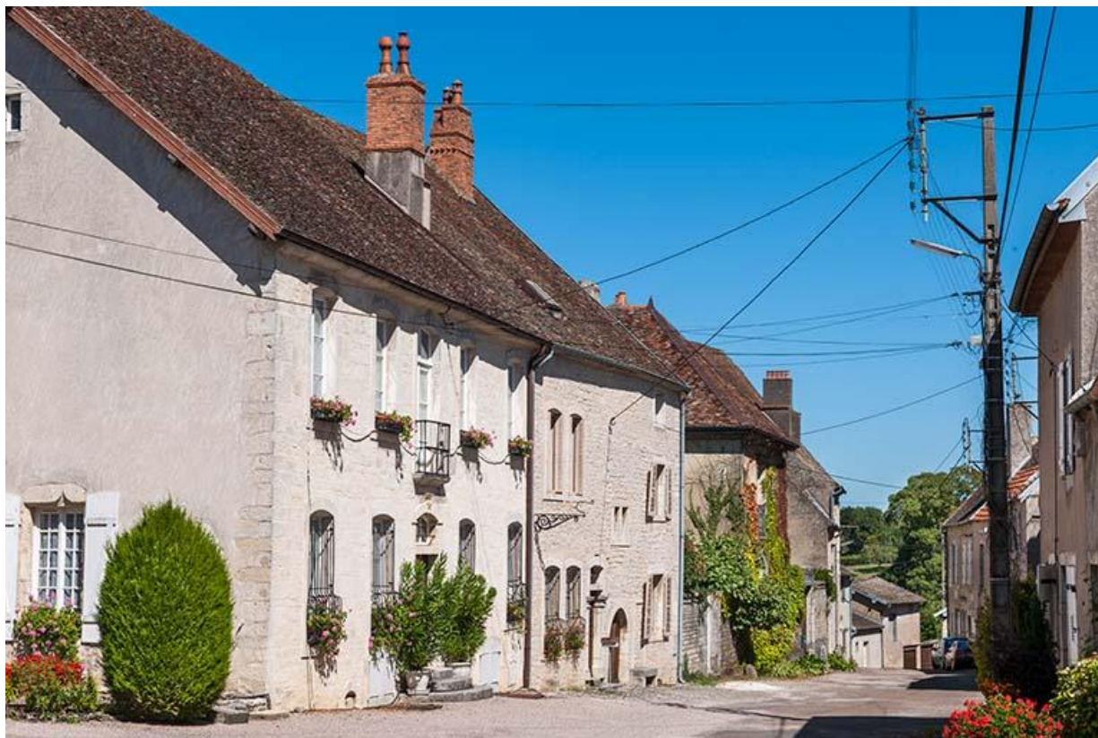
Vue générale depuis l'ouest 70, Gy
