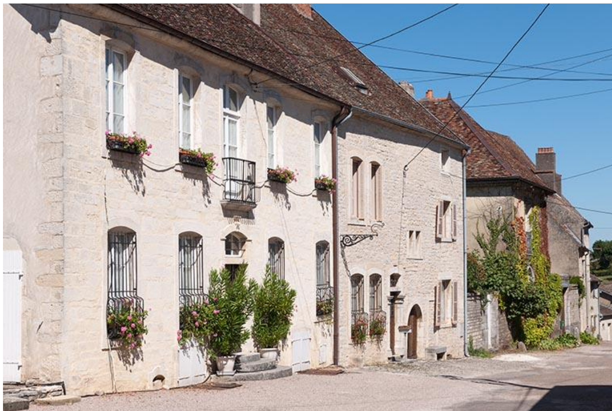
Bâtiments de la Place du Bourg 70, Gy
