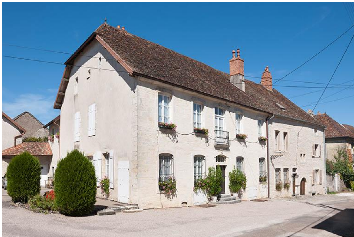
Vue générale sud-ouest 70, Gy Rue du Bourg
