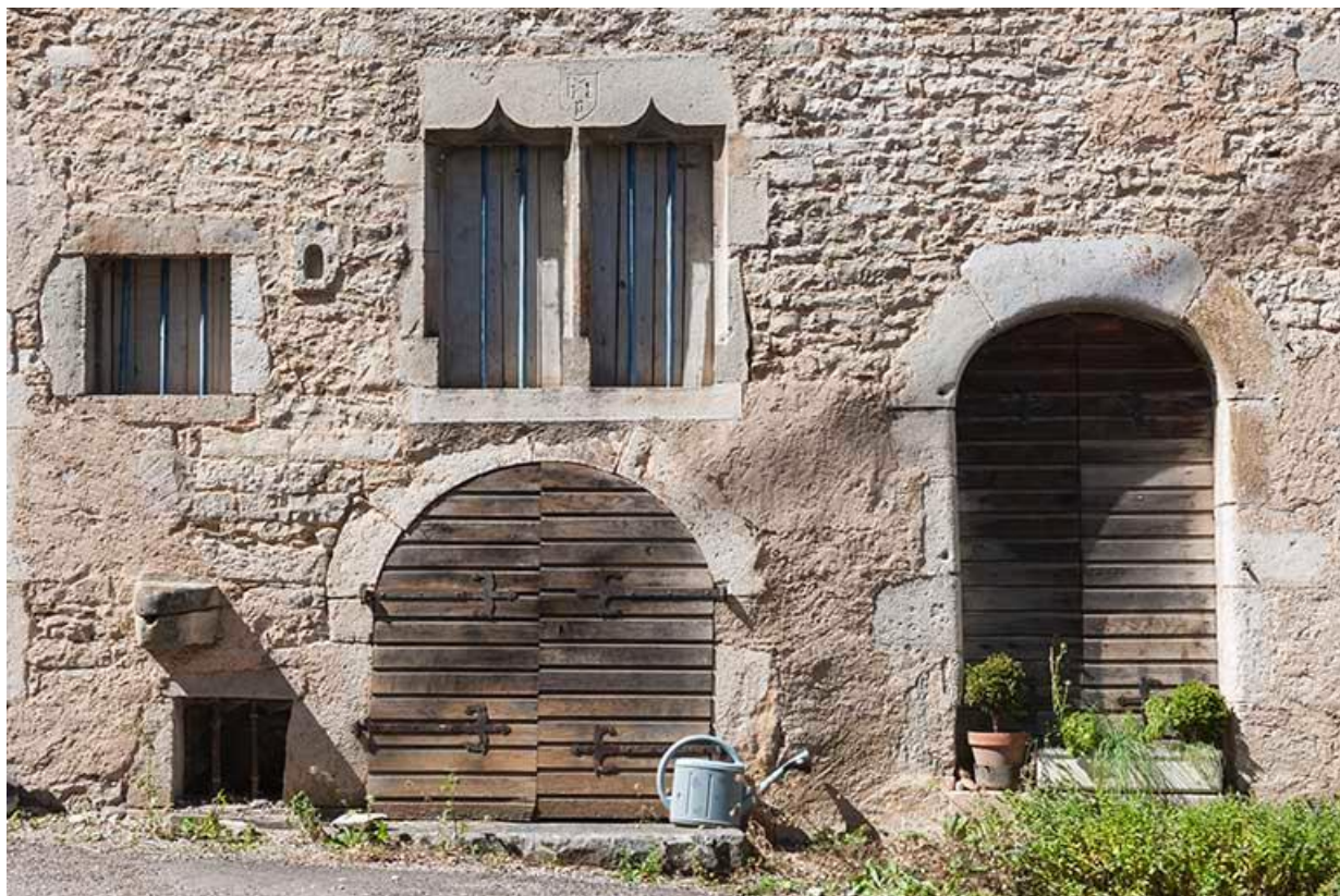
Détail des baies d'une maison de la partie est de la rue 70, Gy Rue du Bourg
