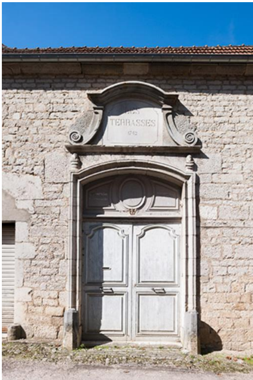
Porte du 6 rue du Bourg
