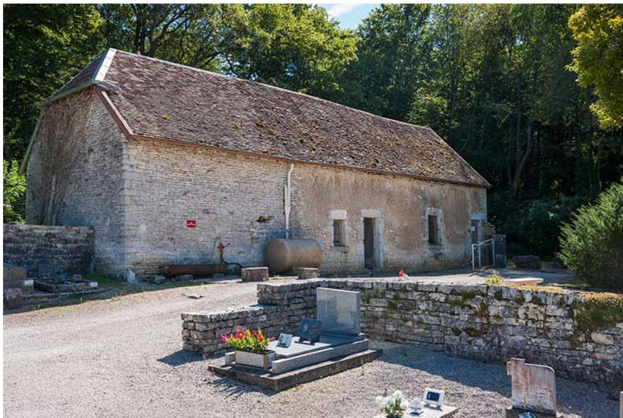
Ancienne ferme située au sud-ouest du cimetière
