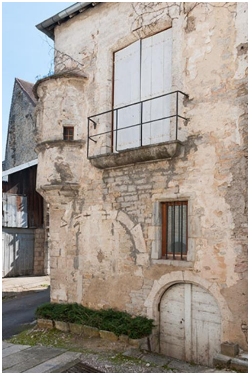
Façade nord, rue du Bourg
