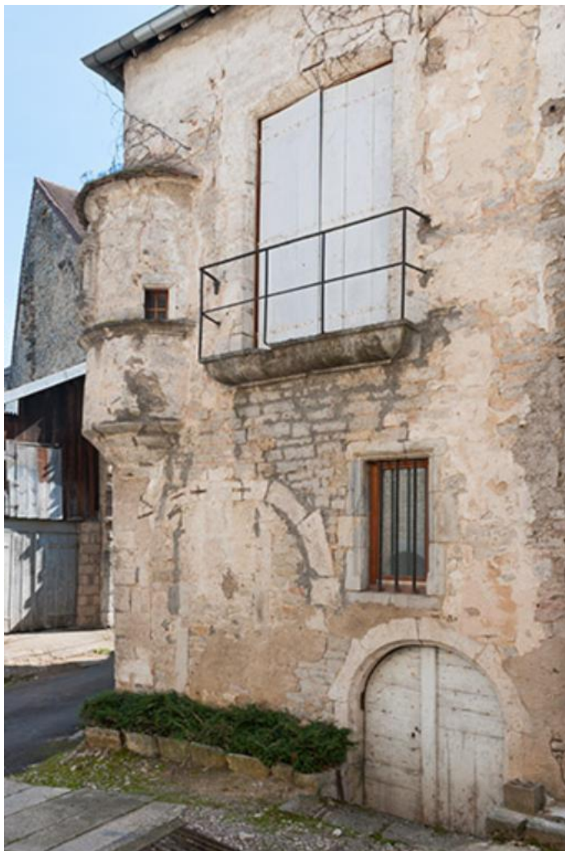
Façade nord, rue du Bourg
