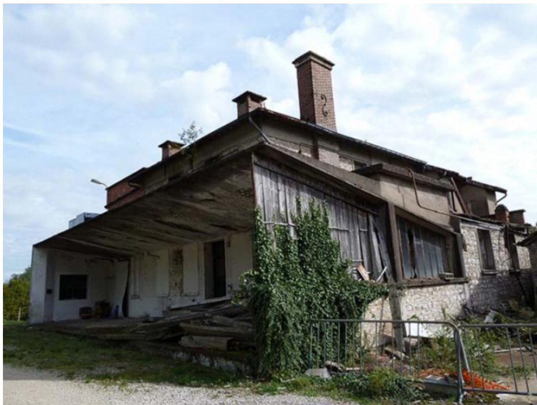
Vue générale nord ouest de la laiterie
