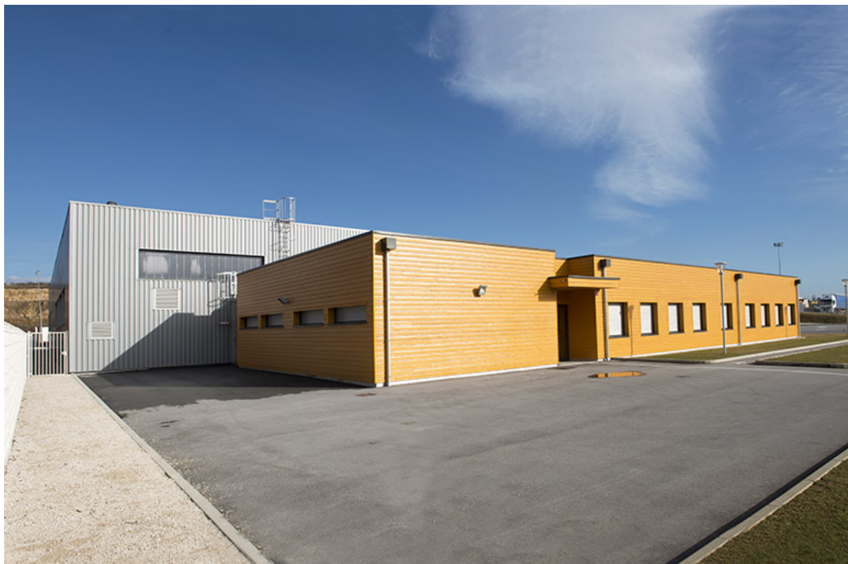
Angle nord-ouest, façade d'entrée ouest du bâtiment d'enseignement et angle nord-ouest de l'atelier. 70, Arc-lès-Gray Jean-Jaures avenue
