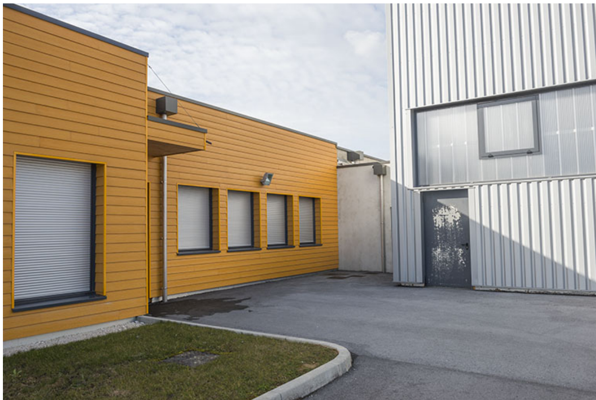
Facade et entrée est des salles de cours, jouxtant la chaufferie et les ateliers. 70, Arc-lès-Gray Jean-Jaures avenue
