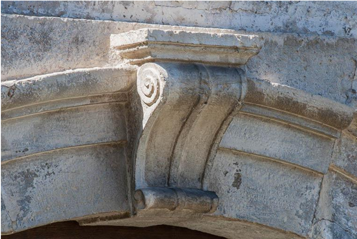
Détail de la porte 70, Gy Grande Rue
