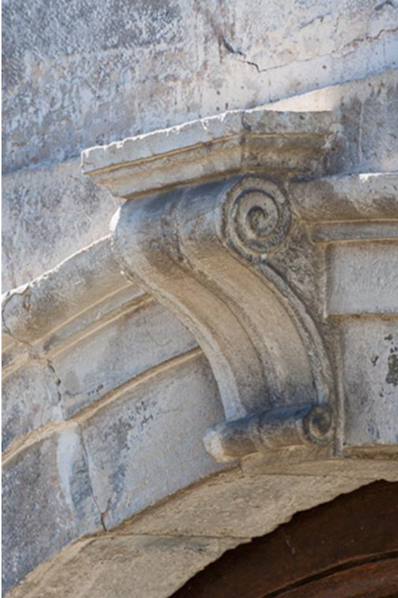
Détail de la porte 70, Gy Grande Rue
