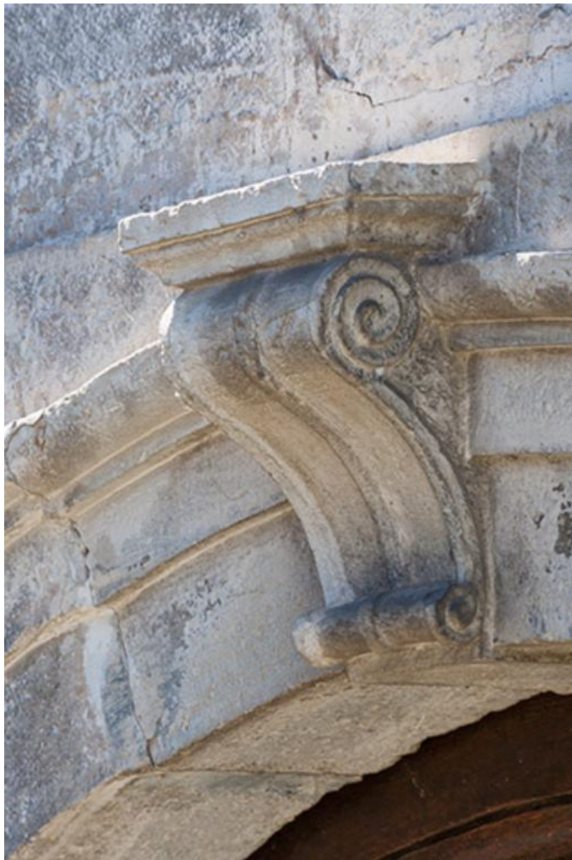
Détail de la porte 70, Gy Grande Rue
