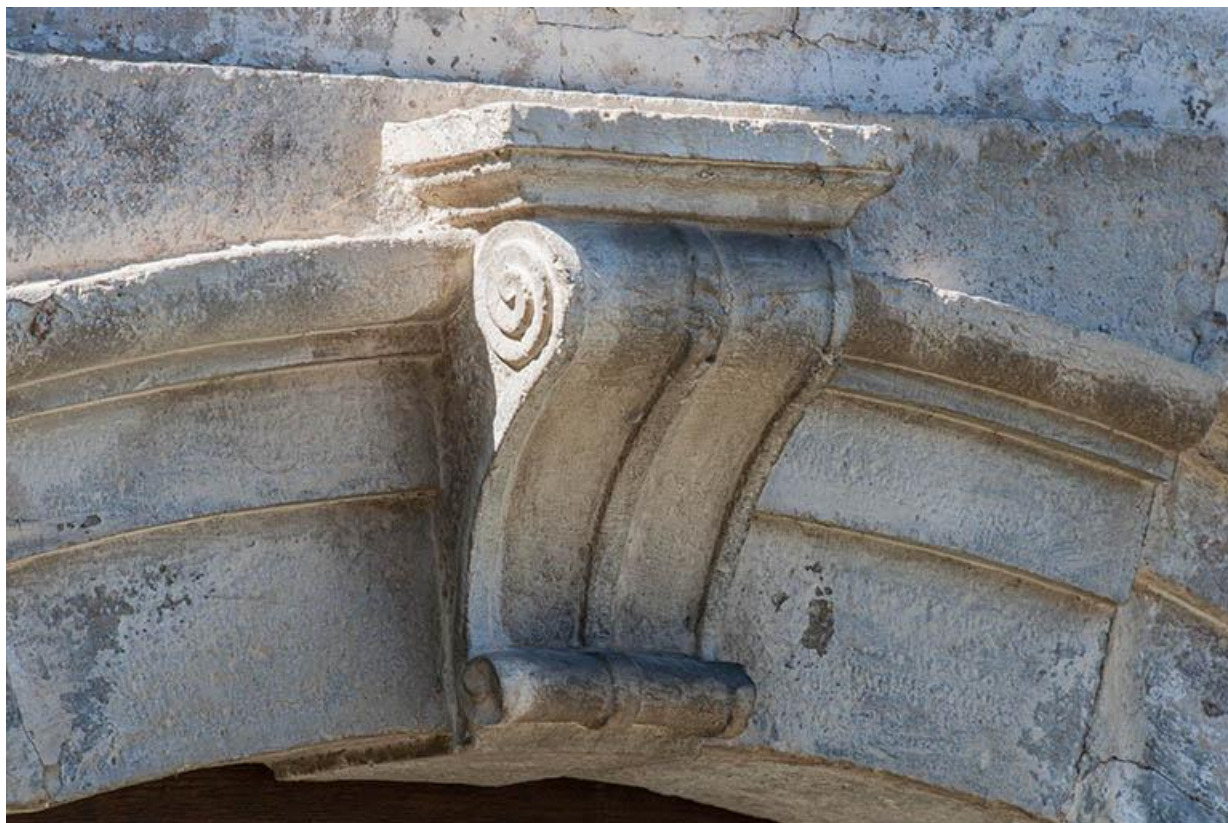
Détail de la porte 70, Gy Grande Rue
