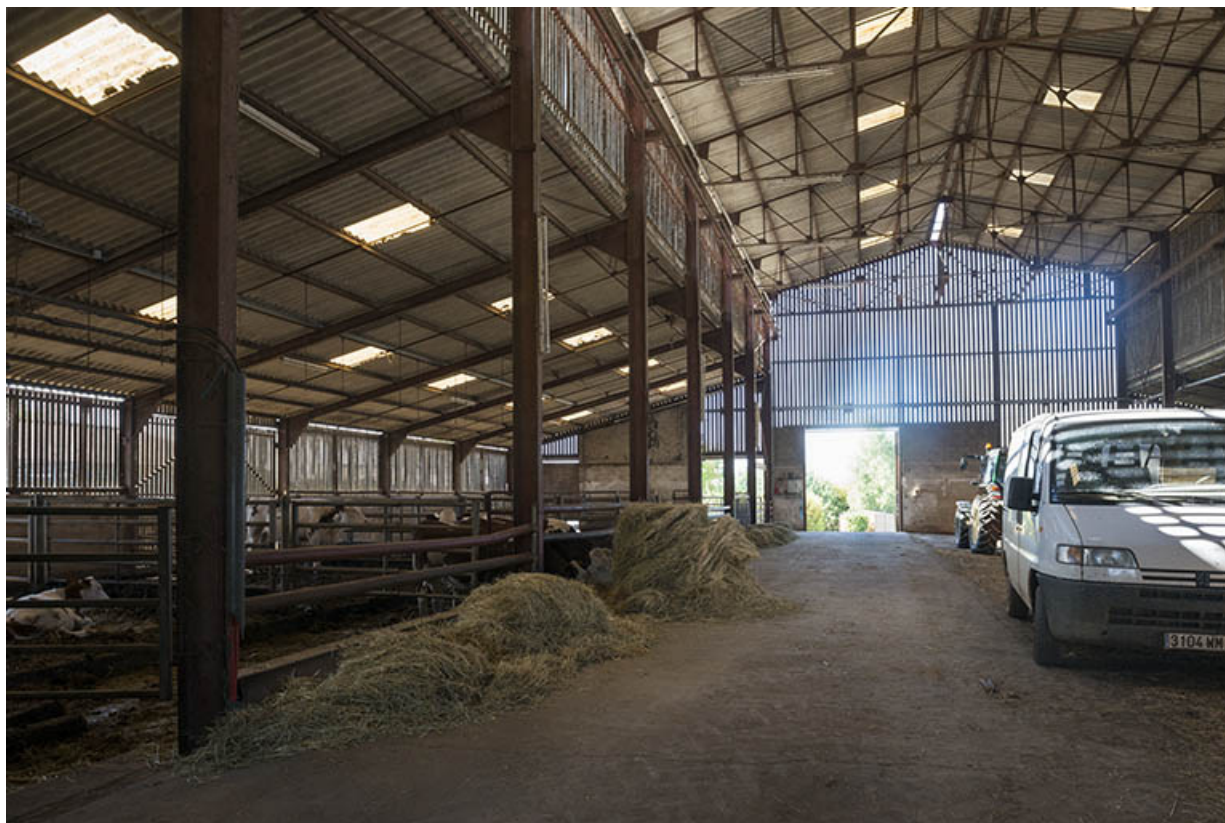
Vue intérieure du bâtiment d'exploitation, d'élevage ovin et bovin.
