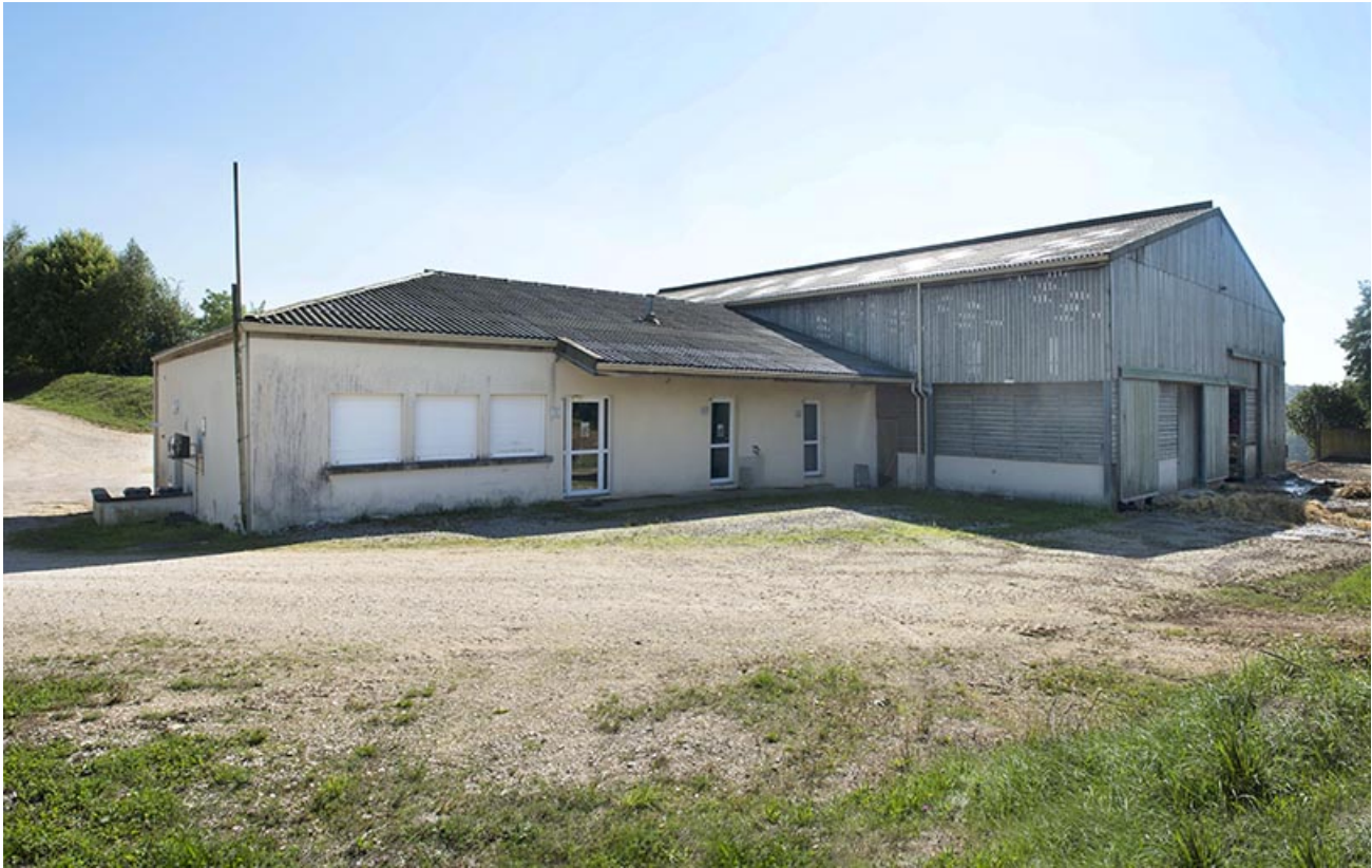
Angle nord-ouest du bâtiment de production laitière.
