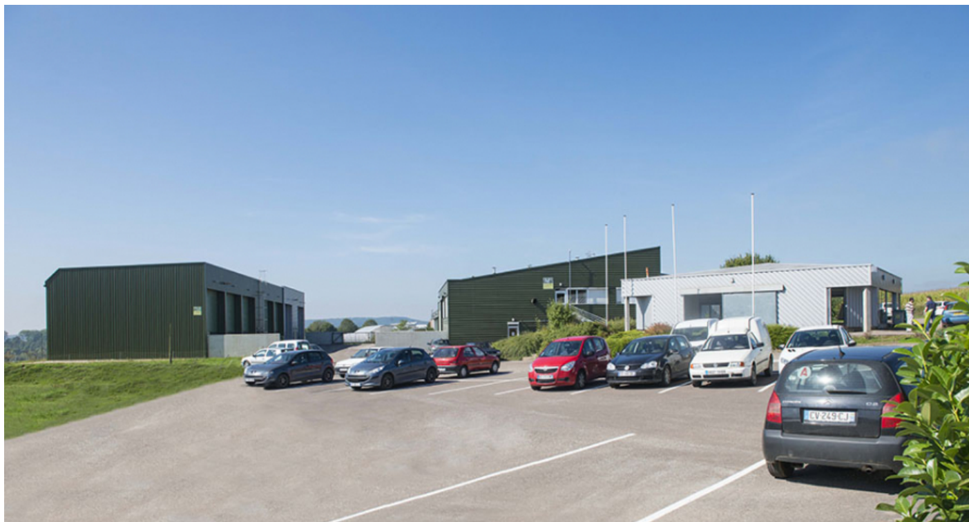
Aire de stationnement, façades est de la halle du machinisme au sud, du hall d'exposition et de la halle d'agroéquipement, au nord. 70, Port-sur-Saône route de Bougnon, lieudit : aux boules
