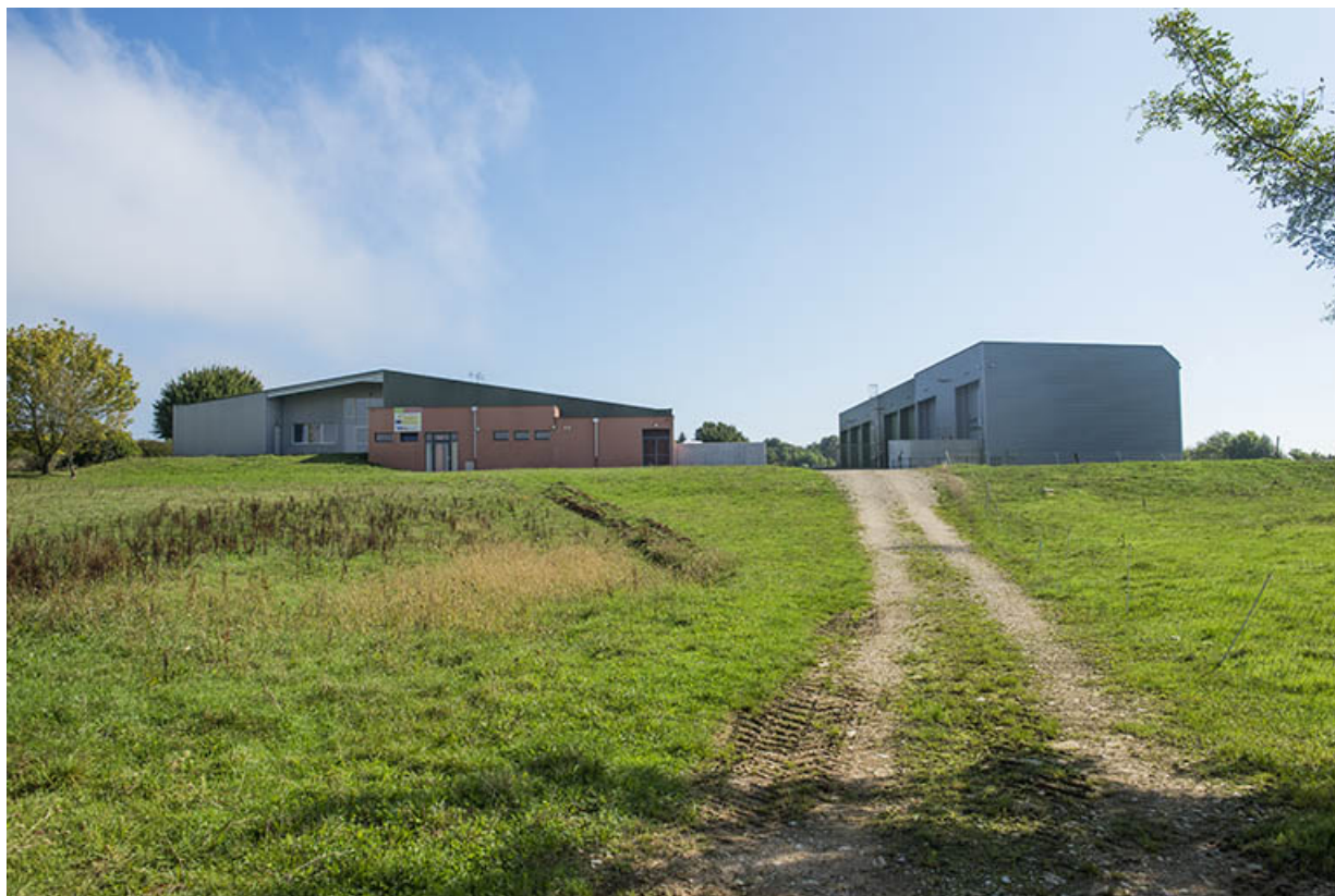
Vue d'ensemble, depuis les serres, à l'ouest.
