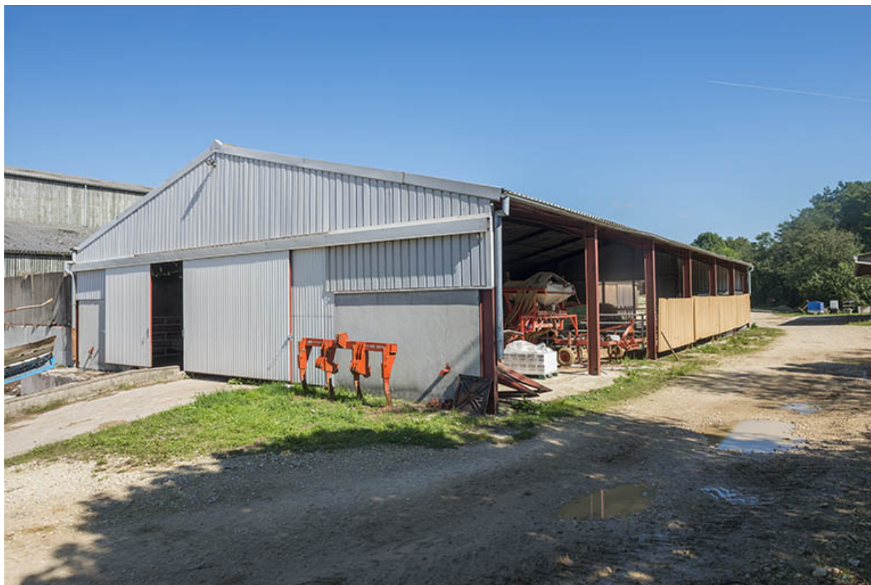
Angle sud-ouest du hangar d'élevage bovin et ovin, stabulation libre.
