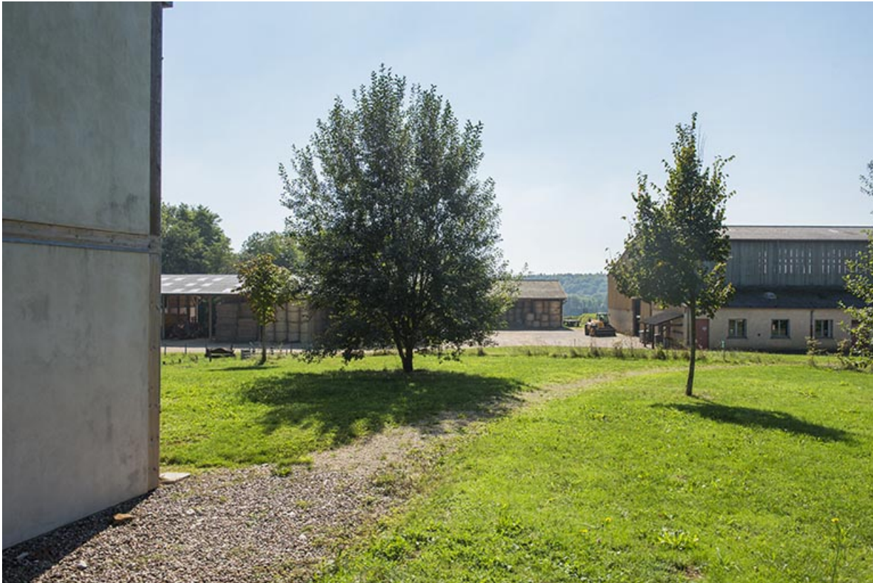
Façades nord des hangars, vues du flanc ouest de la maison verte.
