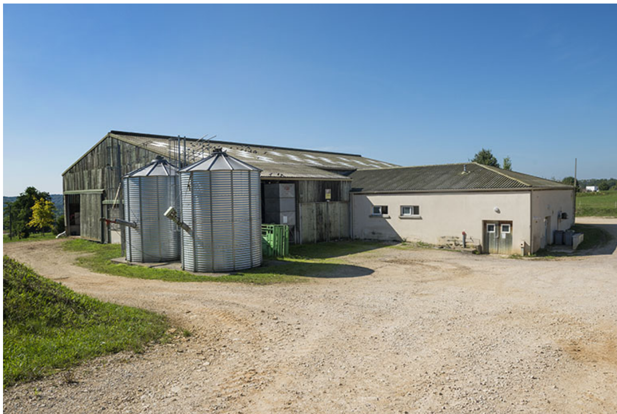
Façade est du bâtiment de production laitière.
