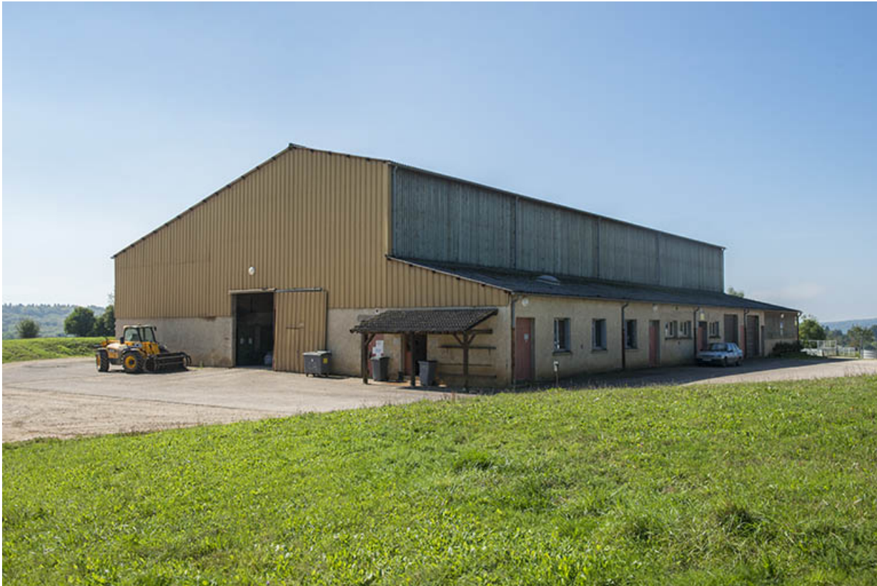
Angle nord du bâtiment d'exploitation d'élevage bovin et ovin.
