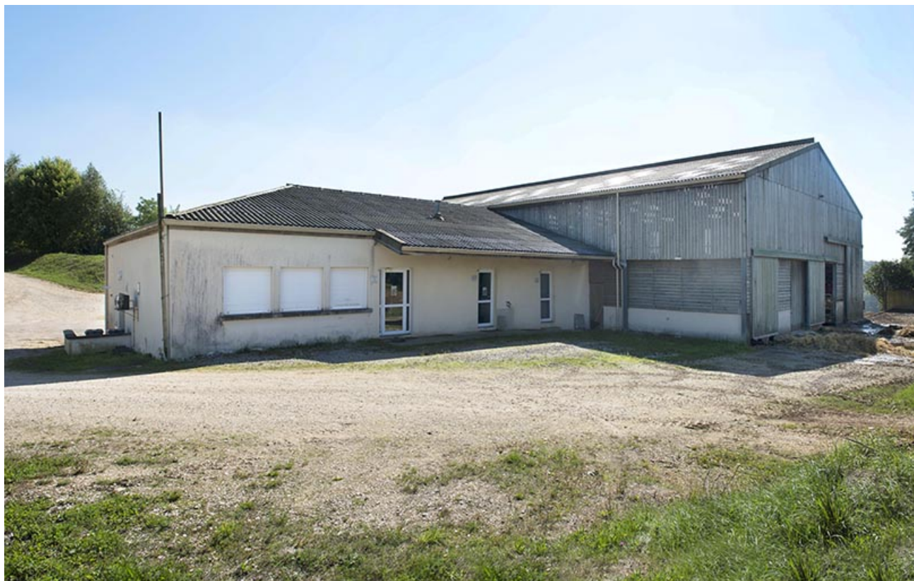
Angle nord-ouest du bâtiment de production laitière.
