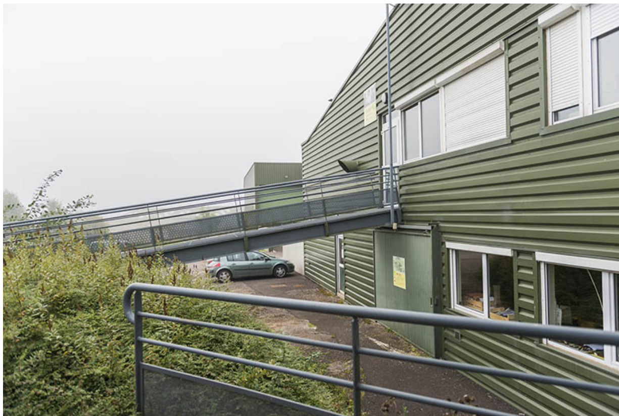
Détail de la passerelle sur le pignon est de la halle d'agroéquipement.
