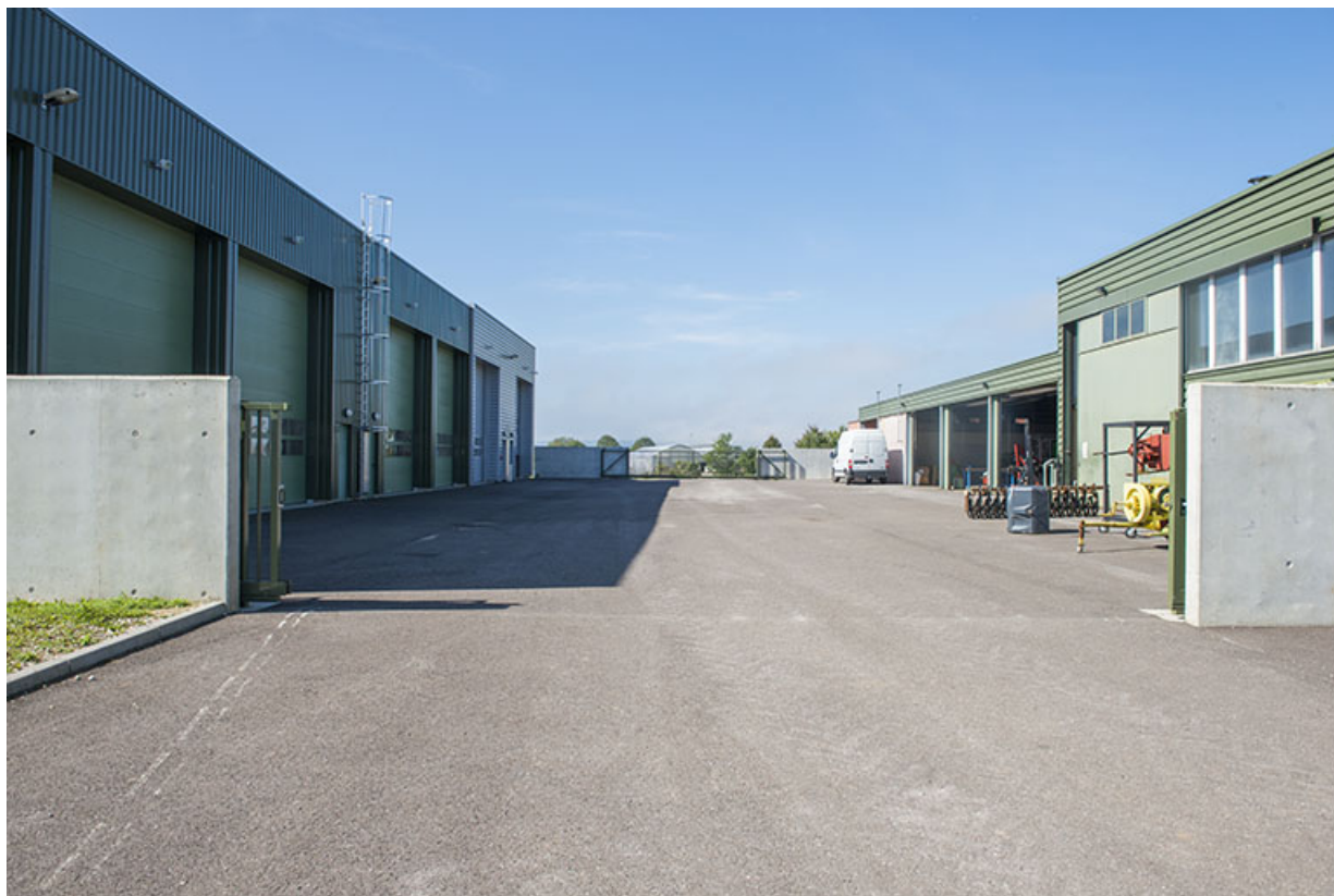
Cour et façade nord des halles de machinisme au sud et et façade sud de la halle d'agroéquipement au nord. 70, Port-sur-Saône route de Bougnon, lieudit : aux boules
