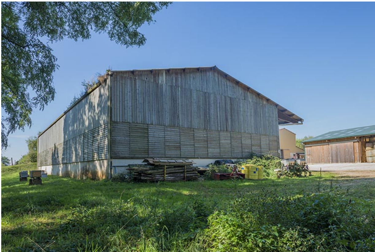
Angle sud-est du hangar à fourrage sud-est et ruches au sud.
