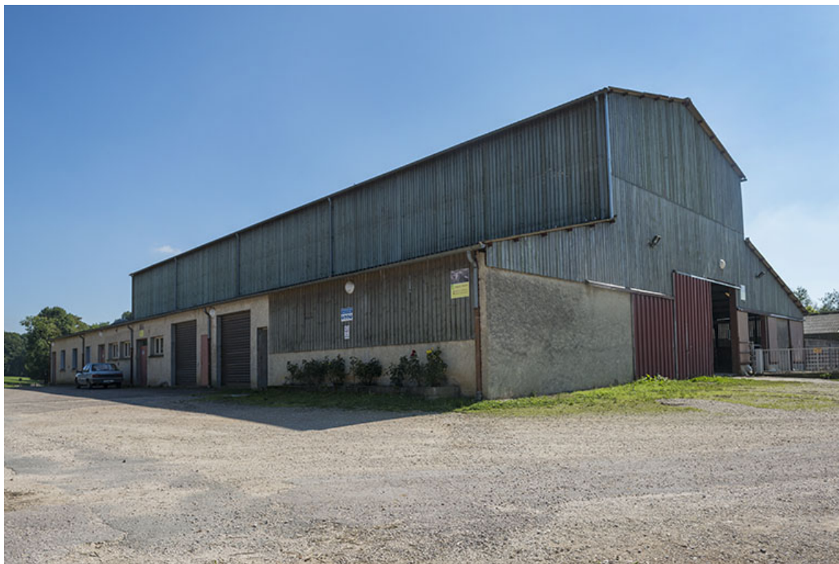
Angle ouest du bâtiment d'exploitation d'élevage bovin et ovin.
