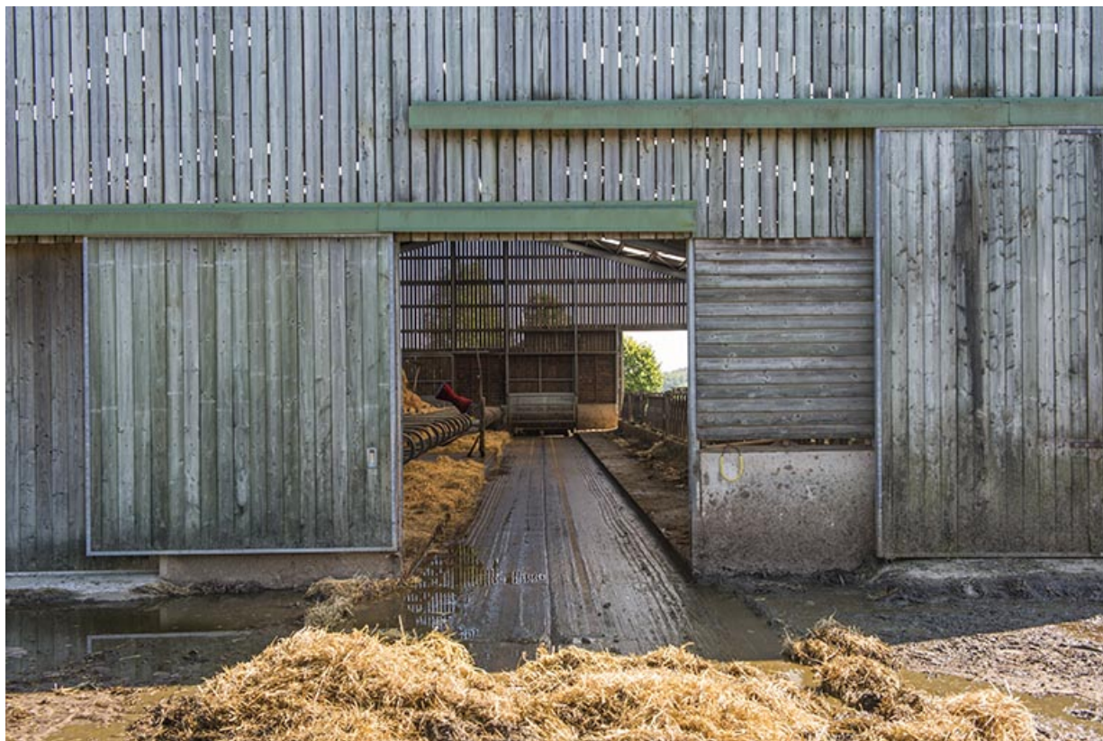
Détail de l'entrée ouest du bâtiment de production laitière.
