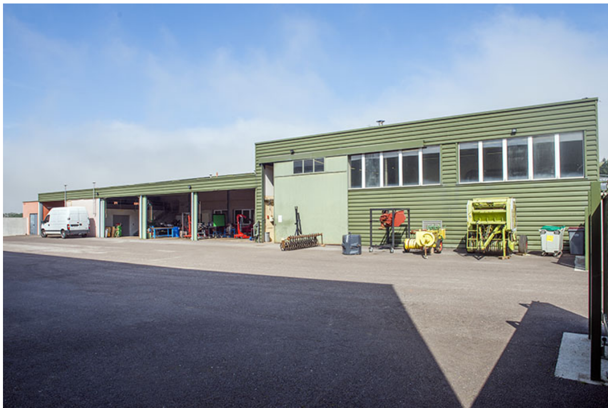
Façade antérieure sud de la halle d'agroéquipement.
