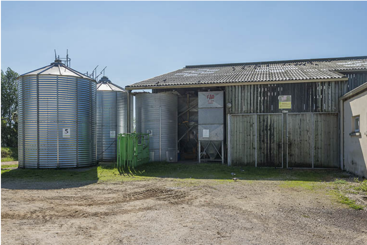
Angle nord-est du bâtiment de production laitière.
