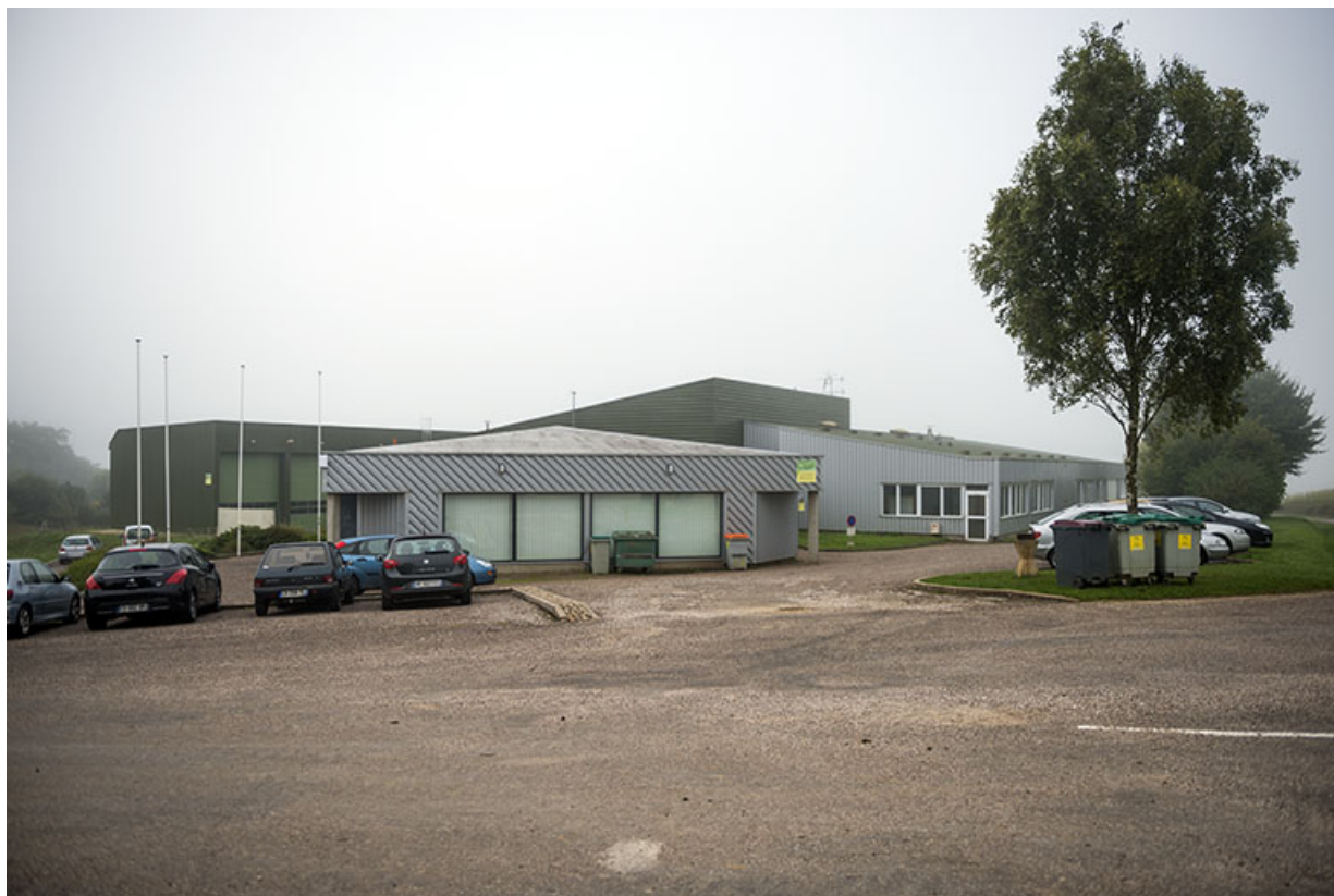
Façade nord-est du hall d'exposition.
