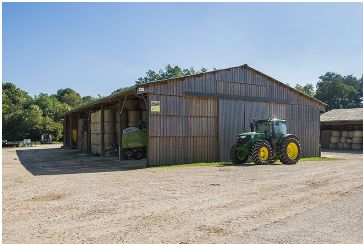
Angle nord-ouest, pignon ouest du hangar à matériel est.
