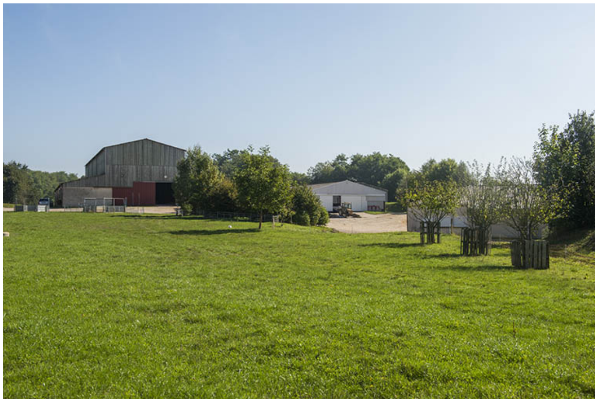
Vue d'ensemble des façades ouest des bâtiments d'exploitation.
