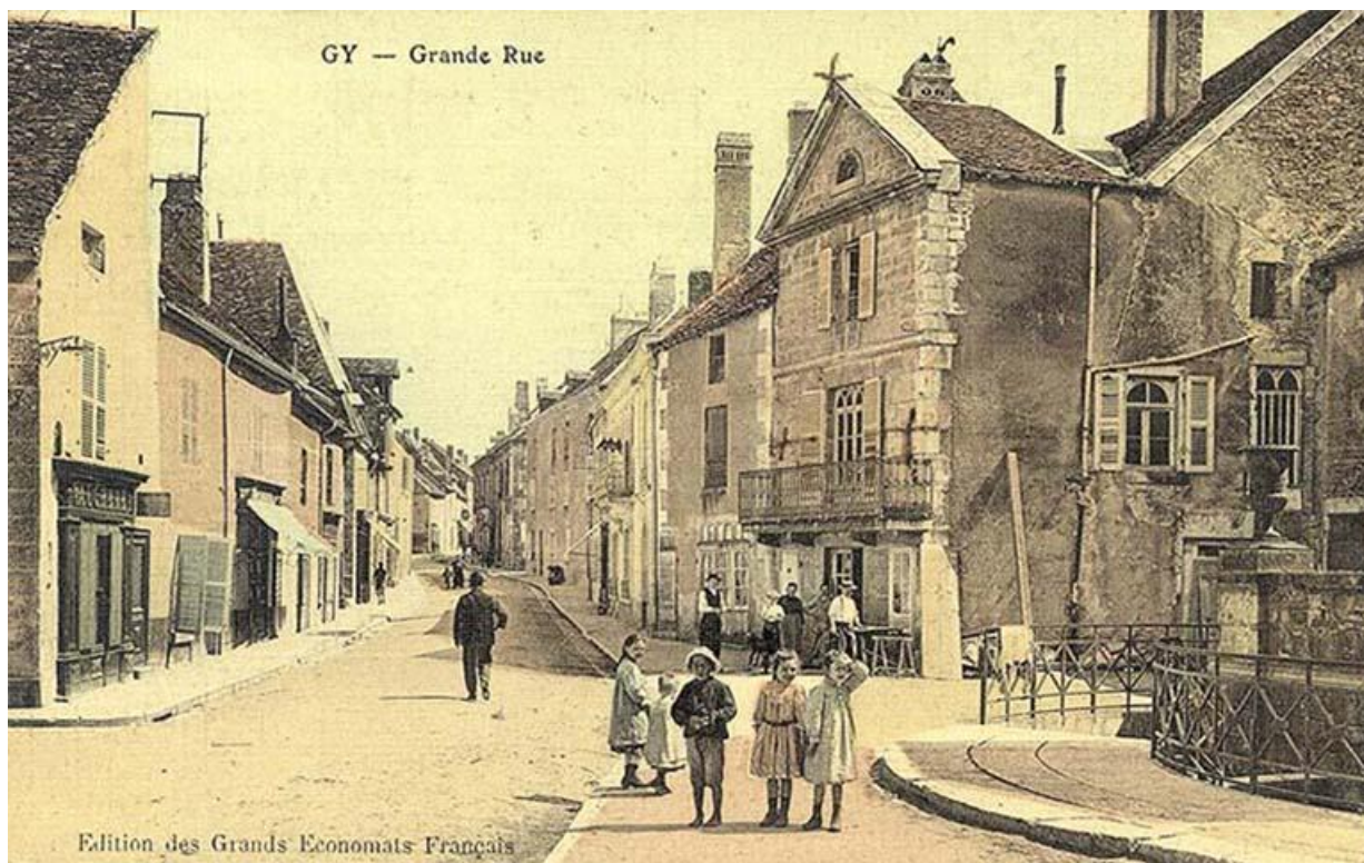
Le bâtiment sur une carte postale ancienne 70, Gy
