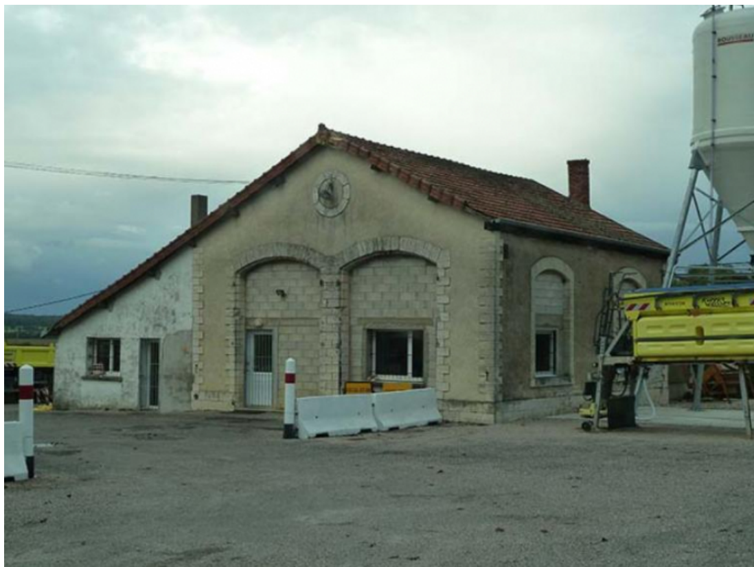
Bâtiment de l'ancienne gare
