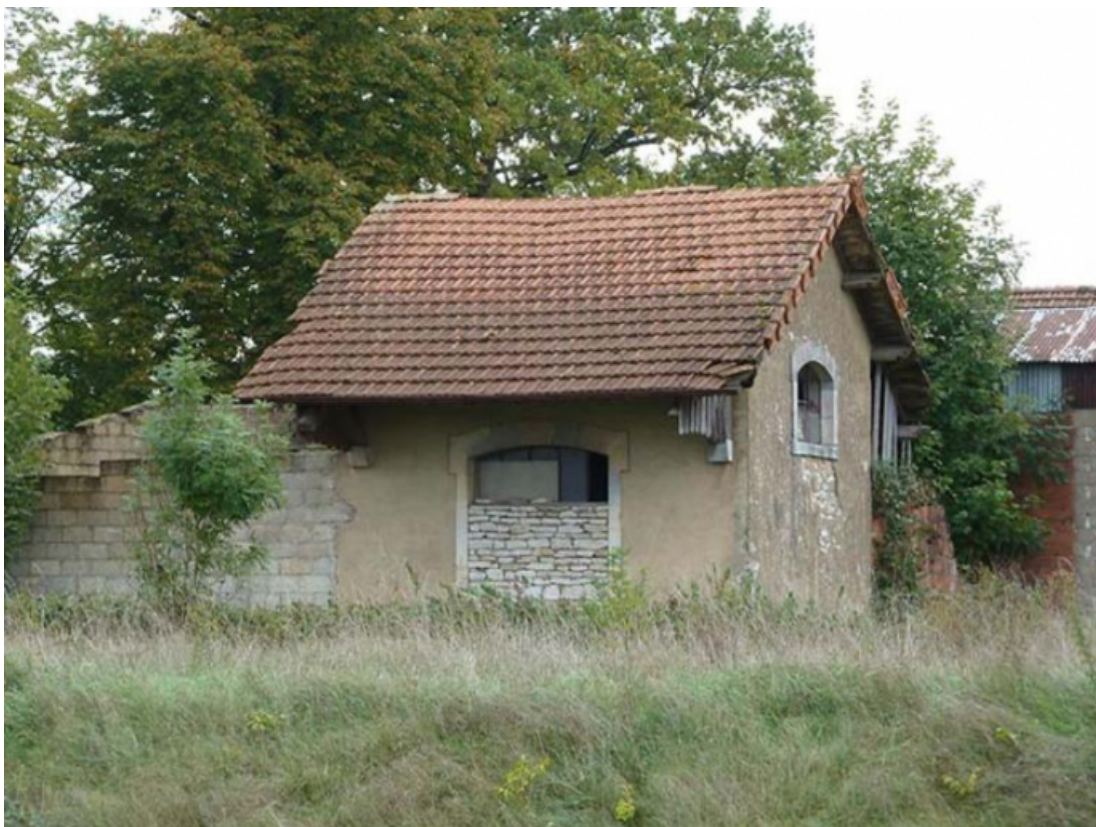
Bâtiment de l'ancienne gare
