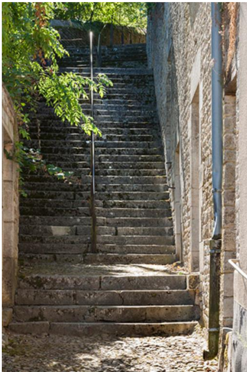
Escalier menant de la Grande Rue au château 70, Gy
