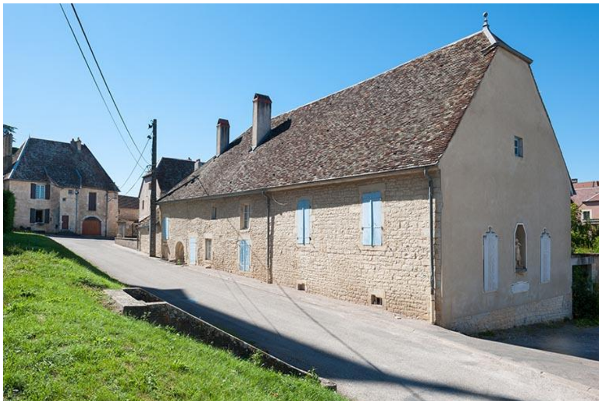
Ancienne ferme située rue Ménans 70, Gy
