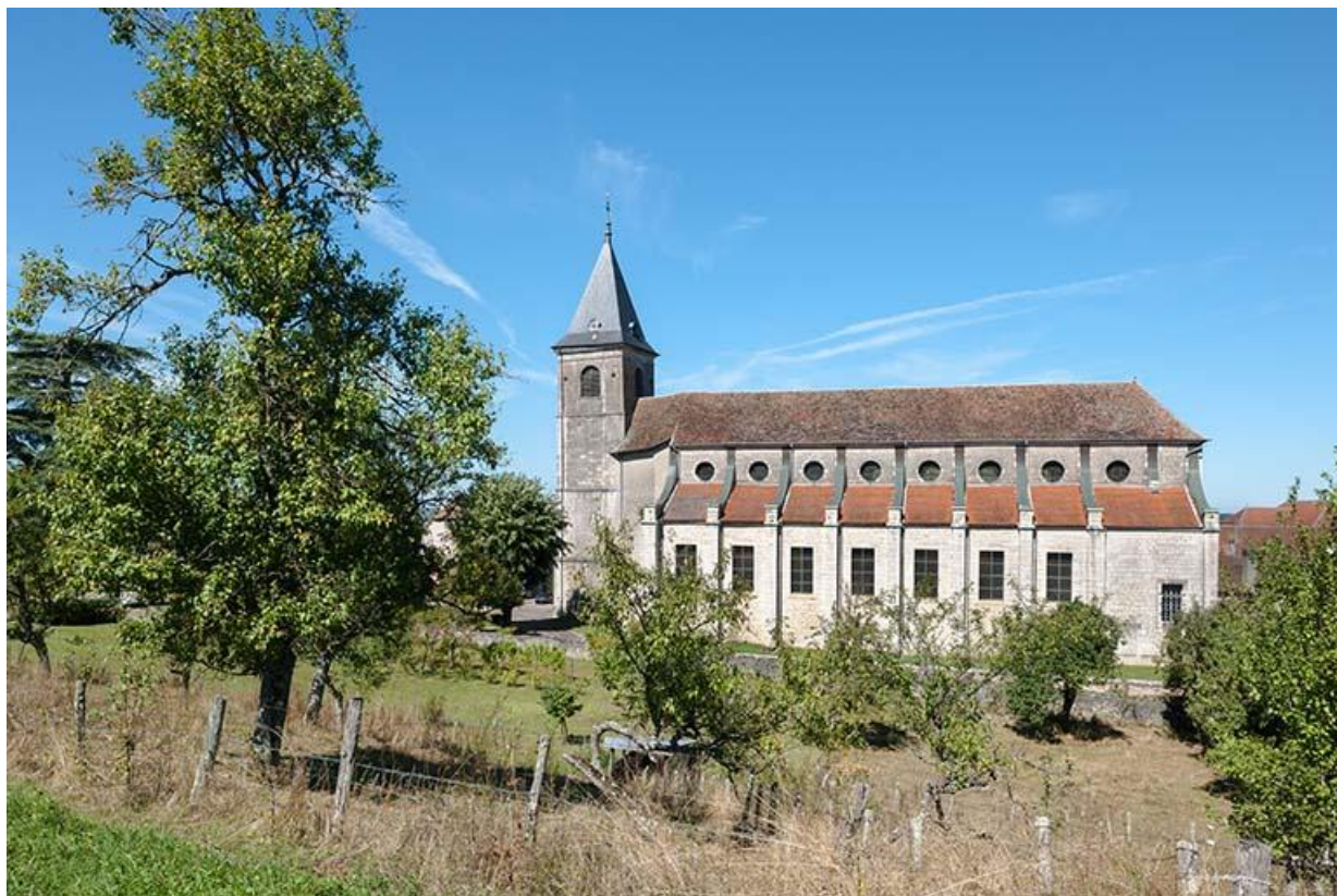
Vue générale sud de l'église 70, Gy
