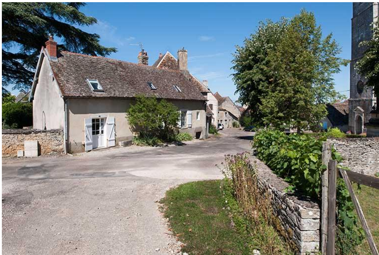
Bâtiment situé place de l'Eglise 70, Gy
