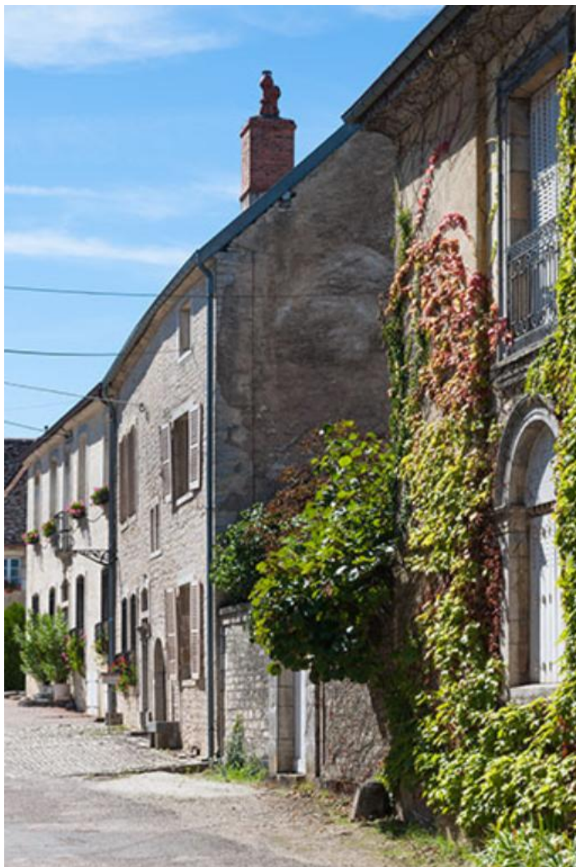
Rue du Bourg, vue depuis l'est 70, Gy
