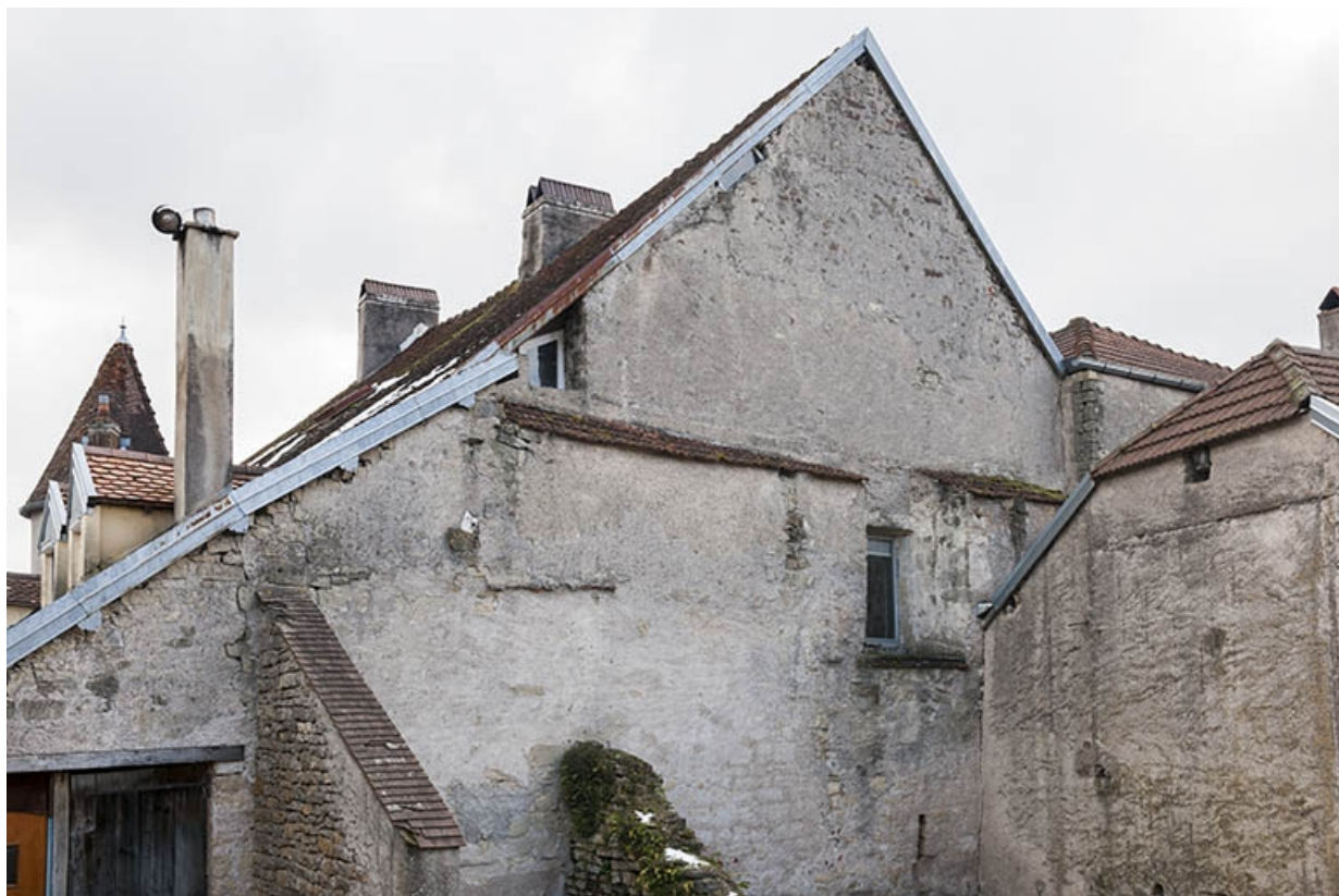
Façade postérieure côté rue Catinat.
