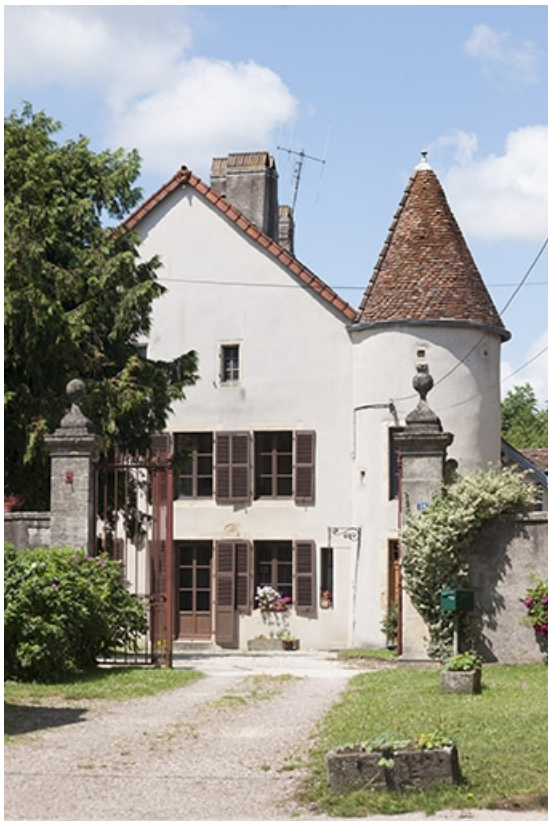
Façade antérieure et tour nord, depuis l'entrée.
