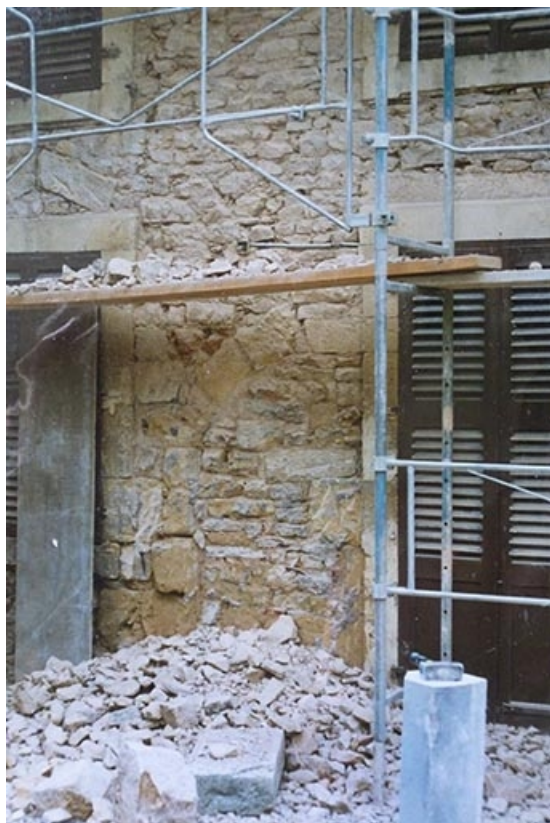
[Recrépissage de la façade antérieure : anciens linteaux du rez-de-chaussée], 1996. 70, Faverney, 39 Grande Rue
