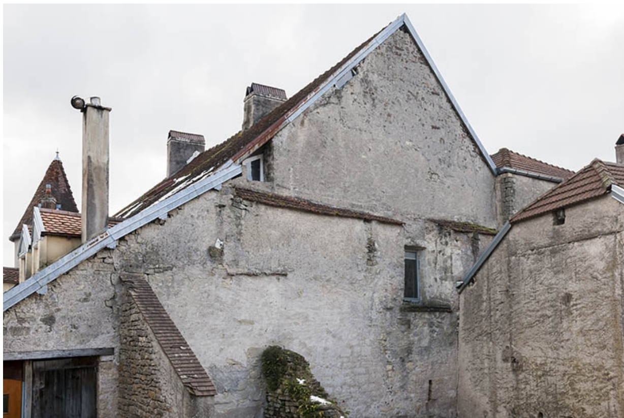
Façade postérieure côté rue Catinat.
