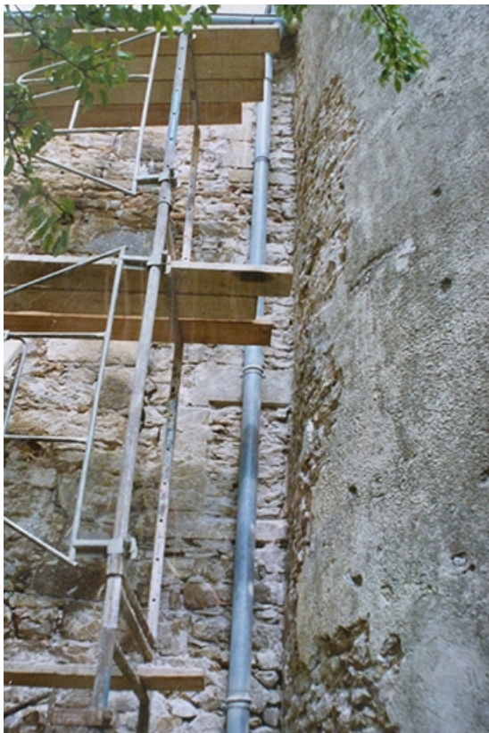
[Recrèpissage de la façade antérieure : baie du 17e siècle au 1er étage], 1996. 70, Faverney, 39 Grande Rue
