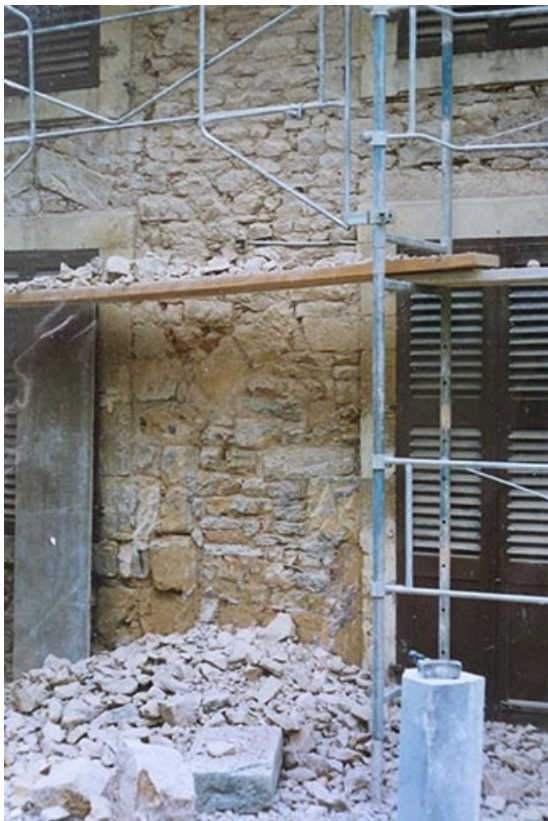
[Recrèpissage de la façade antérieure : anciens linteaux du rez-de-chaussée], 1996. 70, Faverney, 39 Grande Rue
