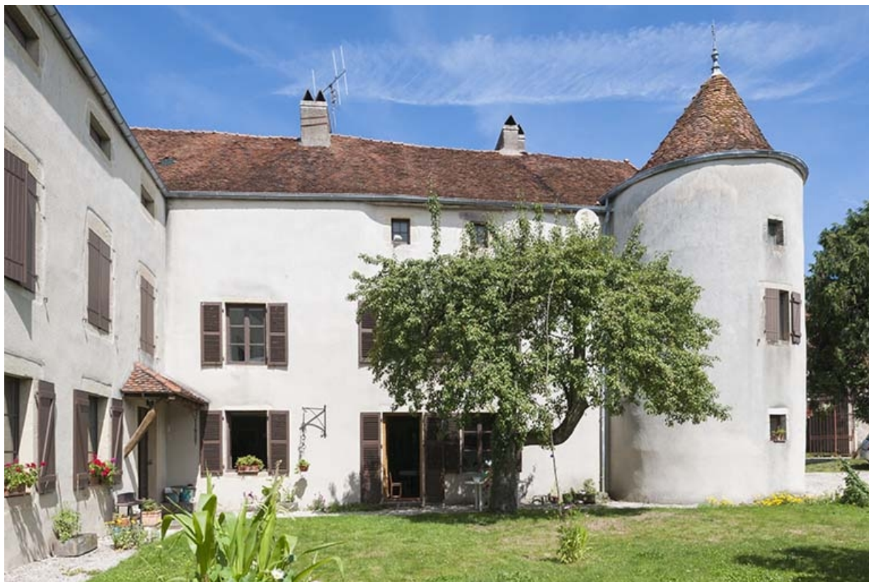
Vue rapprochée du logis et de la tour sud depuis le jardin.
