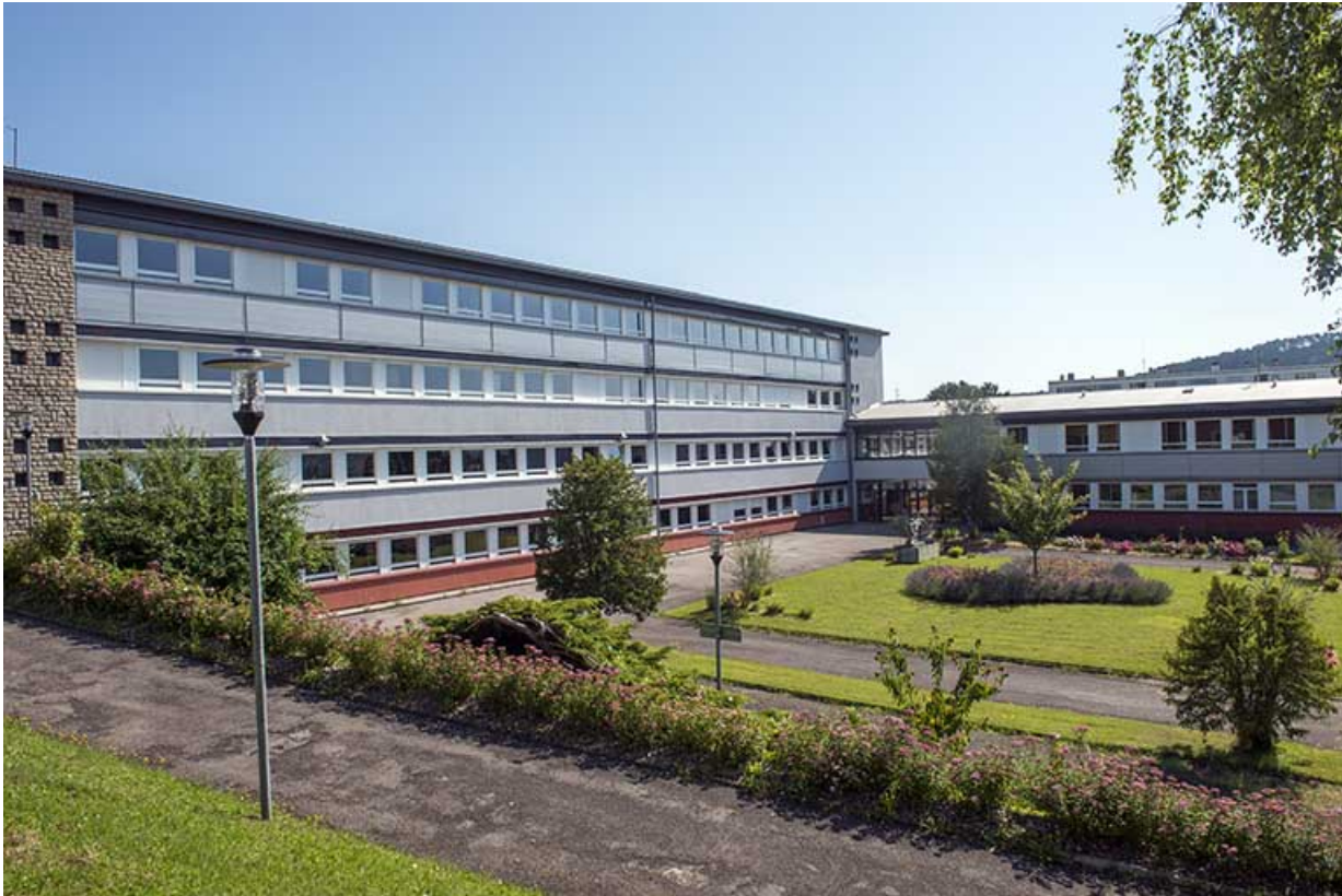
Cour d'honneur entre la façade ouest de l'administration et la façade sud de l'externat.
