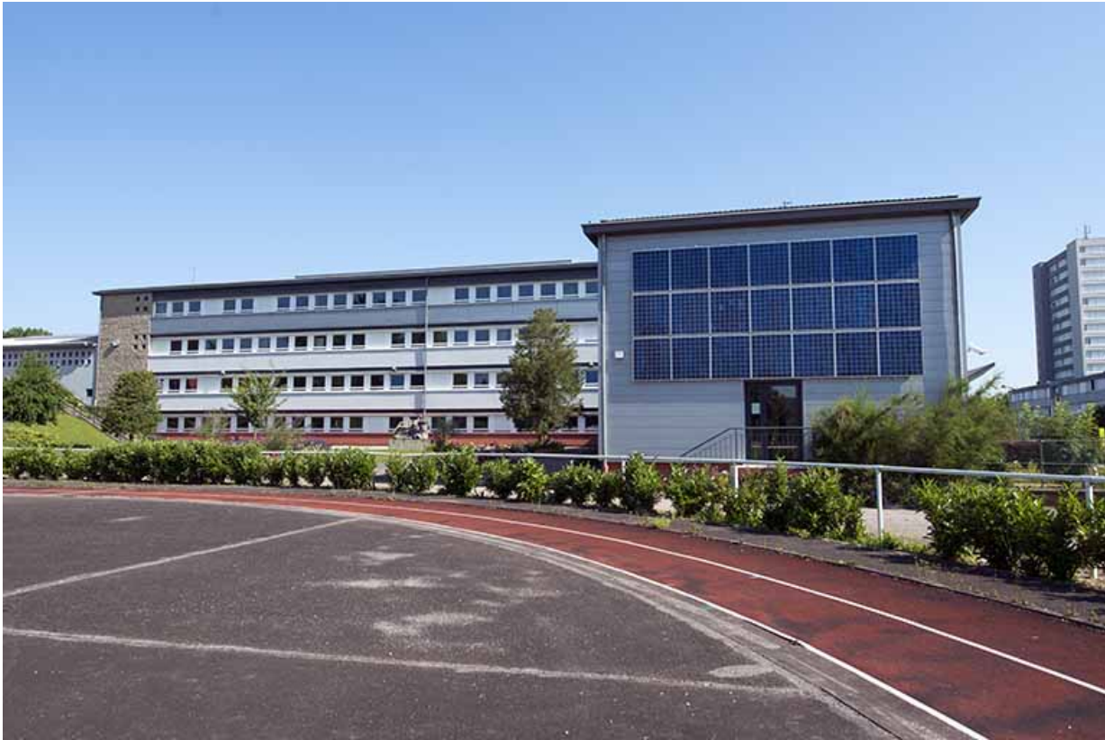
Pignon sud du bâtiment d'administration, façades sud des bâtiments d'externat et du préau.
