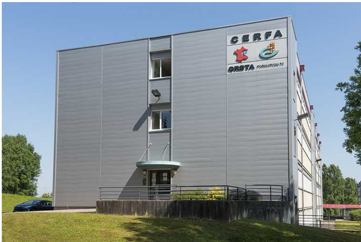
Angle sud-est du bâtiment d'externat et d'internat, dont cette moitié sud abrite le Greta.
