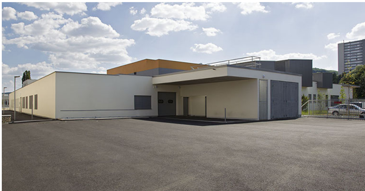
Façades postérieures du pôle hôtelier, vues de trois-quart nord-est.
