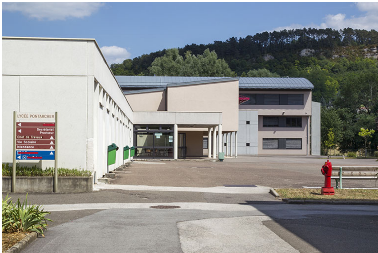
Cour, façade sud de l'externat, façade ouest de l'externat est.
