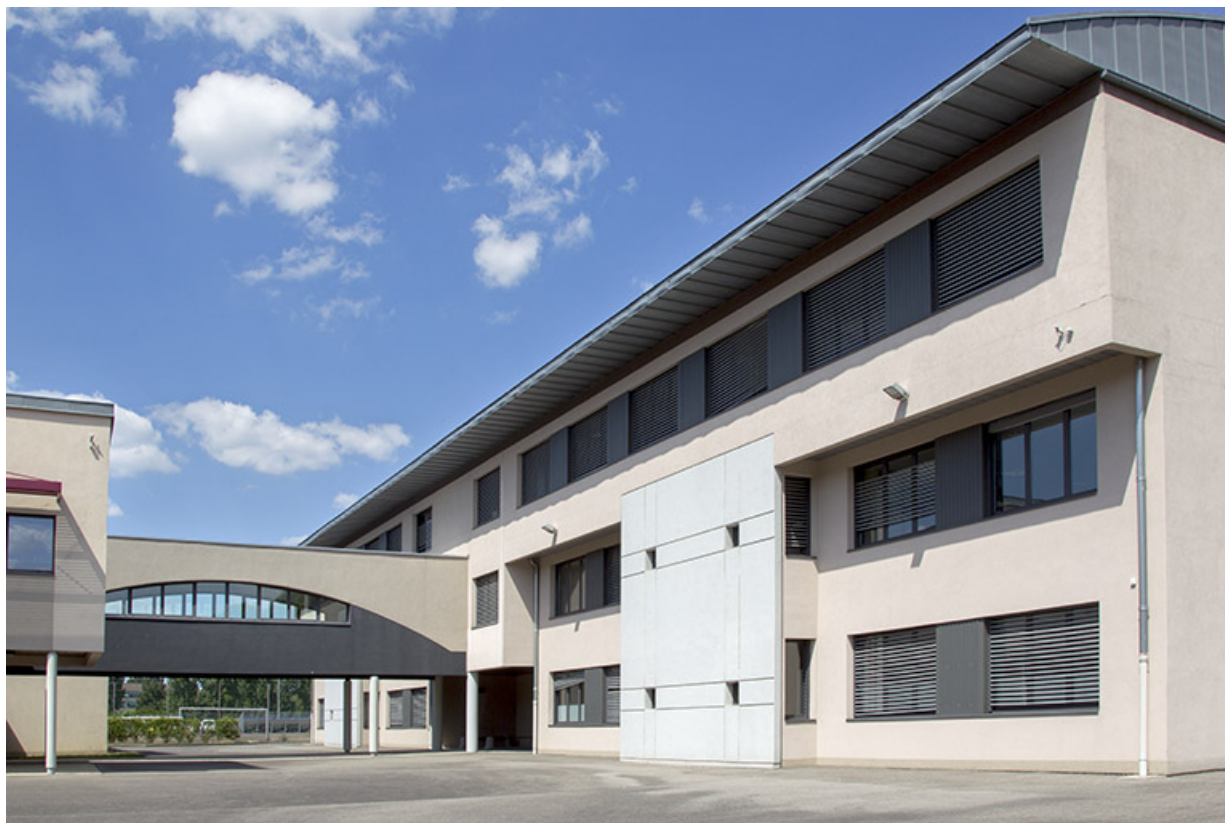
Vue de trois-quart sud-ouest de la façade antérieure de l'externat est et sa liaison aérienne.
