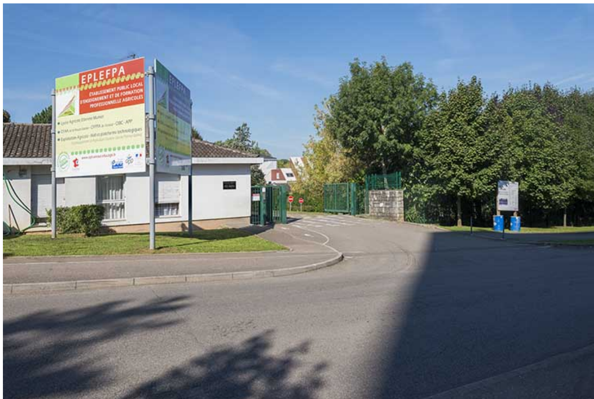
Le long de la rue Belin, garages, entrée des véhicules au nord de la loge.
